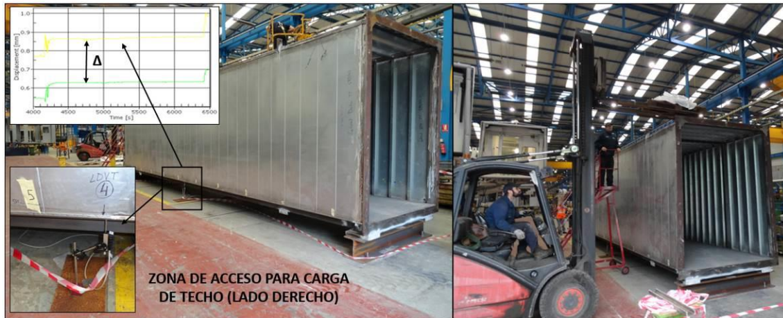
Imagen 47: Ubicación del transductor 4 y zona de acceso para carga de techo.
