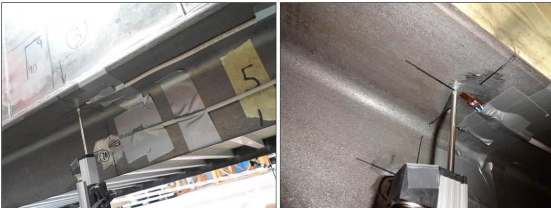
Imagen 35: Galgas del cordón inferior del túnel.
