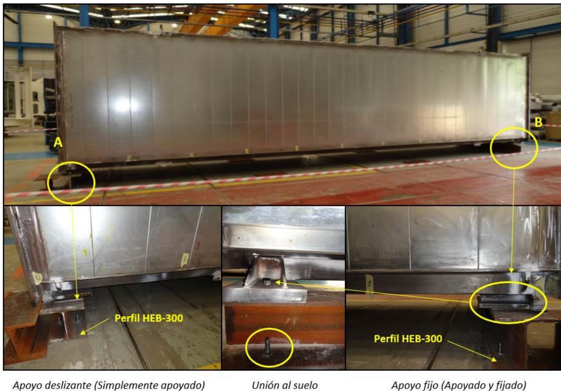
Imagen 22: Detalle de los apoyos de la estructura.
