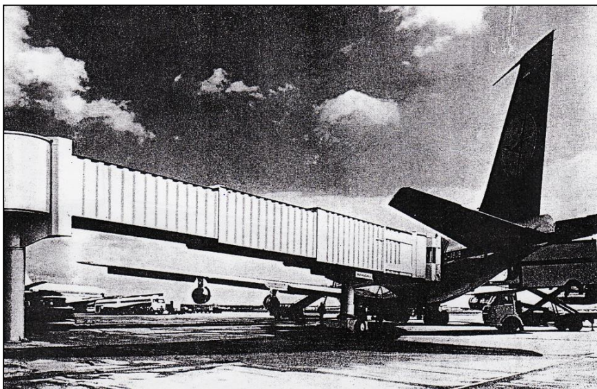
Imagen 1: Pasarela de embarque Henschel atracando a un avión en el aeropuerto de Frankfurt (1968).
