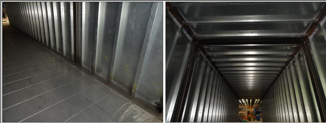
Imagen 23: Vistas interiores de la estructura.
