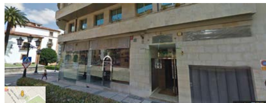
Figura 28. Imagen del edificio donde estará situado el laboratorio. La 1ª planta completa albergará la ampliación del laboratorio químico-toxicológico.
