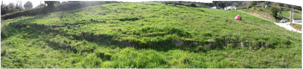
Figura 8.4. Panorámica de una de las grietas principales que atraviesa prácticamente de lado a lado la zona deslizada.
