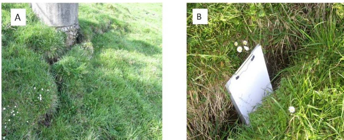
Figura 8.8.a) Grieta en la base de una torre de alta tensión que ha descalzado la estructura; b)Detalle de la grieta
