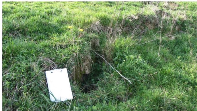
Figura 8.5. Detalle de la grieta de la figura anterior en la que se observa el salto de aproximadamente 30cm entre ambos bloques
