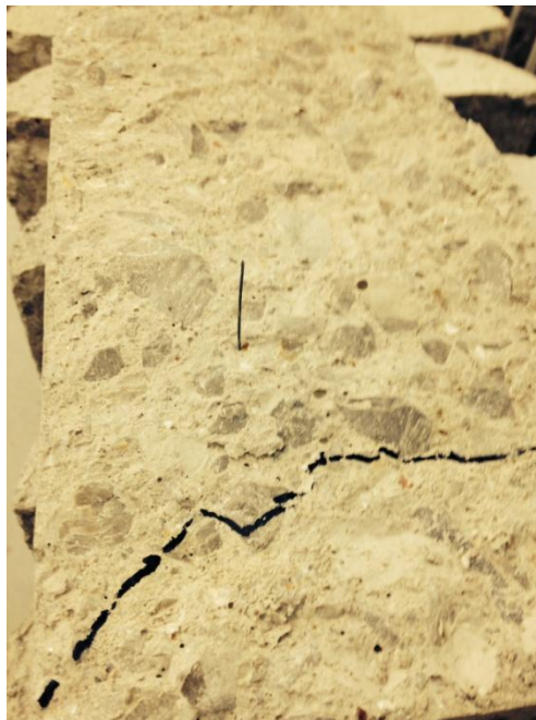
Fig. 41: Incidencia ocurrida por presencia de fibra de acero en composite hormigón con fibra de vidrio AR
