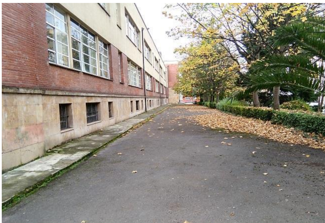
Foto 56. Fachada lateral pabellón nuevo I.E.S. Alfonso II
