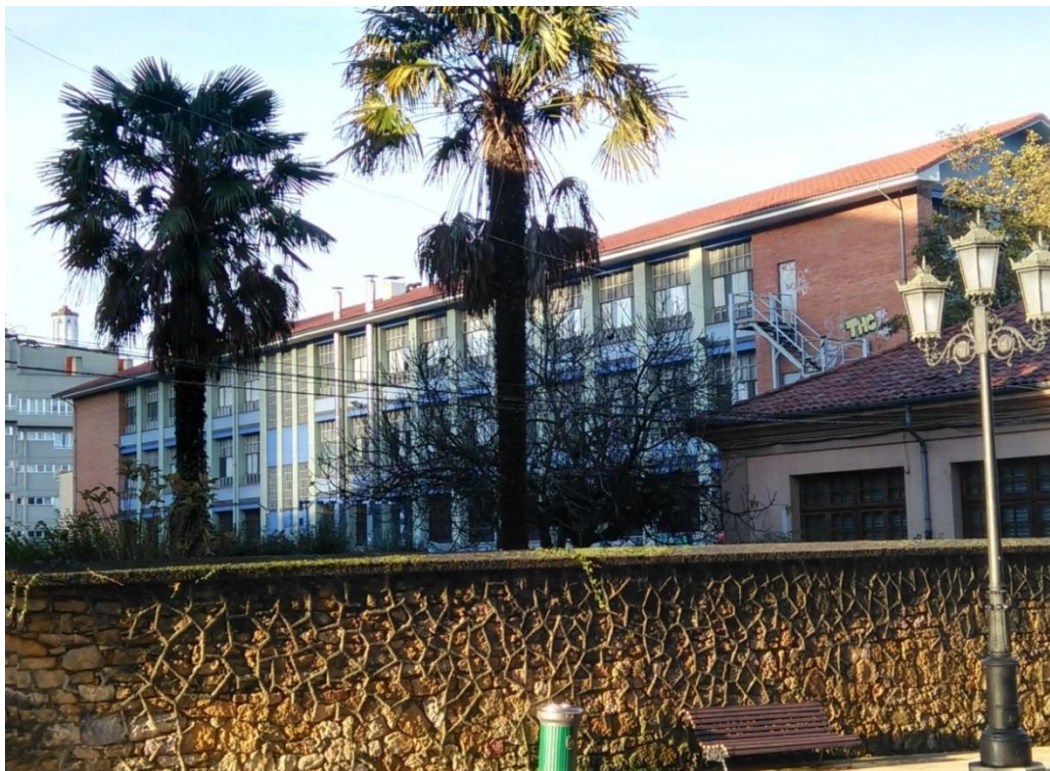
Foto 6. Pabellón nuevo (vista exterior desde la calle Pérez de la Sala)
