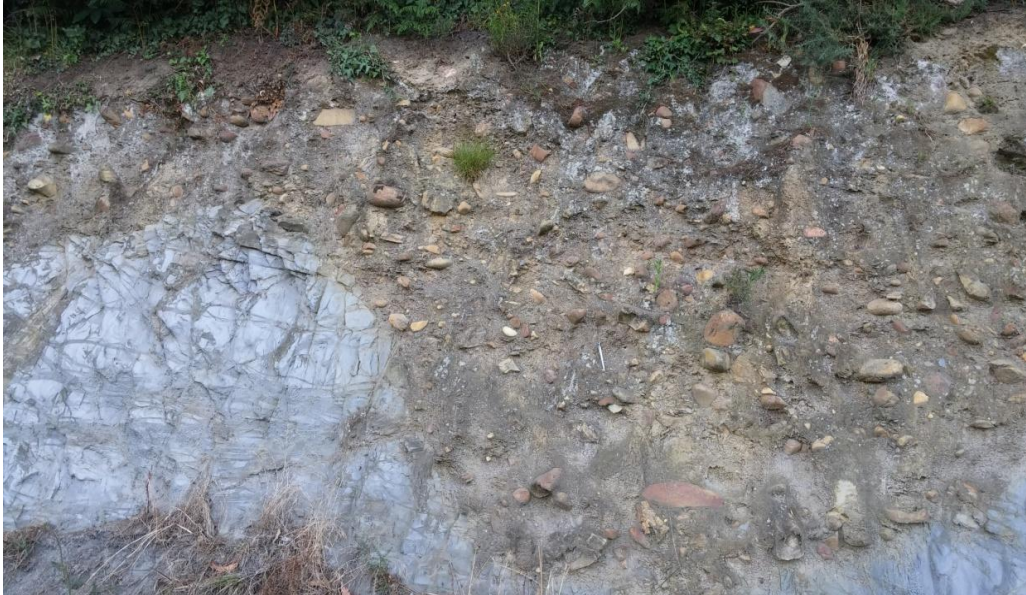
Figura 3.10.- Apreciación de los depósitos conglomeráticos de terraza sobre las Pizarras de Luarca en un talud de 3 metros en la Carretera Nacional N-634.
