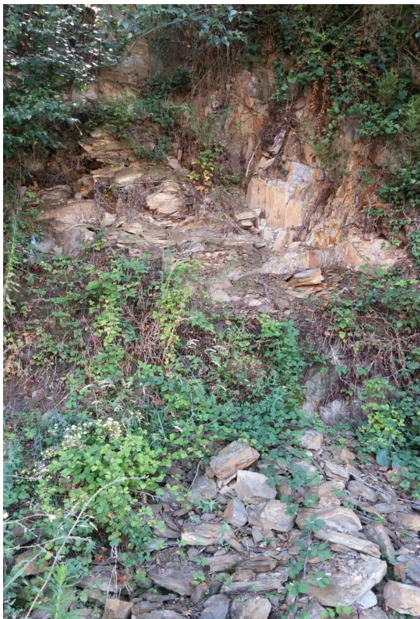
Figura 3.22.- Fotografía de un desprendimiento rocoso a favor de las discontinuidades principales en la zona de la estación de tren (“Las Cortes”).
