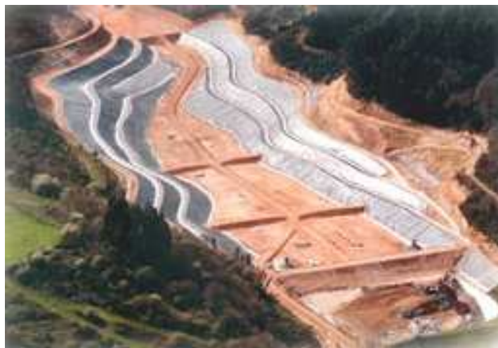
Figura 11. Vista general del depósito de seguridad de COGERSA.
