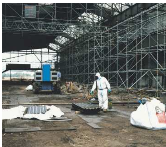
Figura 3. Operaciones de retirada de amianto de una instalación industrial.
