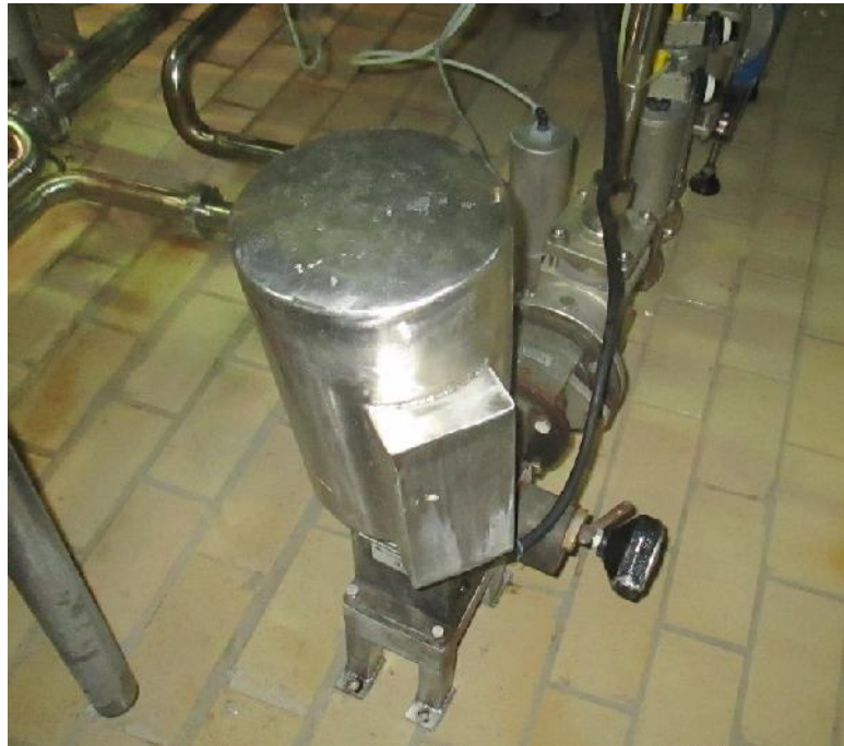
Ilustración 12: Bomba de Inyección de Fermentos a Línea de Siembra N°1
