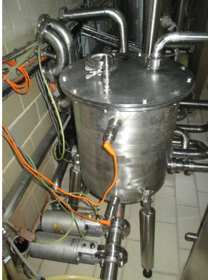
Ilustración 20: Deposito de Siembra para la Línea de Siembra N°2
