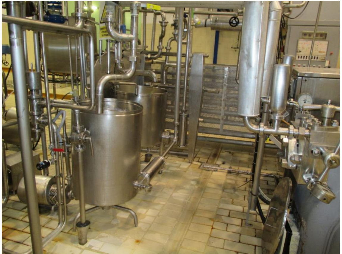
Ilustración 2: Depósitos de Almacenado de Leche para Pasteurizar (BTDs)
