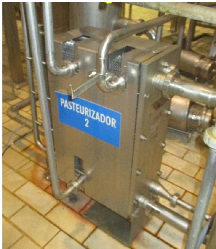
Ilustración 7: Primer Conjunto de Placas Intercambiadoras de Calor del Pasteurizador N°2
