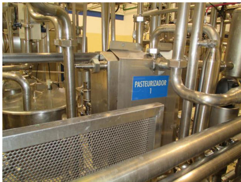
Ilustración 6: Conjunto de Placas Intercambiadoras de Calor del Pasteurizador N°1
