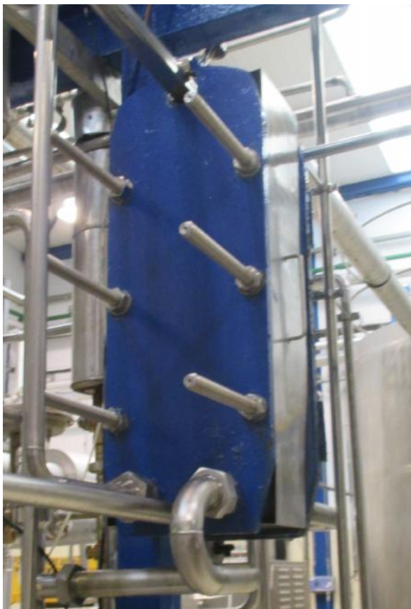
Ilustración 8: Segundo Conjunto de Placas Intercambiadoras de Calor del Pasteurizador N°2.
