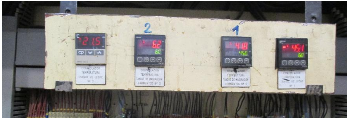
Ilustración 26: Tarjetas de Control de Temperatura de Tanques de Fermento N°1 y N°2
