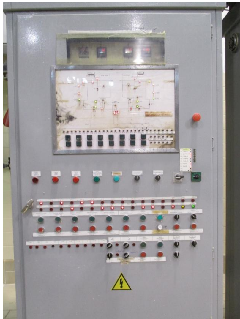
Ilustración 25: Armario de Control de Líneas de Siembra y Cultivo de Fermentos
