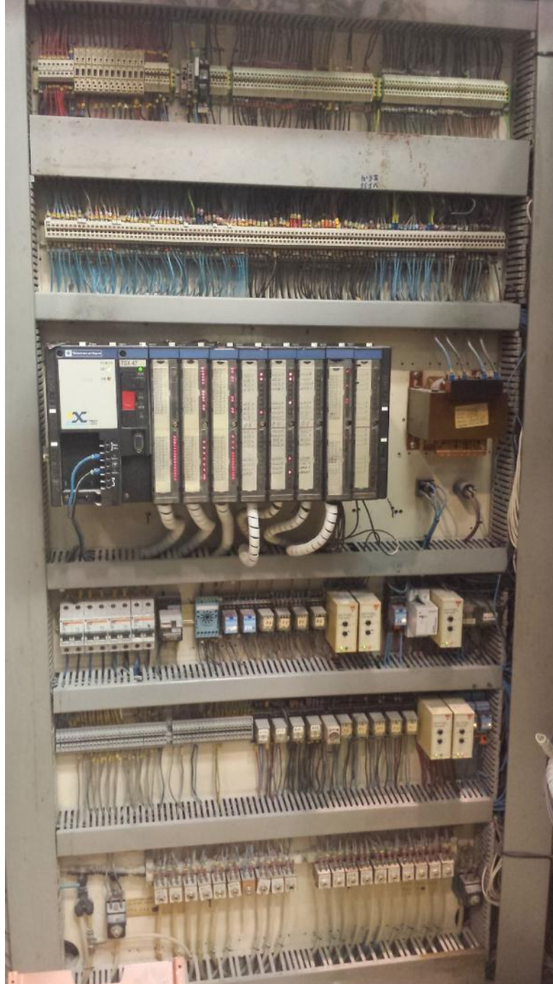
Ilustración 28: Cuadro Eléctrico de Armario de Control de Líneas de Siembra y Cultivo
