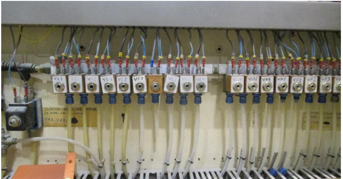
Ilustración 30: Electroválvulas Neumáticas para la Apertura o Cierre de Válvulas de las Líneas de Siembra y Cultivo de Fermentos
