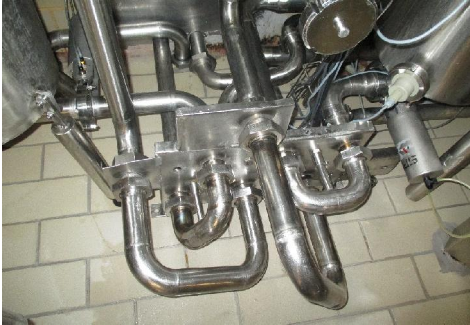
Ilustración 21: Bloque Multivías para Distribución de Leche Sembrada a las Maquinas Llenadoras y para Limpieza CIP
