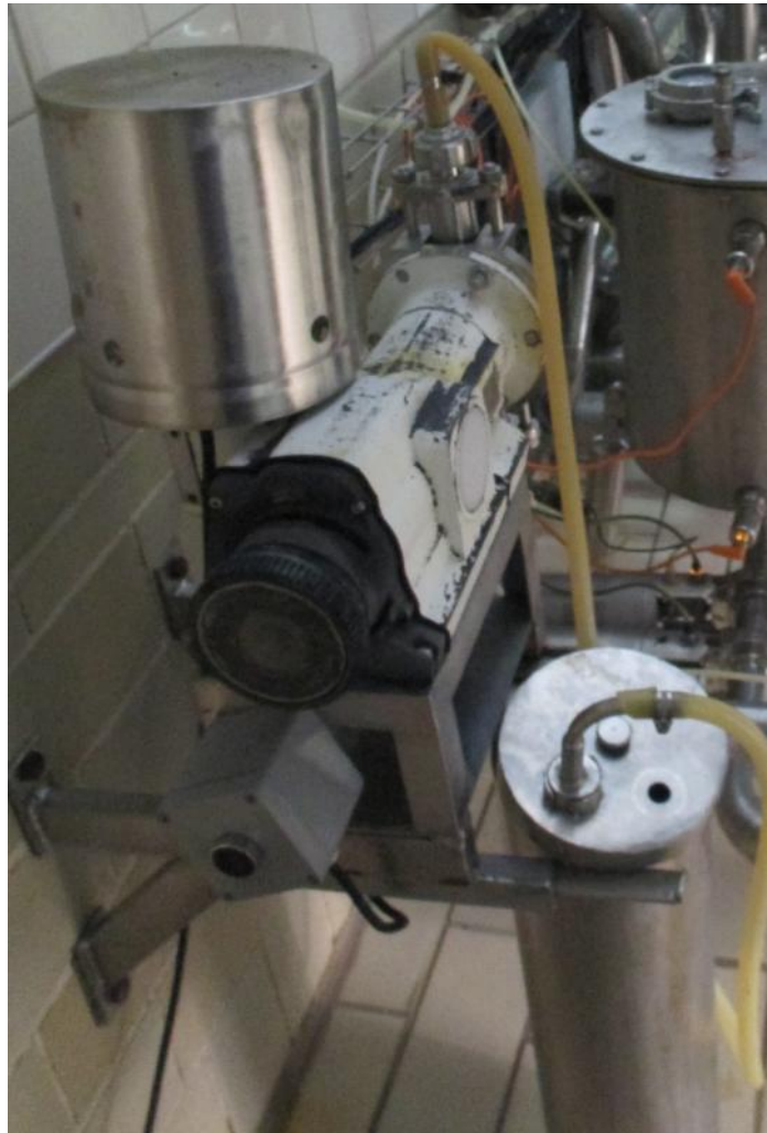
Ilustración 19: Bomba de Inyección de Aromas en Línea de Siembra N°1
