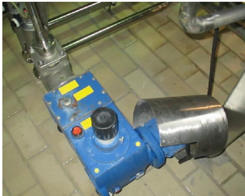
Ilustración 13: Bomba de Inyección de Fermentos a Línea de Siembra N°2
