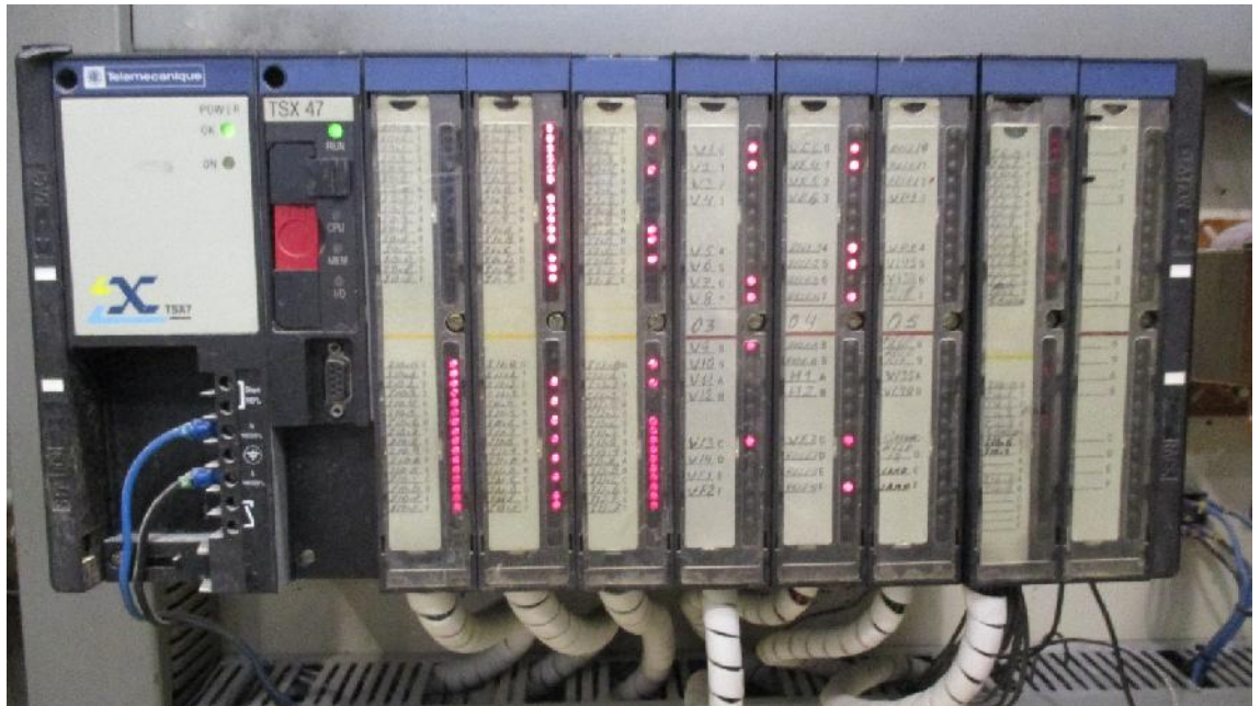
Ilustración 29: Autómata para el Control de Líneas de Siembra y Cultivo Actualmente Operativo
