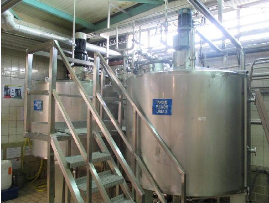
Ilustración 15: Tanques Pulmón de Almacenamiento de Leche Pasteurizada
