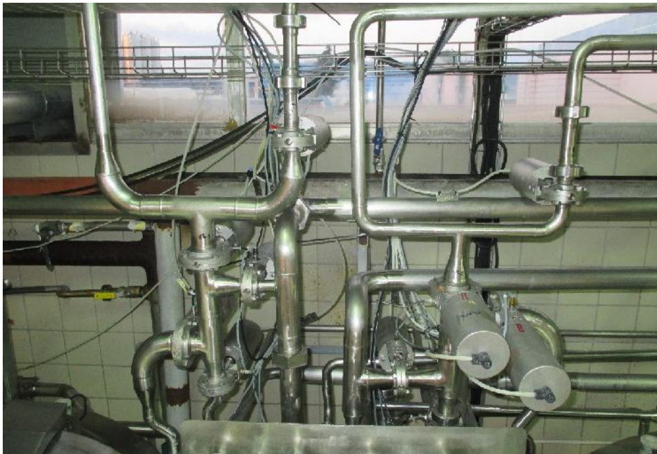
Ilustración 16: Circuito de Tuberías y Válvulas para el Paso de Leche Pasteurizada
