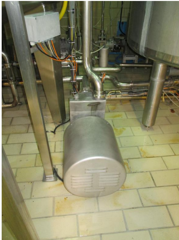
Ilustración 14: Bomba CIP para recirculación de Limpieza en Líneas de Cultivo de Fermento
