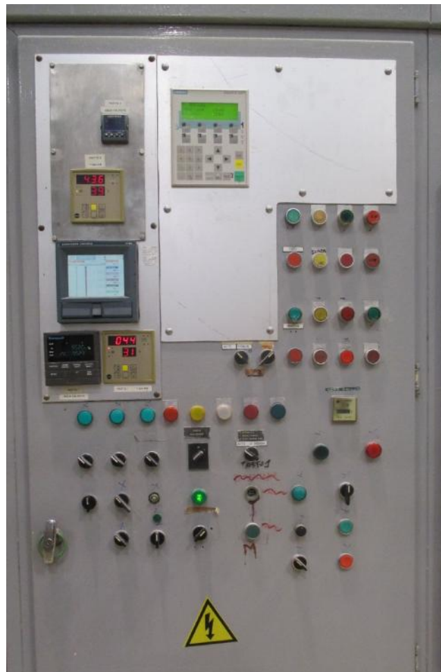
Ilustración 23: Armario de Control de Líneas de Pasteruzación
