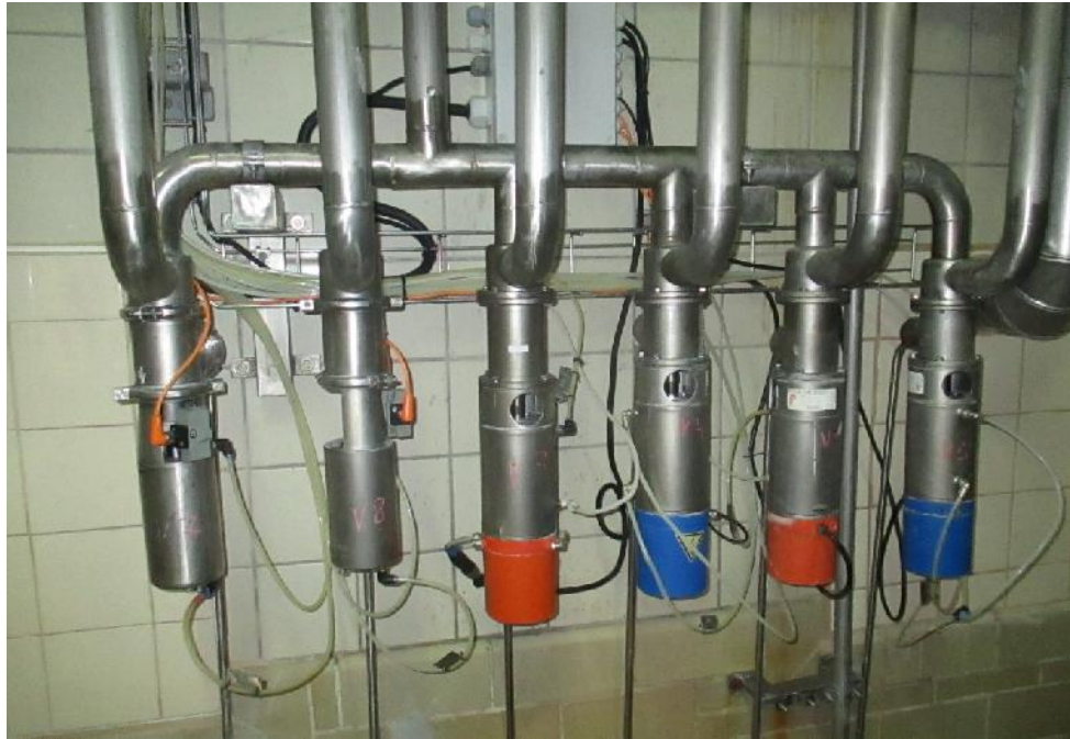
Ilustración 22: Válvulas que Distribuyen el Material de Limpieza CIP
