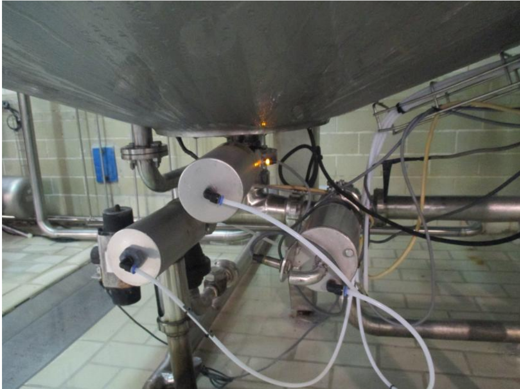
Ilustración 10: Válvulas para el Vaciado y Distribución del Contenido del Tanque de Fermentos N°1
