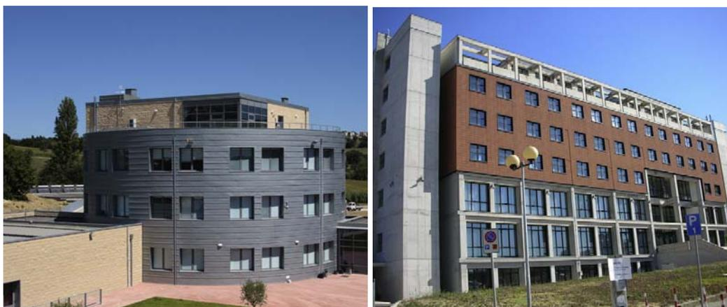
*Figura 2.7 Imagen de los edificios monitorizados: fachadas ventiladas metálicas (derecha) y fachadas ventiladas cerámicas (izqda.). Fuente: Stazi et al. (2014).*
