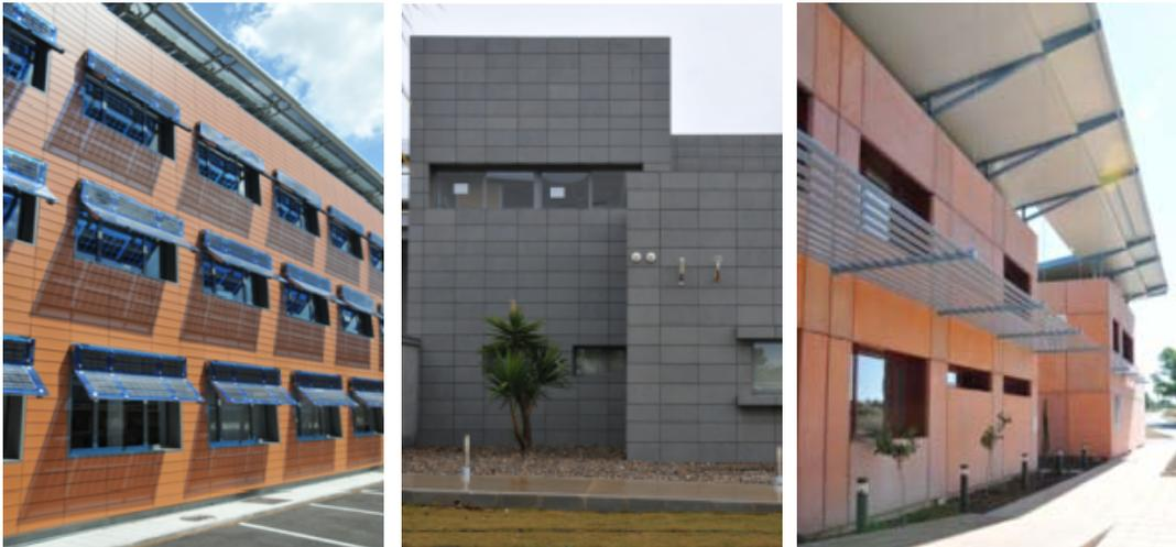
*Figura 1.3 Imágenes de las fachadas ventiladas instaladas en el proyecto ARFRISOL: CDdI CIEMAT (izqda.), CDdI CIESOL (centro) y CDdI CEDER (dcha.).*
