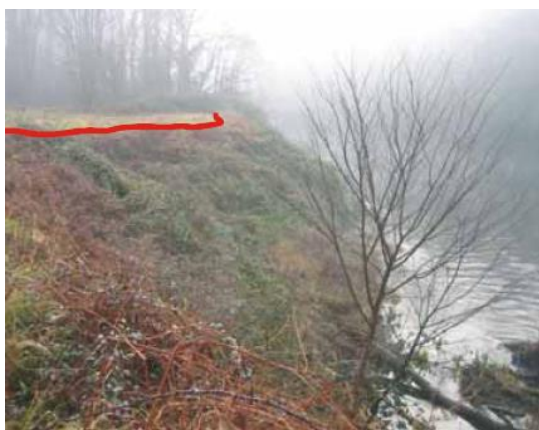
Figura 7. La línea roja marca el dominio público hidráulico ubicado en la coronación del talud de la orilla (tomado de MARM, 2009).
