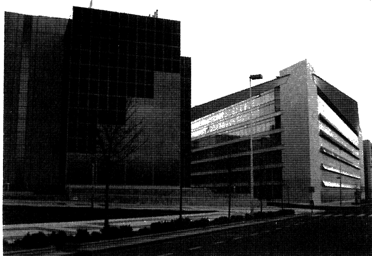
Fig. 1.- Ejemplo de edificios con fachadas acristaladas en Madrid.
