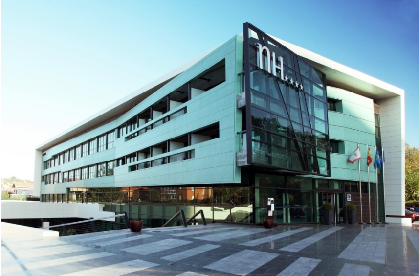
Hotel NH. Fotografía cedida por el arquitecto Fernández Morán.
