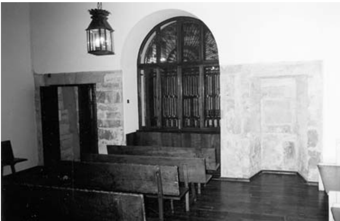
Sacristía interior. Arquitectura: Melchor de Velasco, 1657-58
