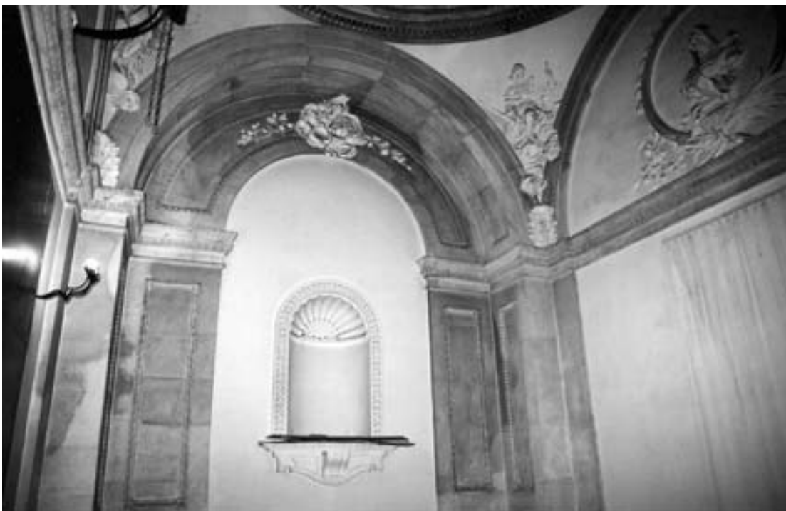
Pared oriental de la sacristía exterior. Arquitectura: Melchor de Velasco, 1657-58. Decoración en yeso: mediados del siglo XVIII
