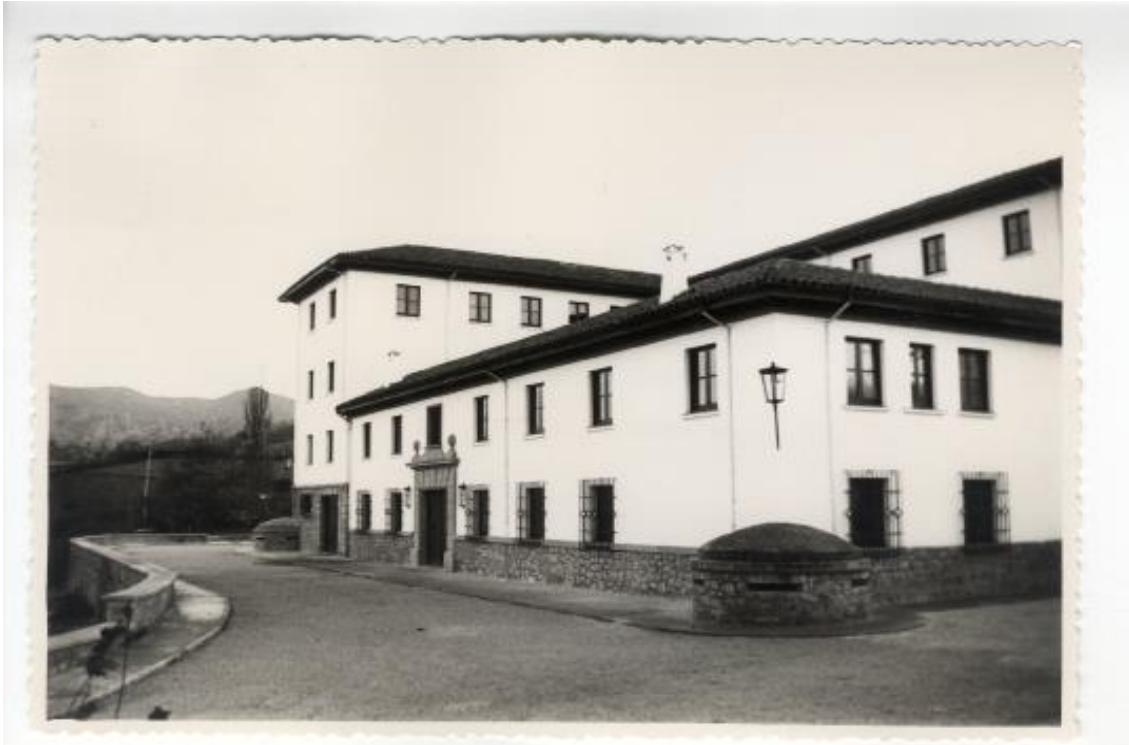
Fig. 116. Casa cuartel de la Guardia Civil. AGA, caja F/04228-016-002.
