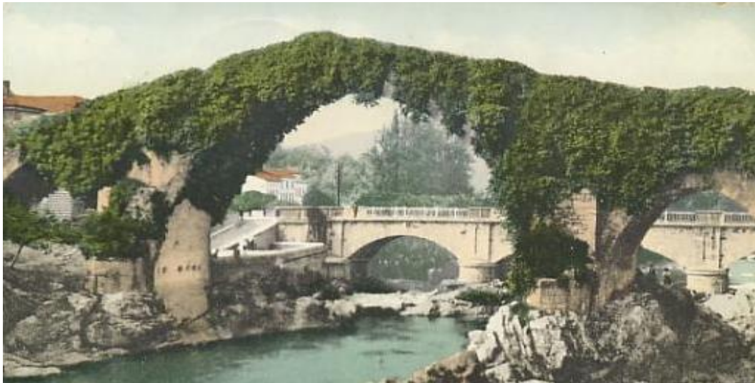
Fig. 128. Postal que muestra el estado de conservación del puente de Cangas de Onís en 1908. Archivo Padre Patac, n.º 256.
