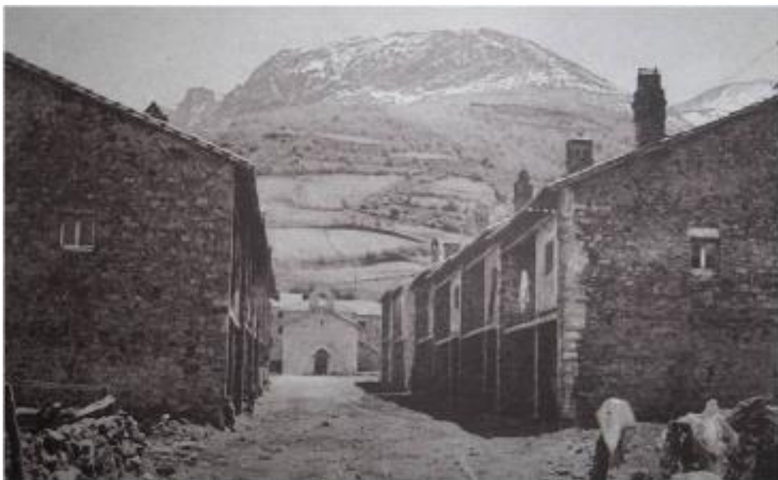
Fig. 63. Viviendas tipo I: bajo con cuadra, cocina, baño y porche. Piso: tres dormitorios y tenada. AGA, Exp. 76/13/20494.
