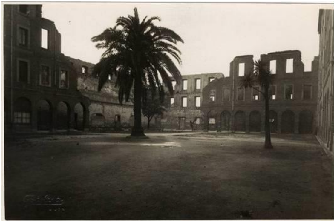
Fig. 35. Destrucción del patio interior del cuartel de Simancas. AGA, Exp. F-04228-001.
