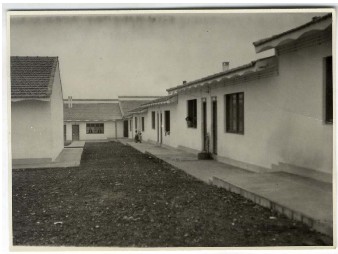
Fig. 49. Aspecto del grupo de albergues provisionales de San Lázaro AGA, caja F-04227-040-001.
