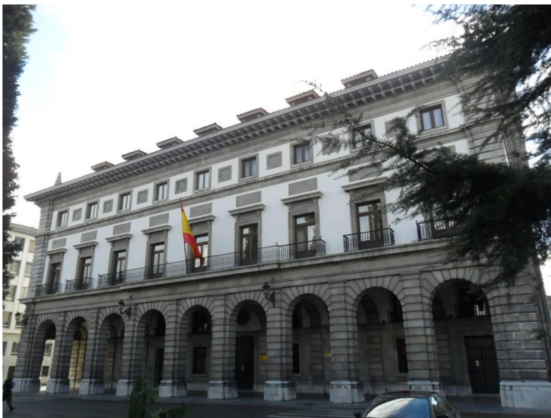
Fig. 56. Estado actual del edificio destinado a Gobierno Militar. (Fotografía: Míriam Andrés).
