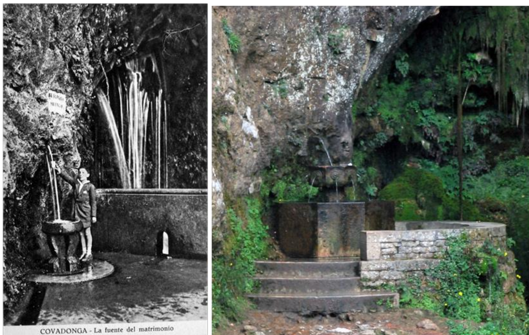
Fig. 142. Izda: estado de la “Fuente del Matrimonio” antes de la intervención de Luis Menéndez-Pidal, con el Chorrón de fondo (Archivo Padre Patac, n.º 229). A la derecha: resultado de la citada intervención (Fotografía: Luis Andrés).
