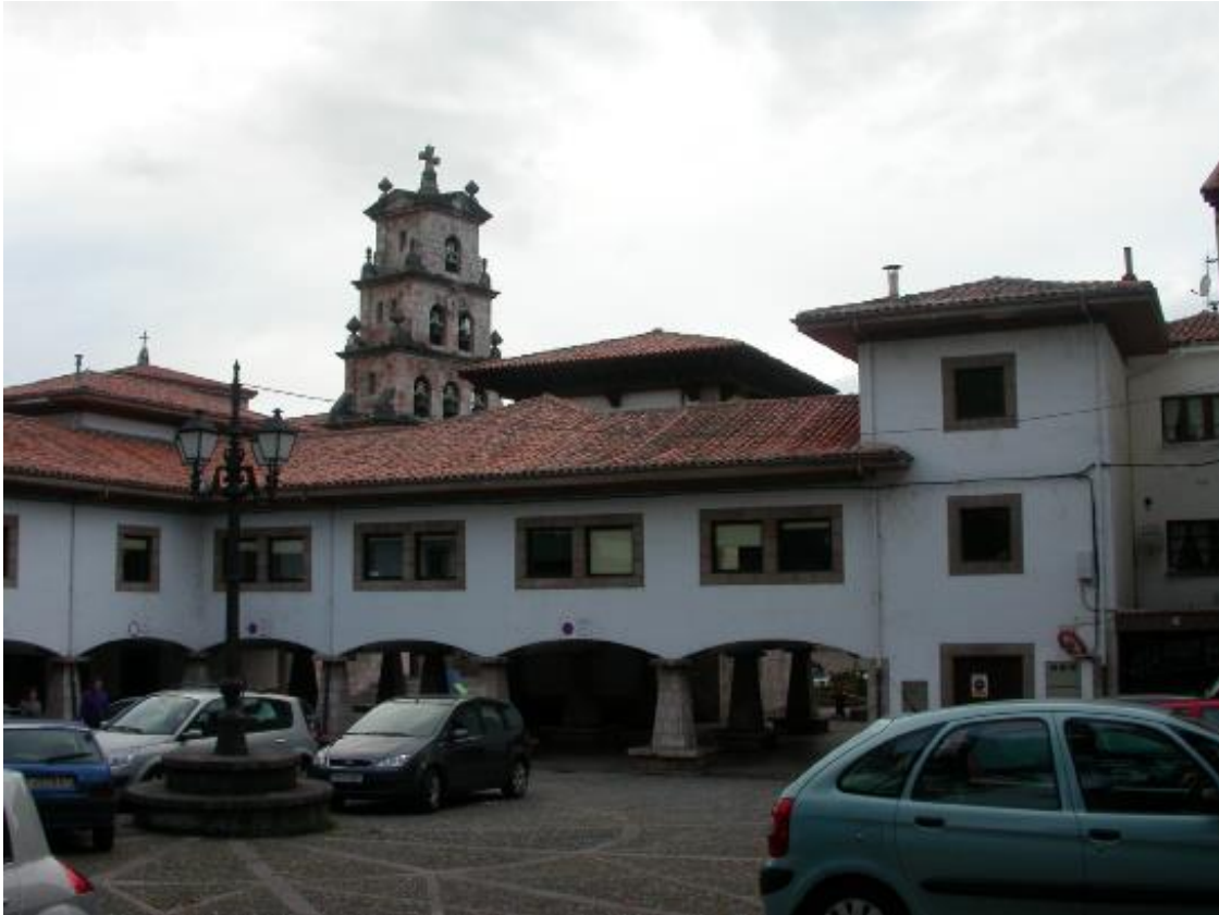
Fig. 133. Adaptación de la parte posterior del edificio para aparcamiento (Fotografía: Miriam Andrés).
