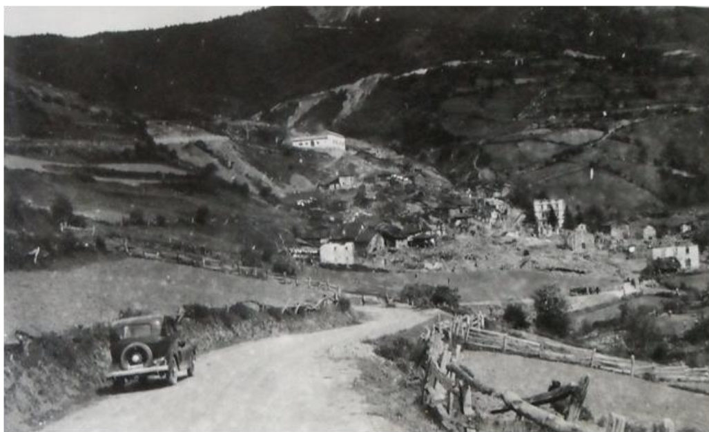
Fig. 62. Tareas de desescombro en Tarna. AHPA, caja 1268/02.
