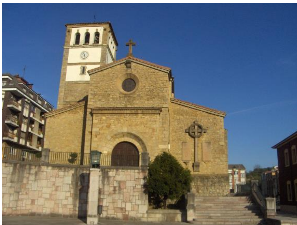
Fig. 112. Estado actual de la iglesia de San Bartolomé (Fotografía: Míriam Andrés).
