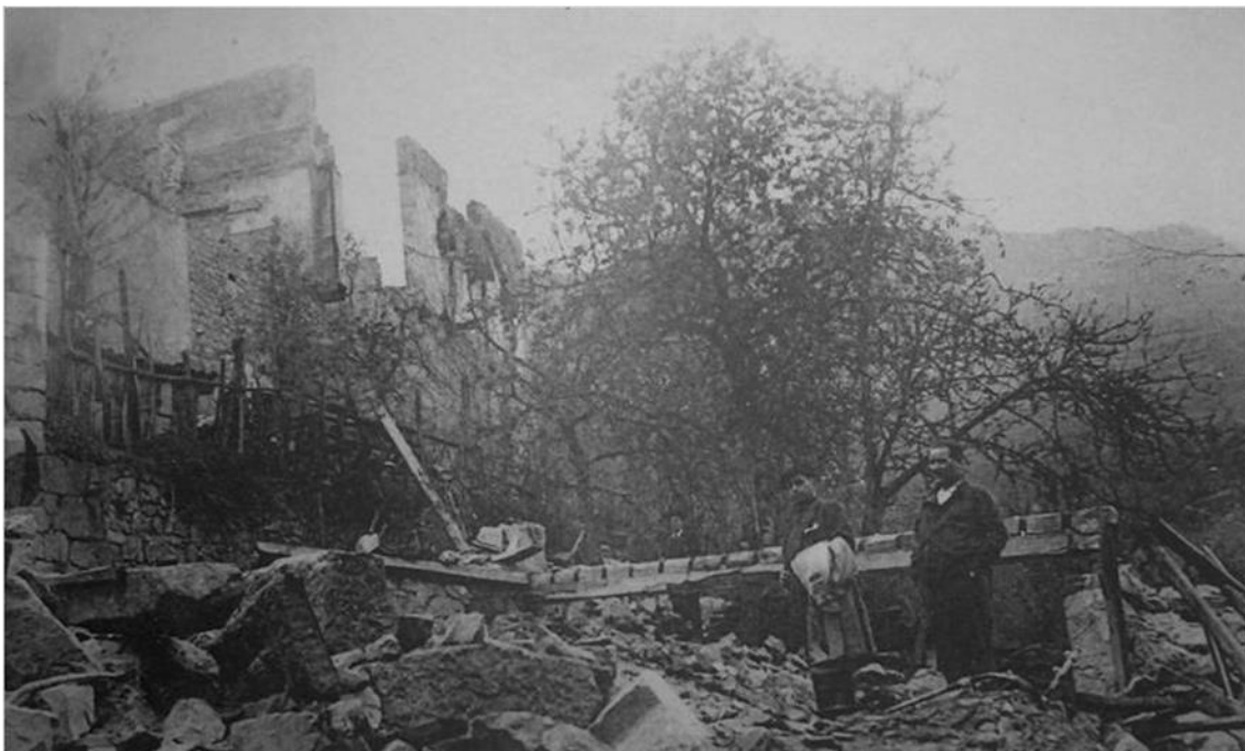
La Foz. “Un aspecto de las ruinas del pueblecito de la Foz”.
