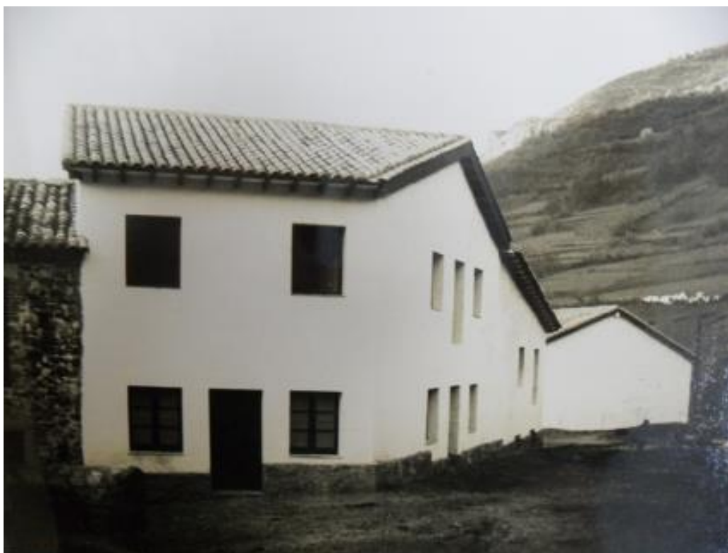
Fig. 73. Fachada principal del tipo C. AHPA, caja 0068/11.
