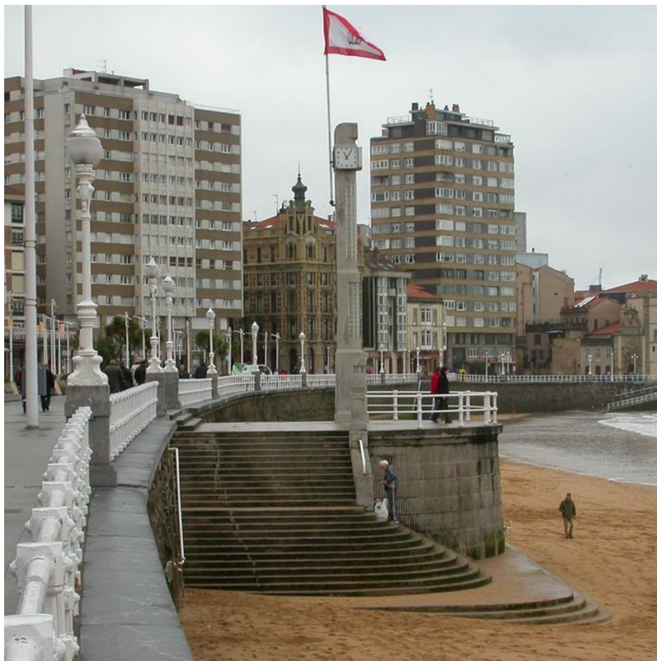
Fig. 29. Estado actual de la Escaleroña, obra de Fernández Omaña. (Fotografía: Luis J. Andrés).
