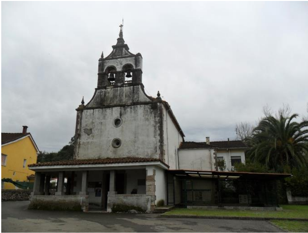
Fig. 91. Estado actual de la iglesia de Santa Eulalia de Valduno (Fotografía: Míriam Andrés).
