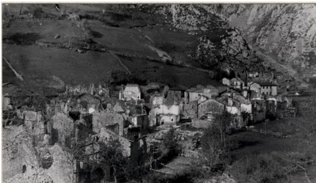
Fig. 86. Panorámica de la destrucción de la Foz en la que podemos apreciar cómo buena parte de los muros perimetrales de las viviendas se mantuvieron en pie. AGA, caja F-04228-008-002.
