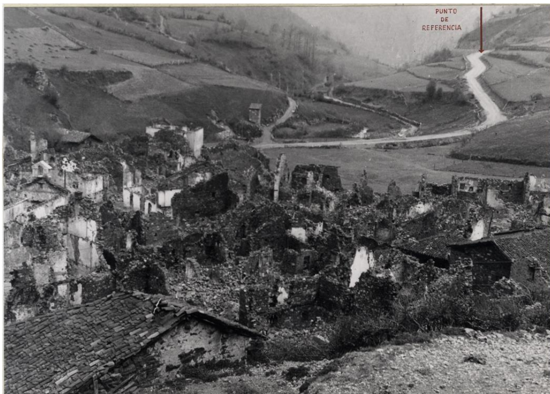
Fig. 60. Estado del pueblo de Tarna tras el incendio. AGA, caja F-04228-027-004.
