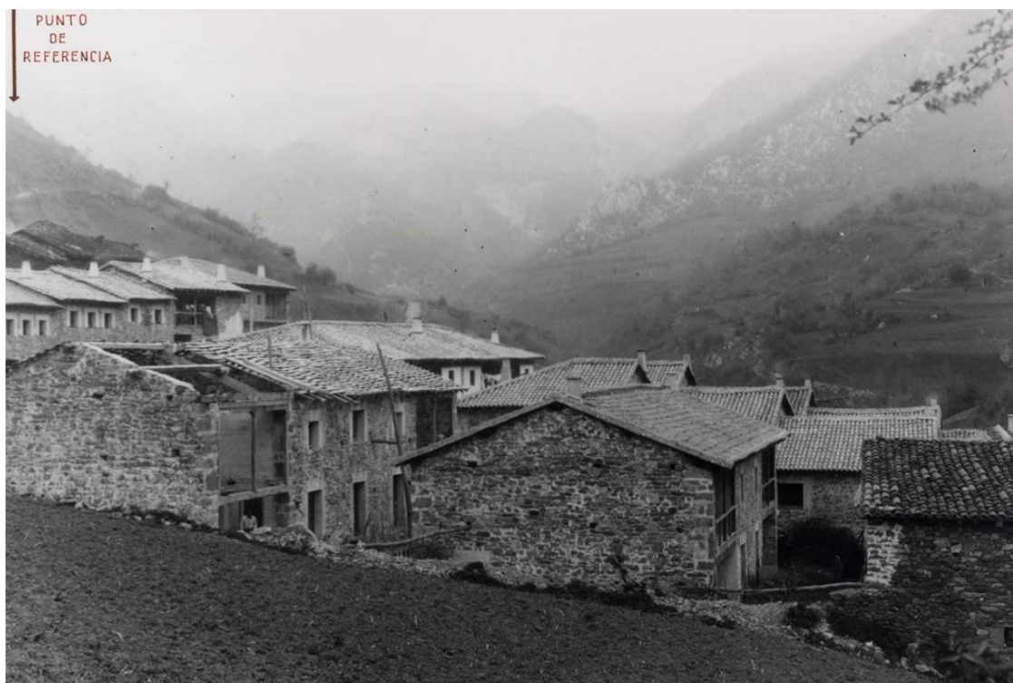
Fig. 82. Viviendas reconstruidas en Pendones. AGA, caja F-04228-008-003.
