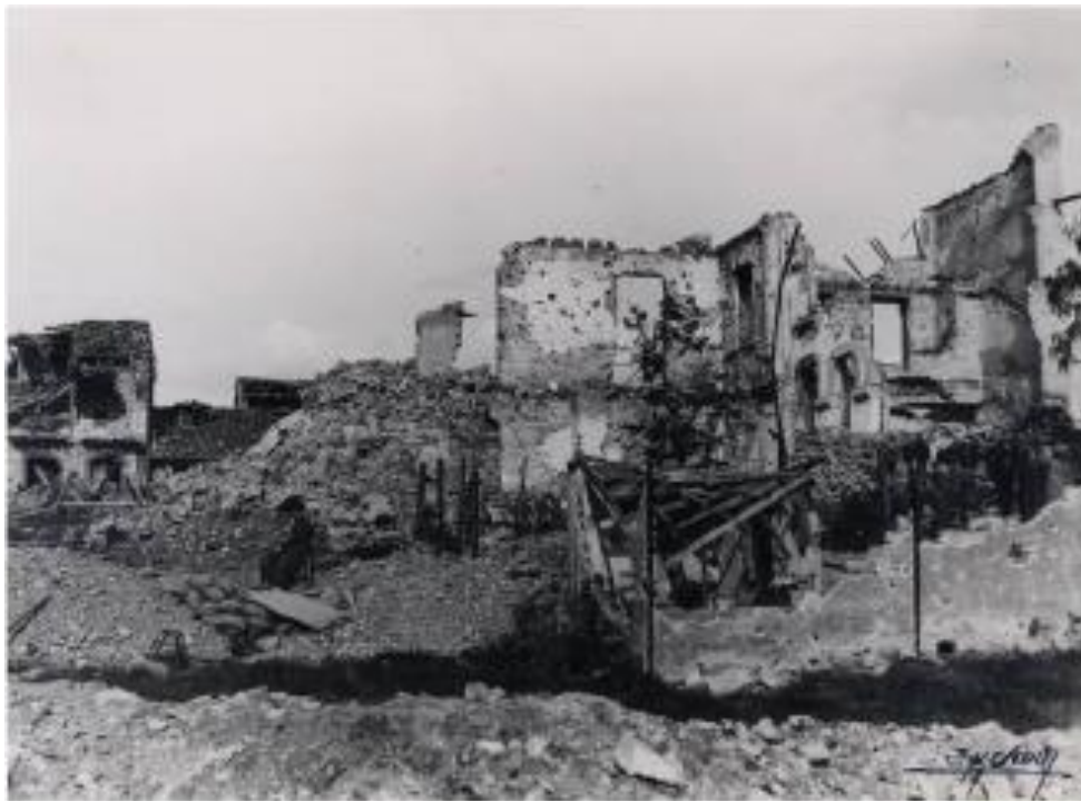
Fig. 21. Estado de ruina de El Fresno, aldea situada en las inmediaciones del pasillo de Grado. AGA, caja 04228-008-003.
