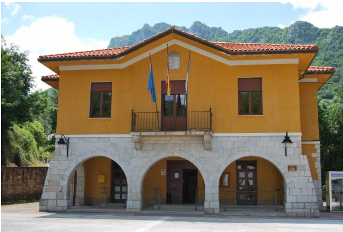
Fig. 107. Estado actual de la casa consistorial de Campo de Caso (Fotografía: Luis Andrés).
