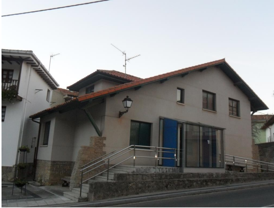
Fig. 98. Centro rural y vivienda del médico en Caravia alta, muy reformado, pero que aún sigue la tipología del reguerín (Fotografía: Miriam Andrés).
