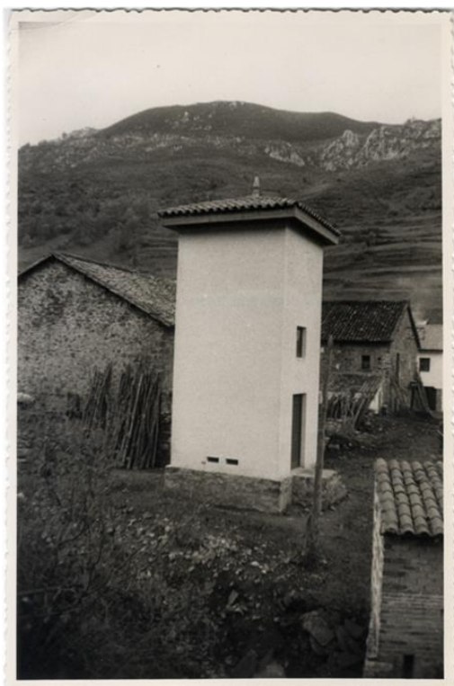
Fig. 13. Transformador eléctrico en Tarna. AGA, caja F- 04228-029-001.
