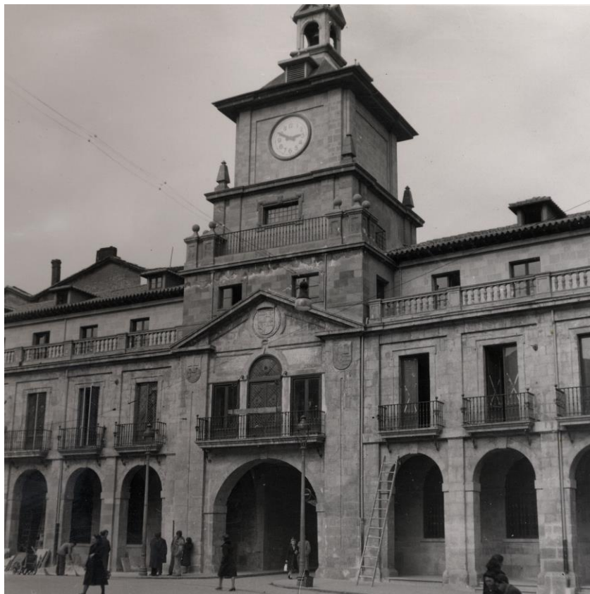
Fig. 61. Reconstrucción del ayuntamiento de Oviedo. AGA, caja F-04258-003-002.
