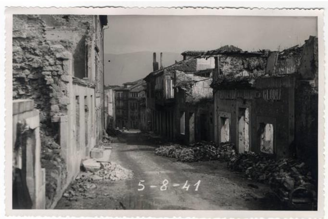
Fig. 48. Destrucción en el barrio de San Lázaro. AGA, caja F-04227-010-003.
