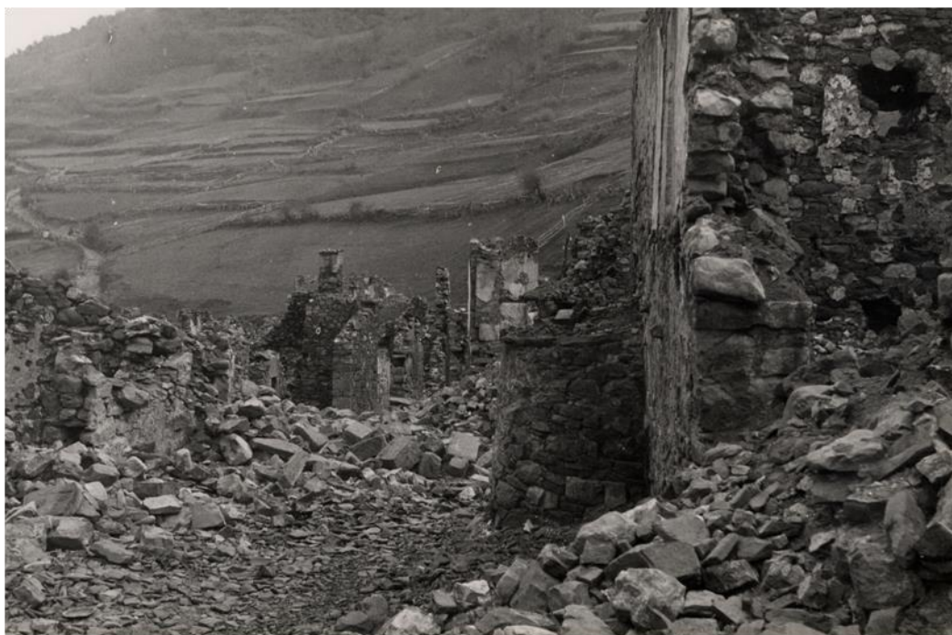
Fig. 80. Un aspecto de la destrucción del pueblo de Pendones. AGA, caja F-04228-20-001.
