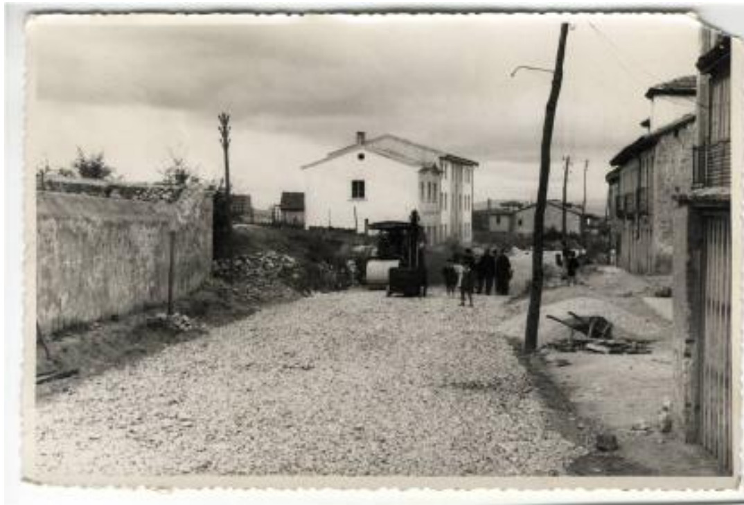
Fig. 14. Urbanización de carretera de acceso al Cristo de las Cadenas, Oviedo. AGA, caja F-04227-016.
