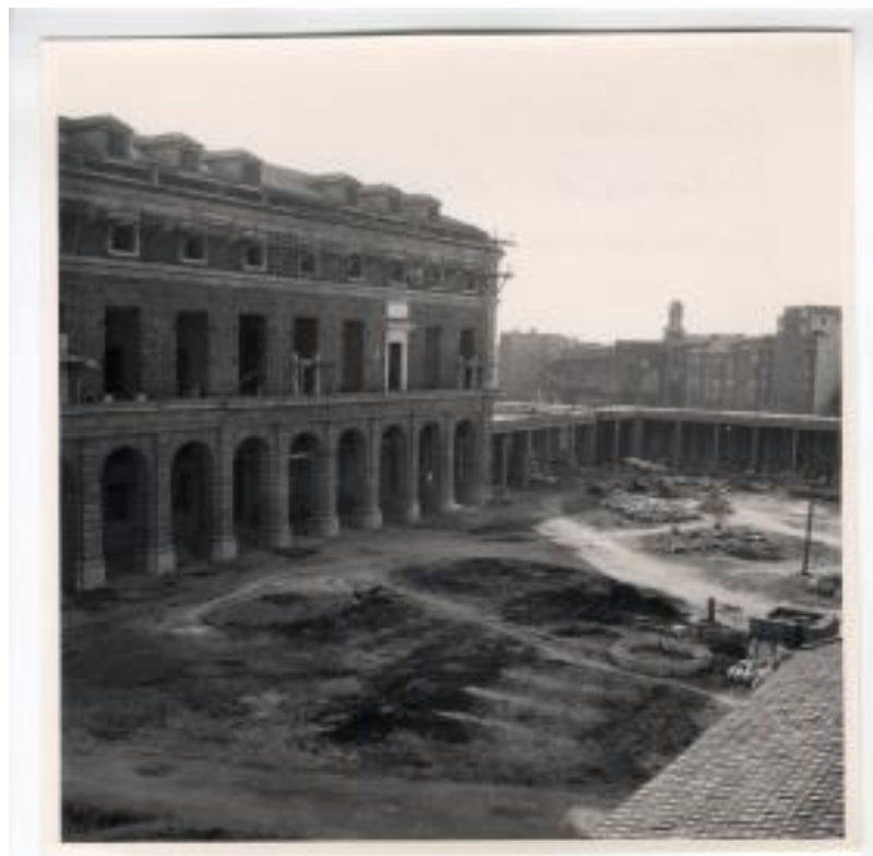
Fig. 55. El edificio del Gobierno Militar en construcción. AGA, caja F-04227-016-005.
