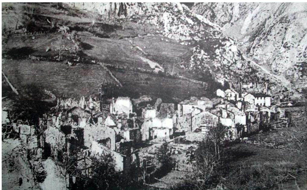
Fig. 26. Estado de destrucción de La Foz (concejo de Caso) tras la contienda. AGA, caja F-04228-008-002.
