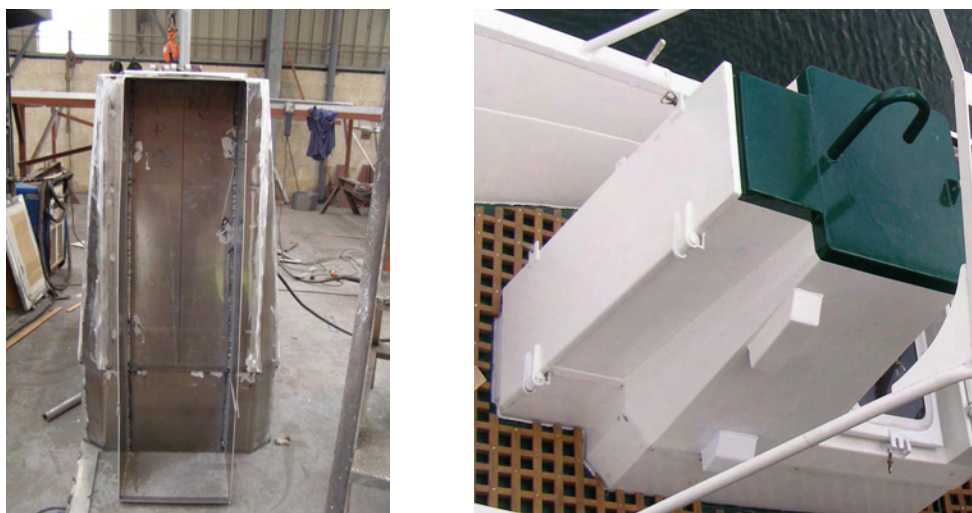
Figura 7.6.- Estructura fabricada para alojar la botella de hidrógeno.
