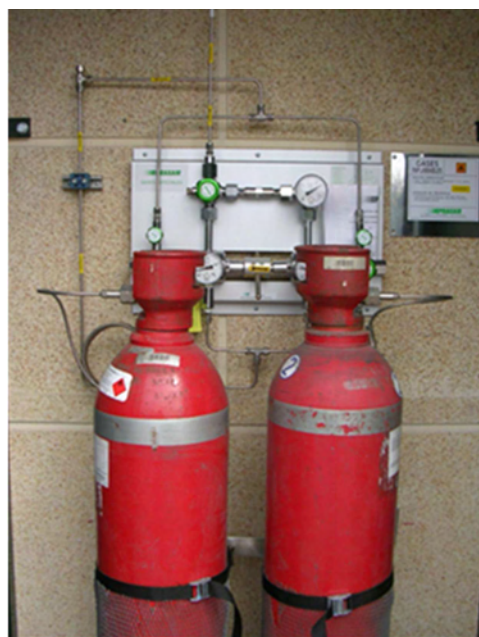
Figura 5.3.- Panel de conexión de las botellas de \text{H}_2
