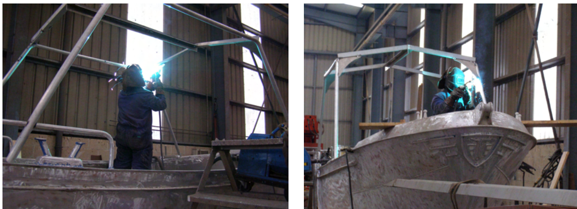
Figura 7.7.- Construcción del soporte que aloja los paneles solares fotovoltaicos.
