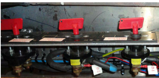
Figura 7.35.- Interruptores cortacorrientes de los tres grupos de baterías.
