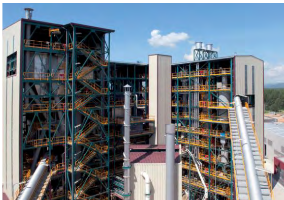
Figura 1.18. Instalación de gasificación de biomasa entre calderas de lecho fluido (derecha) y carbón pulverizado (izquierda) en CIUDEN.
