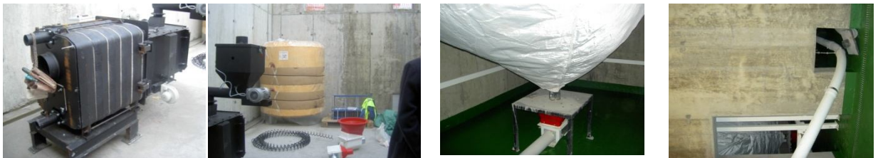
Figura 31. Ubicación de los equipos en la fase final de la construcción del contenedor
