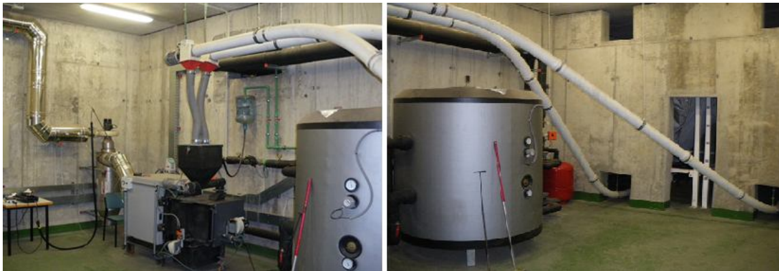
Figura 66. Vista de la caldera, ciclón, sin-fines de alimentación, acumulador de agua caliente y búnkeres con big-bags.
