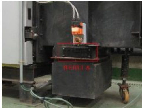
Figura 71. Rejilla instalada en sustitución de la soplante de aire terciario.
