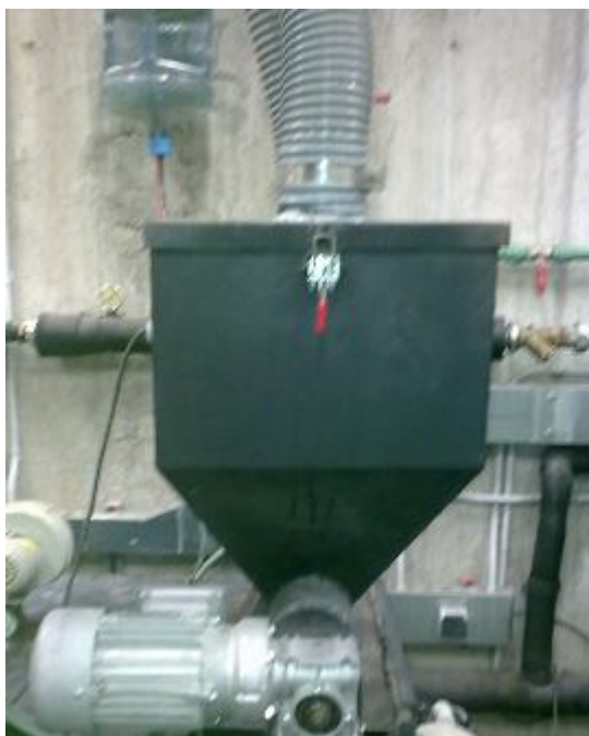
Figura 72. Tolva de alimentación de pélets en la caldera
