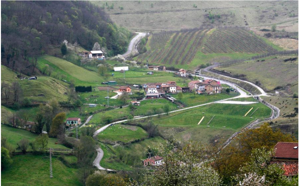
Aldea de Cardañuezo, con la antigua explotación a cielo abierto de La Mozquita, plantada parcialmente de frutales. Fotografía: Joaquín Meda.
