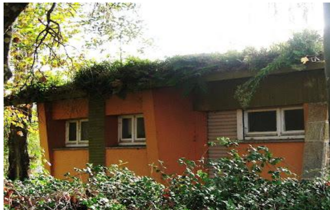
Figura 37: Casa abandonada en Perlora
