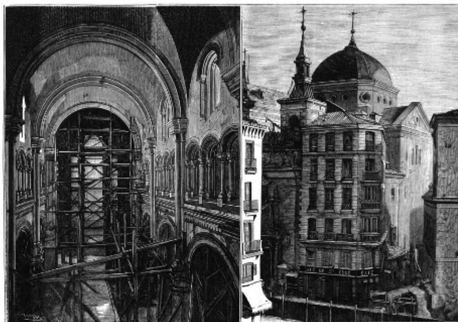
VISTA INTERIOR DE LA NAVE PRINCIPAL al comenzar el derribo.
