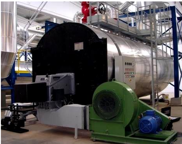
Imagen 4: Exterior de una caldera pirotubular horizontal.
