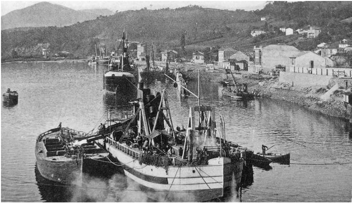
Figura 17. Muelles en construcción en el puerto de San Esteban de Parvia, tomado desde el N en 1910. A la derecha, las edificaciones de la población todavía muy escasas (Archivo digital de Asturias).
