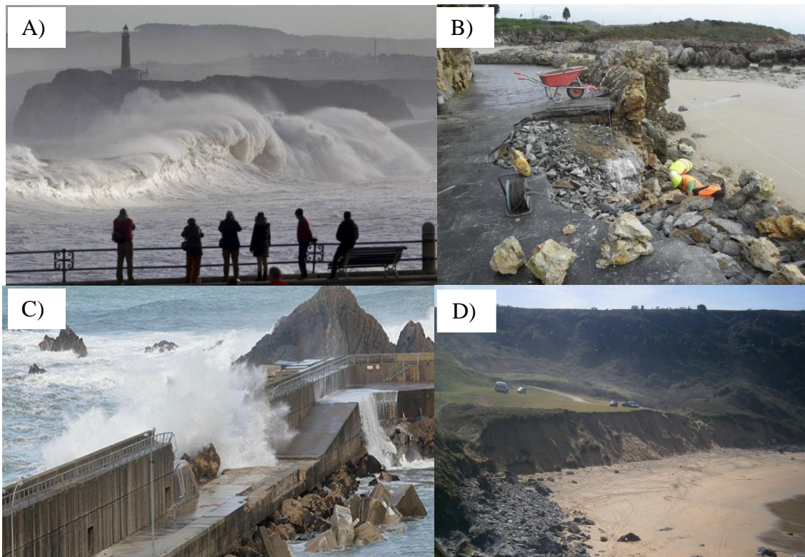
Figura39. Diferentes resultados del temporal del 2 de febrero de 2014. a) Olas de grandes magnitudes en el entorno de la isla de Mogro sobre la ensenada del Camello en Santander (El Diario Montañés); b) Destrozos en la playa de Palombina (Llanes); c) Rotura del dique del puerto de Cudillero roto tras el paso del temporal (La Nueva España) y d) Fuerte recesión del frente dunar de la playa de Carniciega o Aguilera en Verdicio, que alcanza desniveles de 6-7 m
