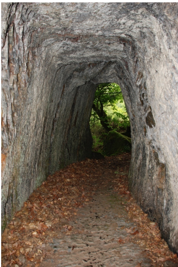
Túneles en el canal minero de Penafurada (Grandas de Salime).
