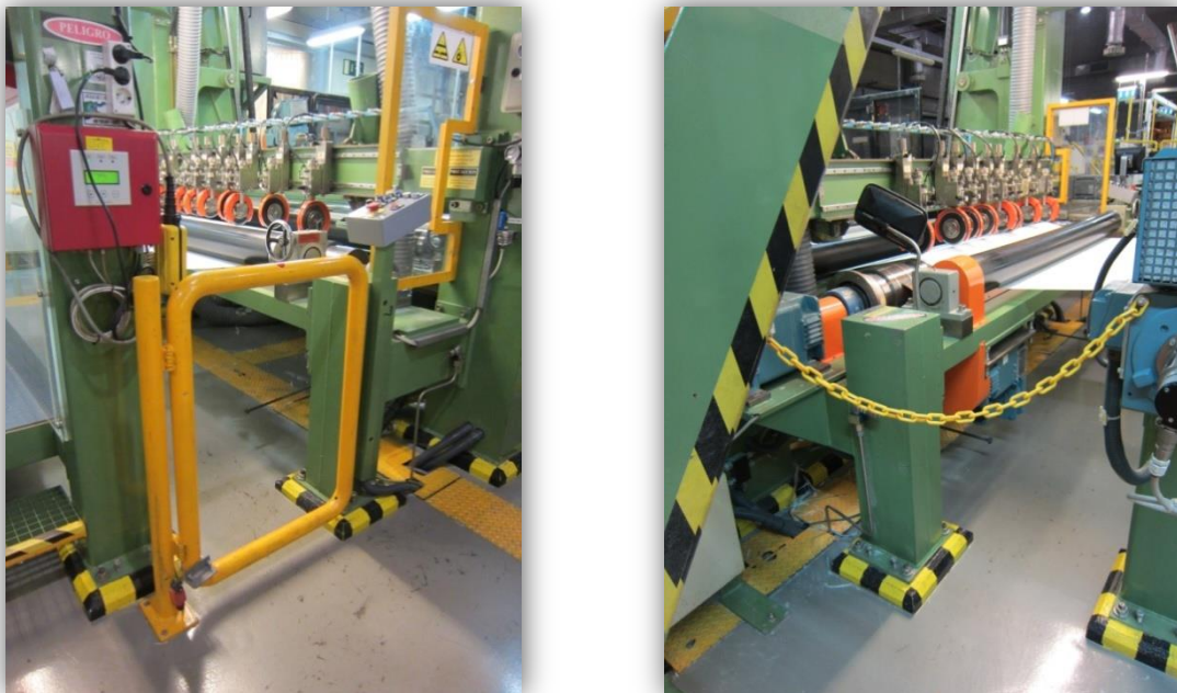
Figura 26: Zona de corte longitudinal con resguardos insuficientes
