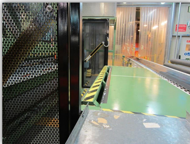
Figura 29: Falta de resguardo en zona de expulsión
