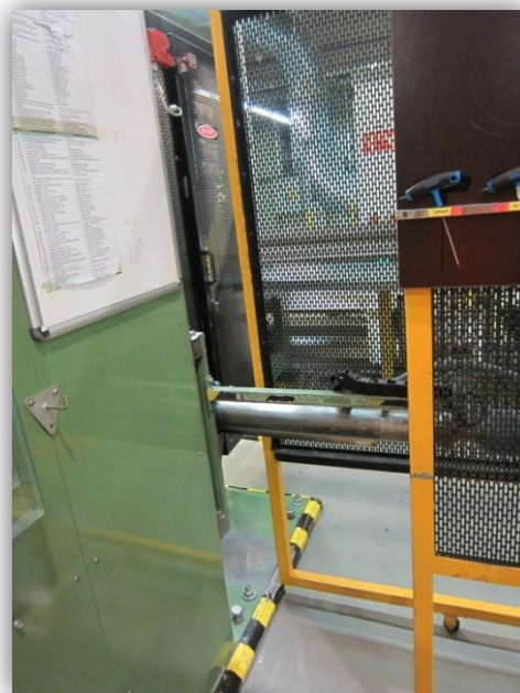
Figura 27: Resguardo insuficiente del contrapunto del lado A
