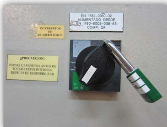
Figura 7: Seccionador bloqueable
