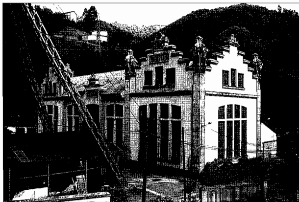
FIG. 5. Casa de máquinas del pozo San Luis.
