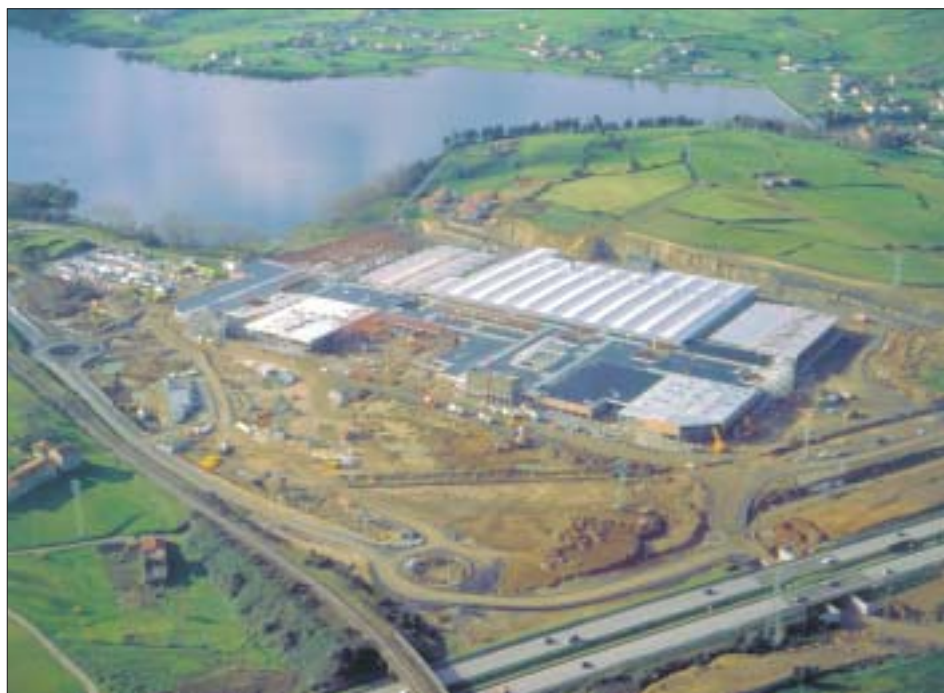
FIG. 4. El centro comercial Parque Astur (periferia de Avilés) en construcción (foto tomada del Atlas Aéreo de Asturias ).
