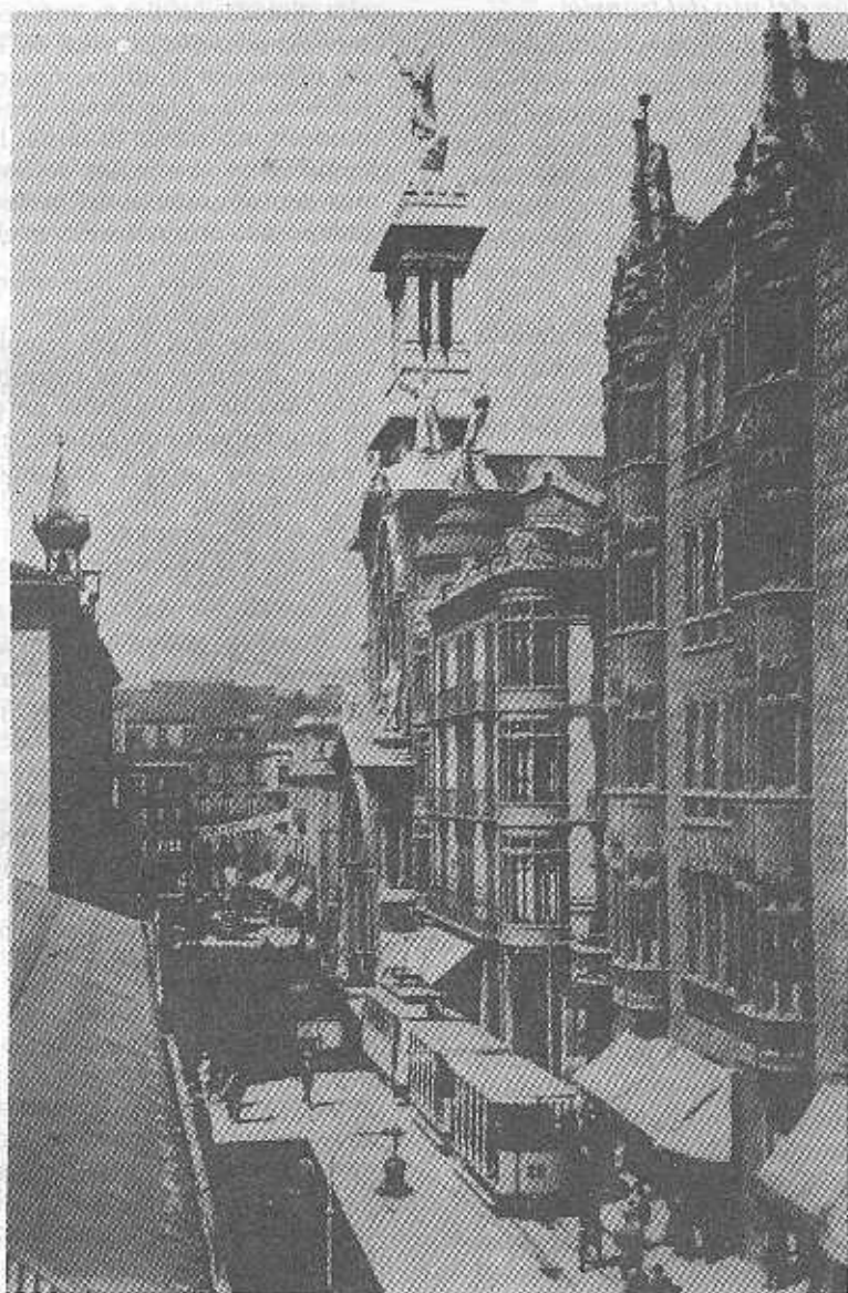
Fig. 31. Un ejemplo de la renovación del parque móvil en los años 20 de este siglo. Los primeros coches motores General Electric, con dos jardineras a remolque uno de ellos, cruzándose en el apartadero de la calle Jovellanos.
