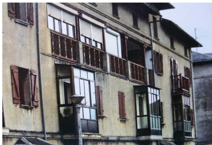
Fig. 355. Detalle de fachada antes de la rehabilitación.
