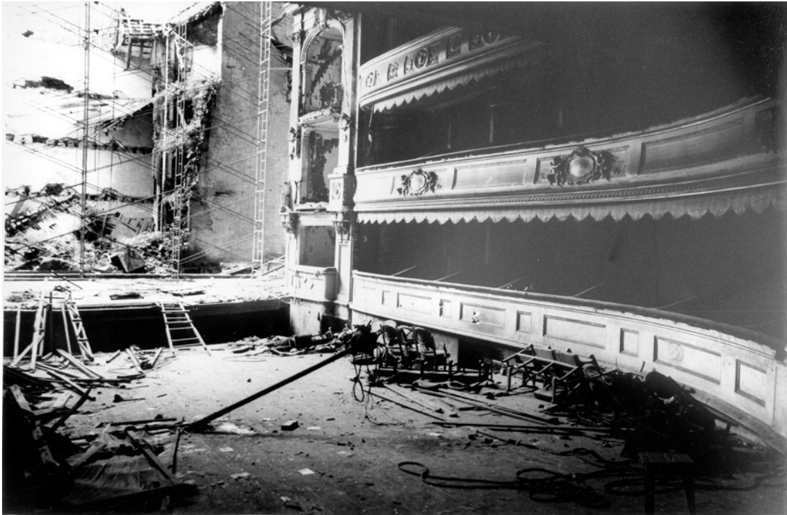
Fig. 29. Estado del Teatro Palacio Valdés antes de la rehabilitación.
