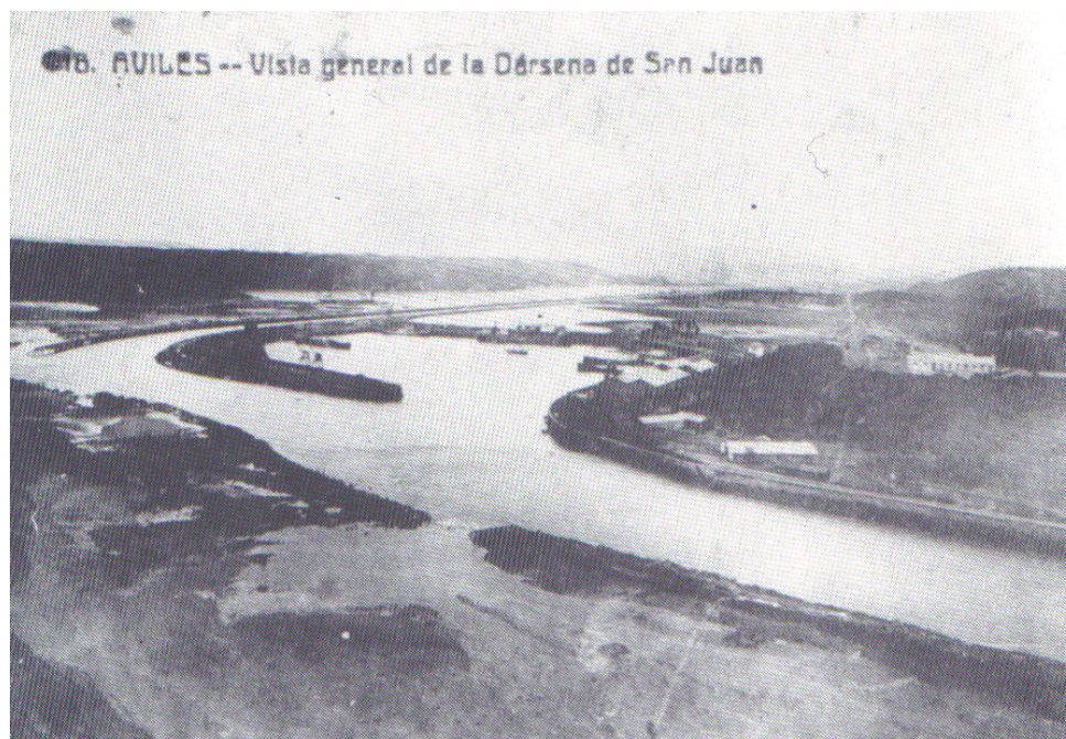
Fig. 87. Vista general de la dársena de San Juan de Nieva.
