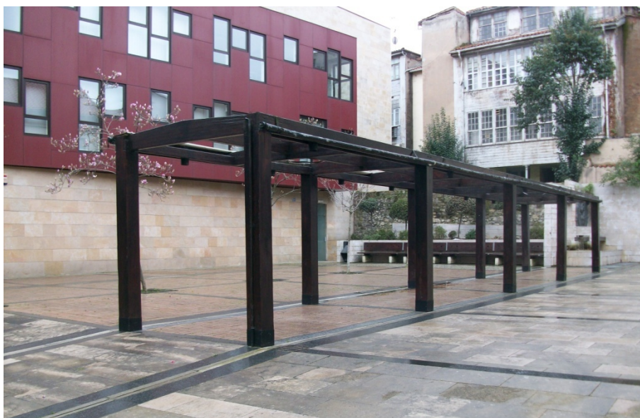
Fig.262. Detalle del pavimento reticulado y la estructura de madera.
