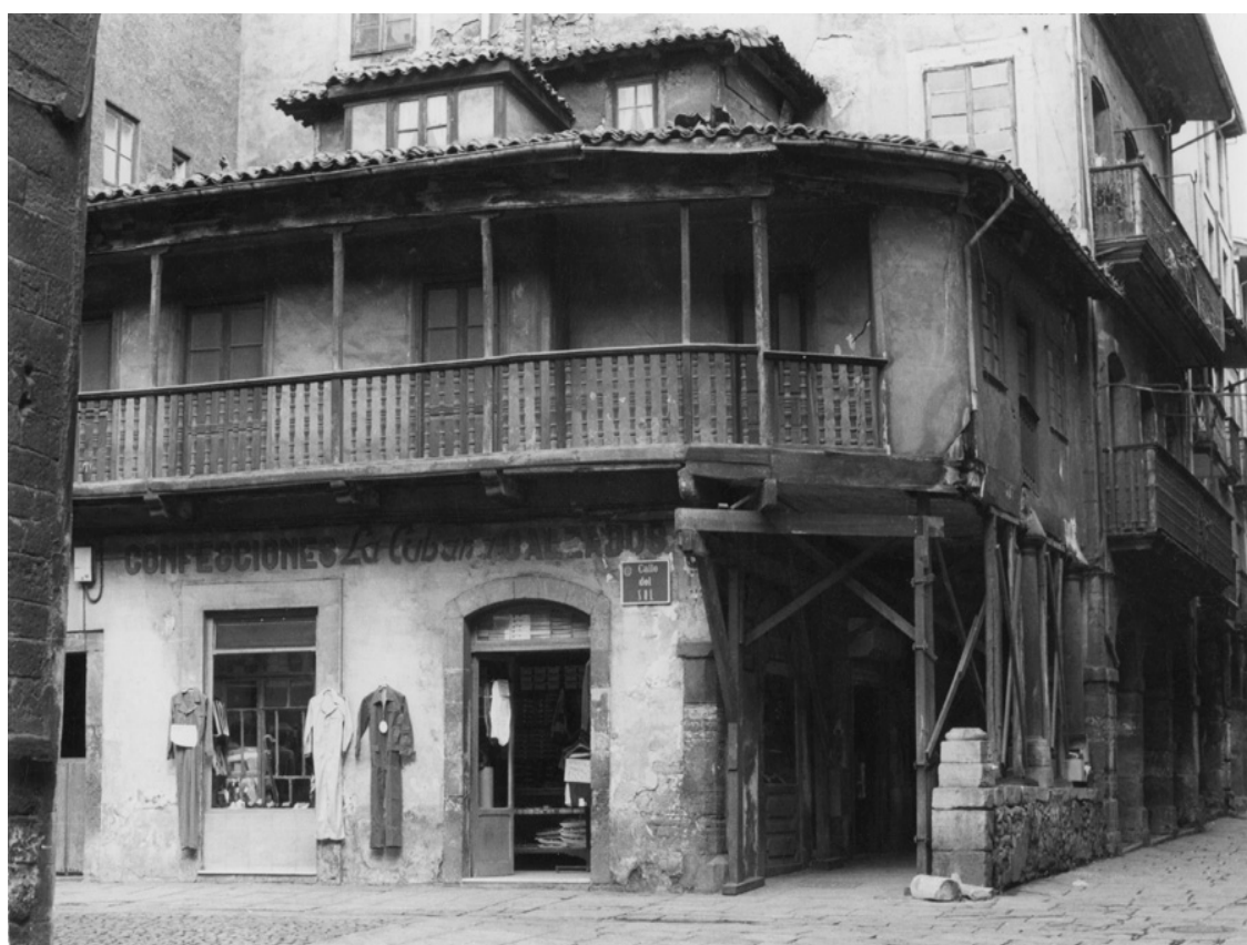
Fig. 58. Edificio en ruinas en al esquina La Ferrería con la calle El Sol
