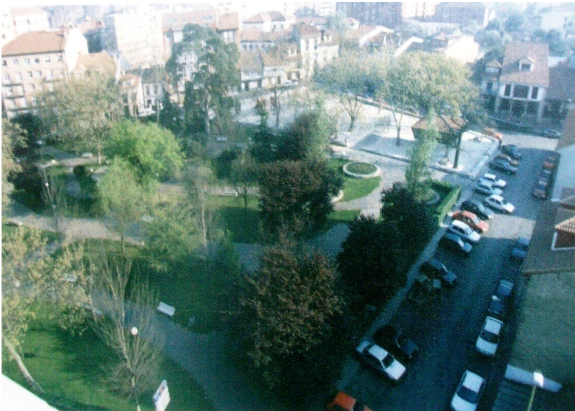
Fig.337 . Estado de la plaza del Carbayedo antes de la reurbanización.
