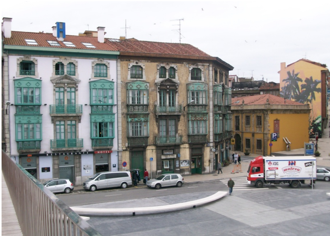
Fig. 323. Lado oeste de la plaza de Santiago López (C/Llano Ponte, 2-4)
