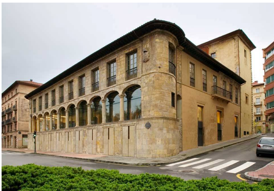
Fig. 252. Fachadas septentrional y occidental del Palacio de Camposagrado.
