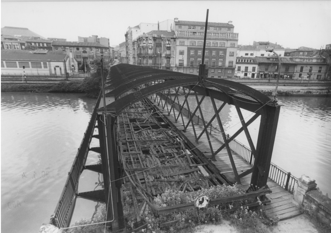
Fig. 329. Estado del puente de San Sebastián en 1993.
