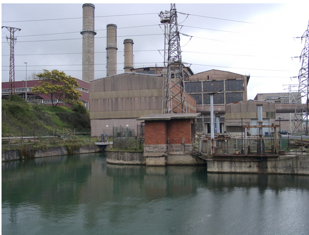
Fig. 66. Canal de agua de entrada de refrigeración de la Térmica de Ensidesa
