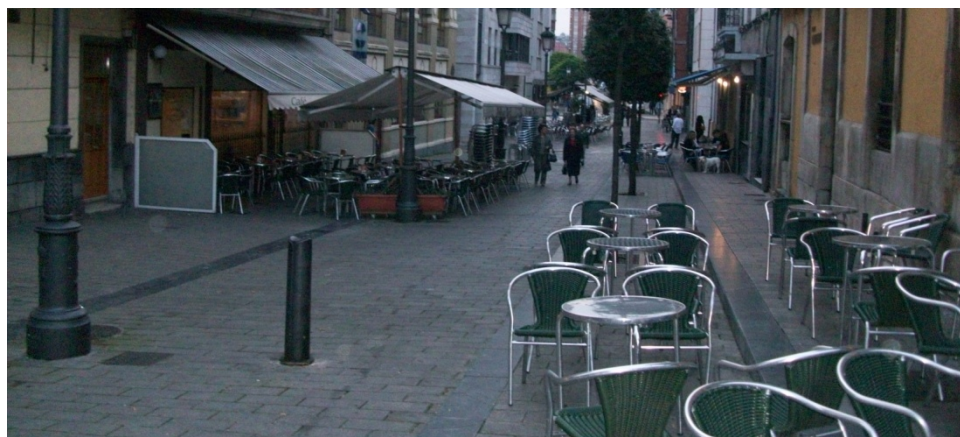
Fig. 289. Detalle del pavimento de la calle Carreño Miranda.
