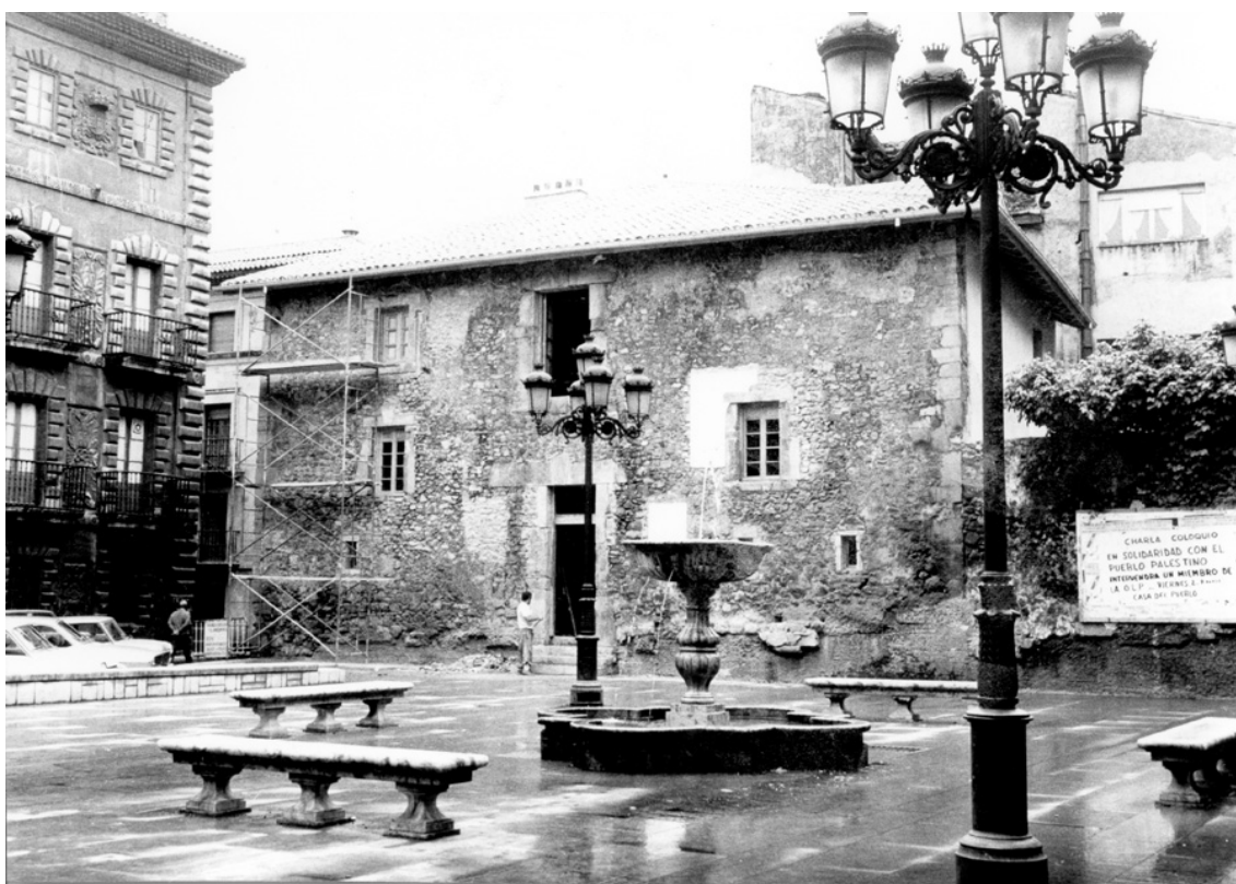
Fig.30. Rehabilitación de la Casa de Pedro Menéndez como en los años ochenta.
