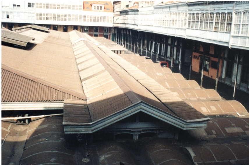
Fig. 312. Cubierta del mercado antes de la intervención.
