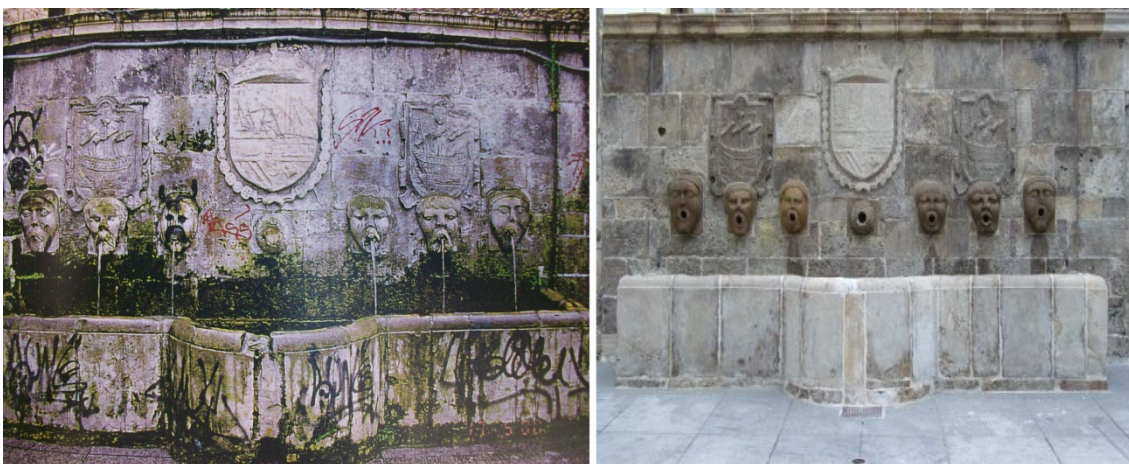
Fig. 310. Fuente de Los Caños de San Francisco antes (izda.) y después (dcha.) de la restauración.
