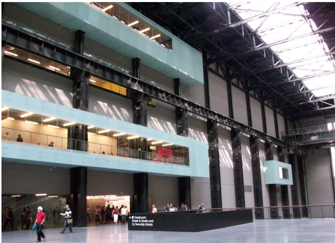
Fig. 117. Sala de turbinas de la Tate Modern (Londres).
