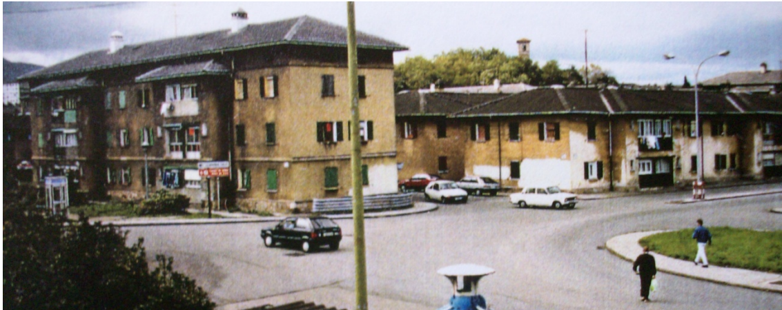
Fig. 353. Vista general de una de las calles de Llaranes.
