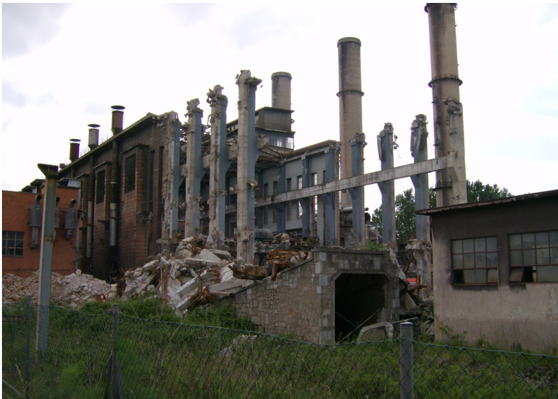
Fig.119. Derribo de la Central Térmica de ENSIDESA.
