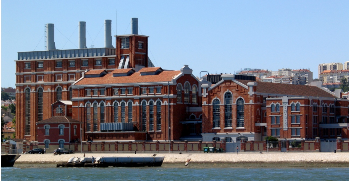
Fig.118. Central Eléctrica del Tajo (Lisboa)
