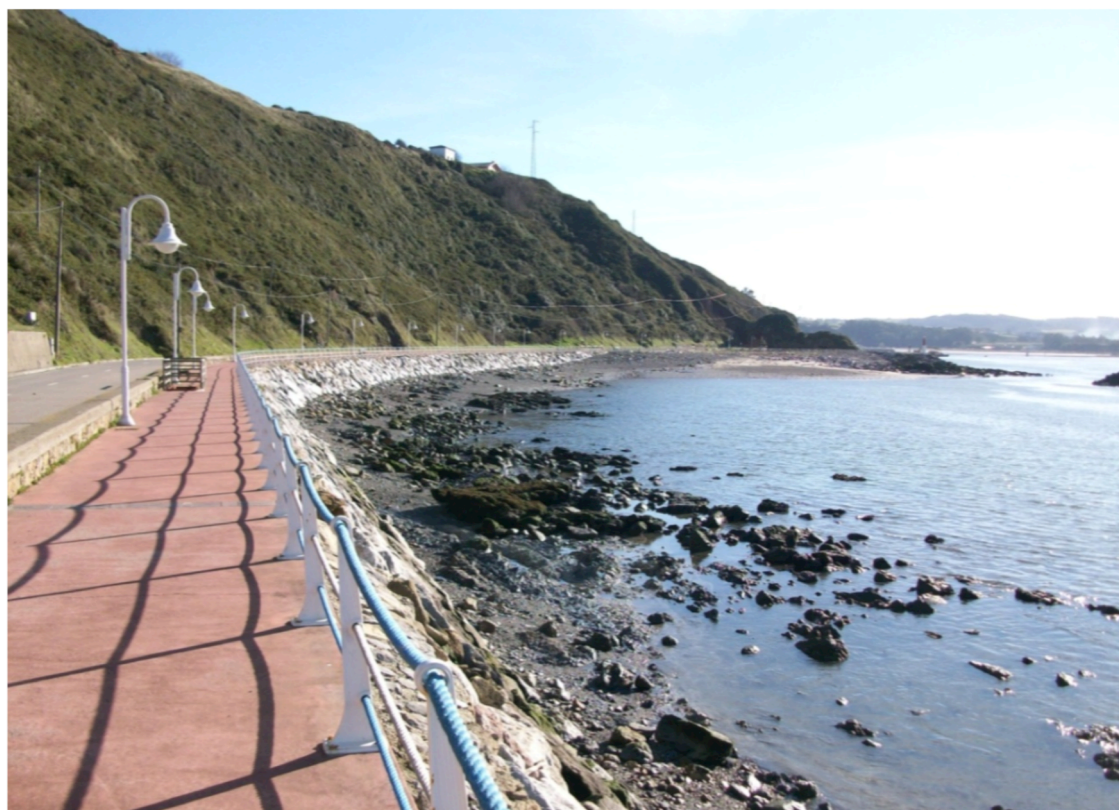
Fig. 109. Paseo del Aranon en la margen derecha.
