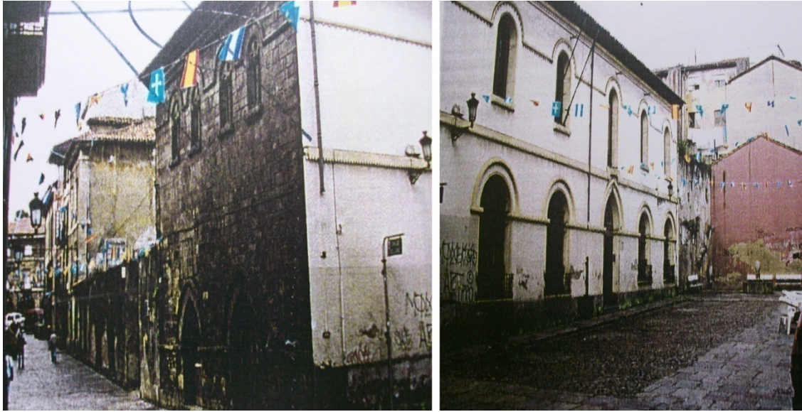
Fig. 265. Fachadas a La Ferrería (izq.) y El Sol (dcha.) antes de la rehabilitación.
