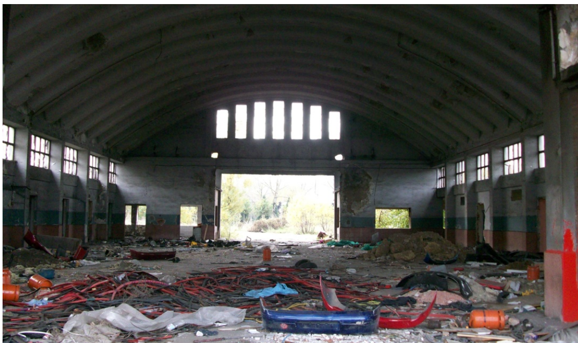
Fig.121 . Estado del parque de bomberos de ENSIDESA antes de la rehabilitación.
