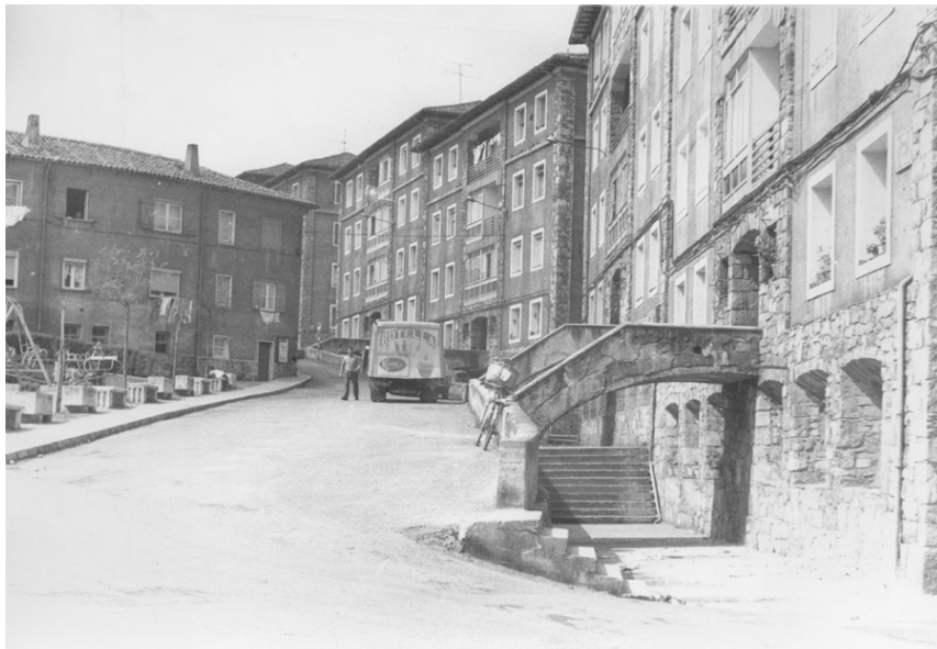
Fig. 366. Poblado del Nodo antes de la rehabilitación de los espacios públicos.
