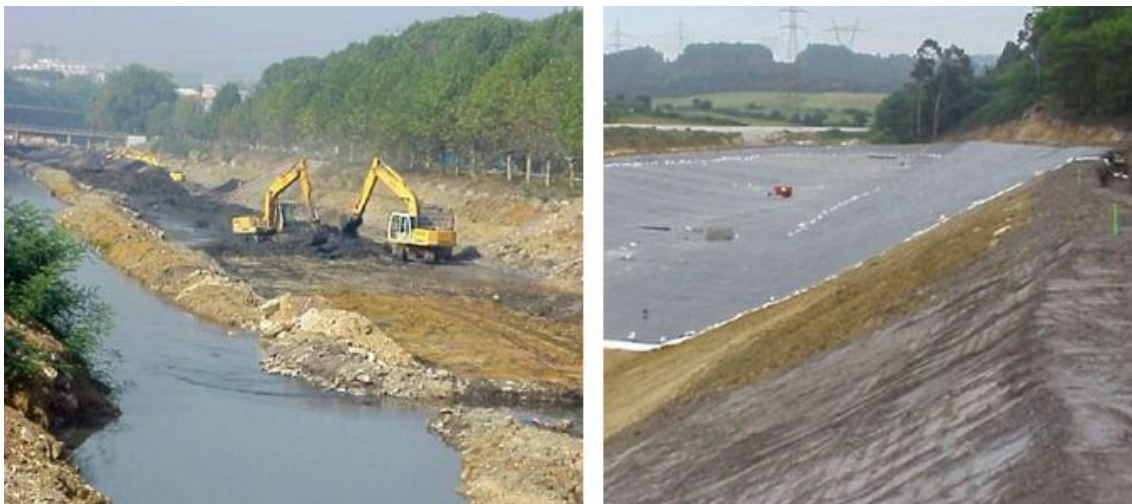
Fig.165 . Labores de retirada de lodos y construcción del depósito del Estrellín.
