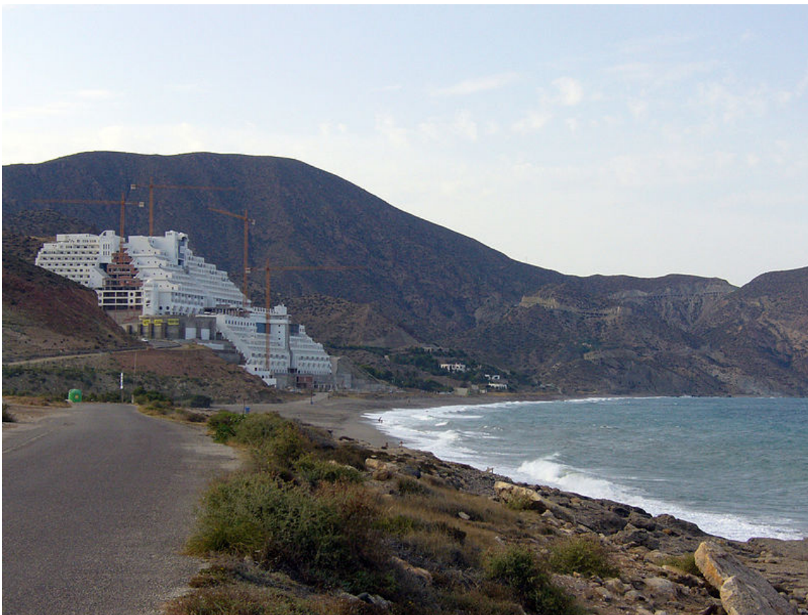
Fig. 33. Hotel de la playa del Algarrobico, en el Parque Natural del Cabo de Gata (Almería).
