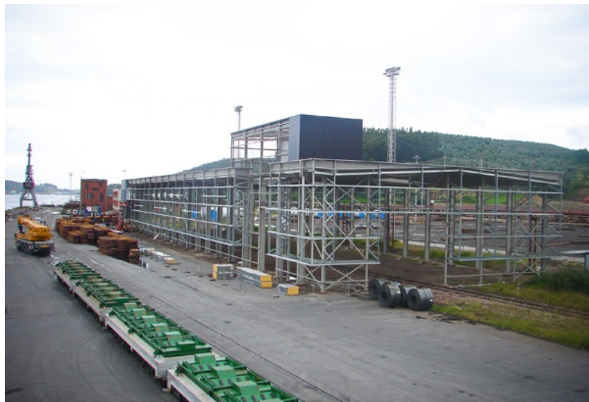
Fig. 185. Estructura de acero de los Tinglados del Puerto.
