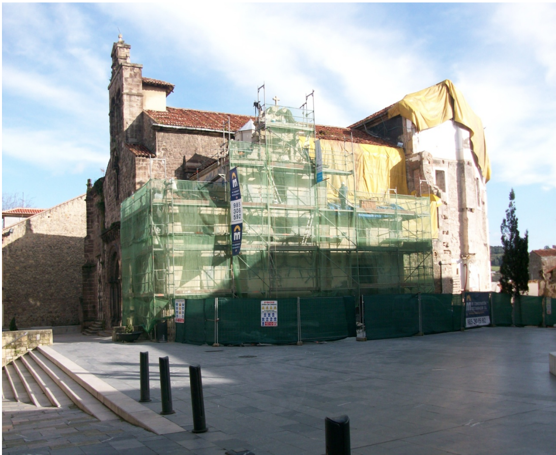
Fig. 229. Obras de demolición de la antigua residencia franciscana en 2010.
