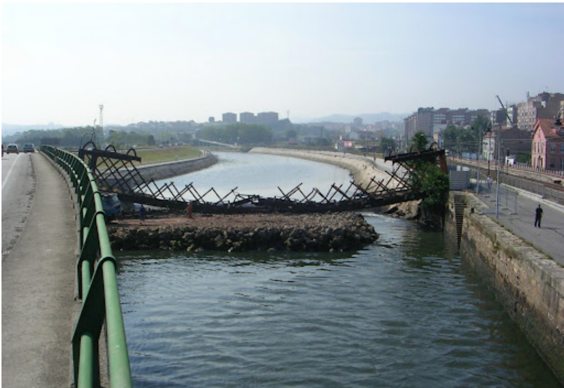
Fig. 330. Trabajos de demolición del puente de San Sebastián.
