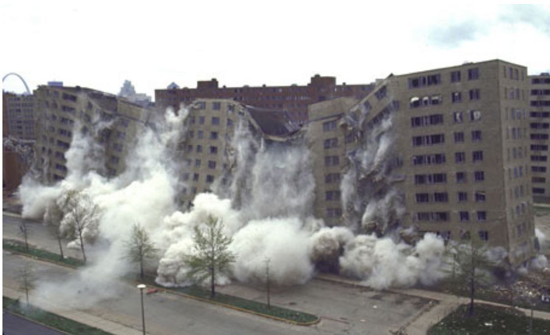
Fig. 17. Demolición del Pruitt-Igoe de Yamasaki (15 de julio de 1972).
