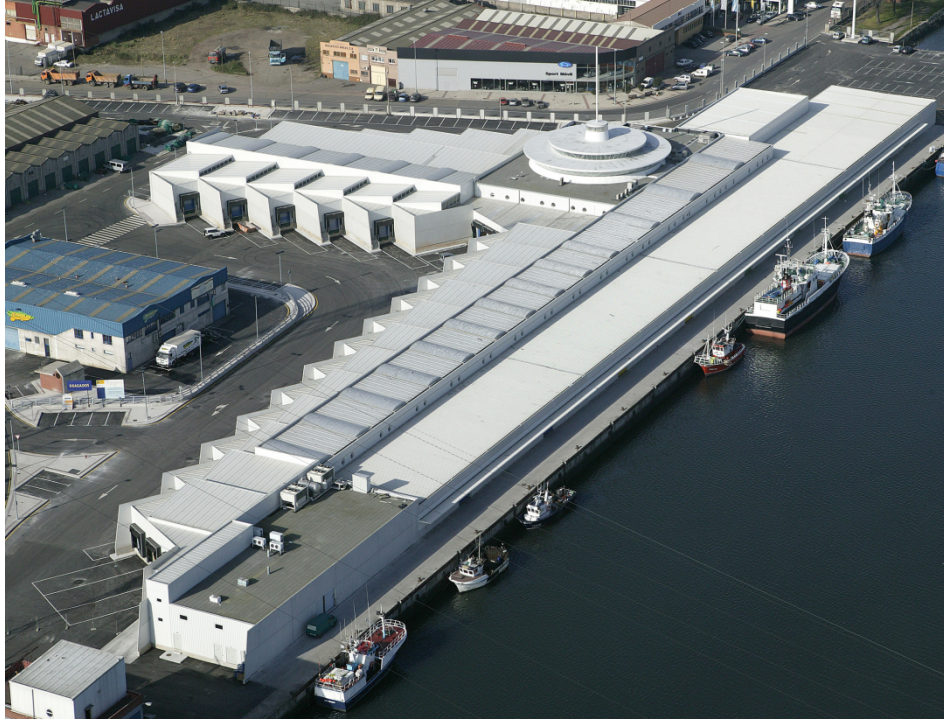
Fig.199 . Lonja climatizada de Avilés
