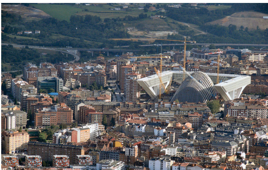
Fig. 39. Edificio Calatrava en el barrio de Buenavista (Oviedo).
