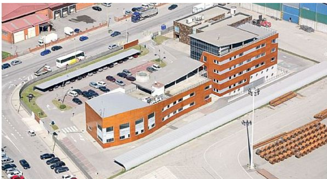
Fig. 203. Vista aérea de la Nueva Sede de la Autoridad Portuaria.
