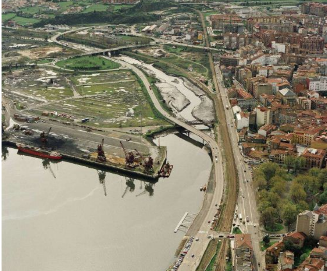
Fig. 123. Estado de la ría, la dársena de San Agustín y Divina Pastora ante de la regeneración.
