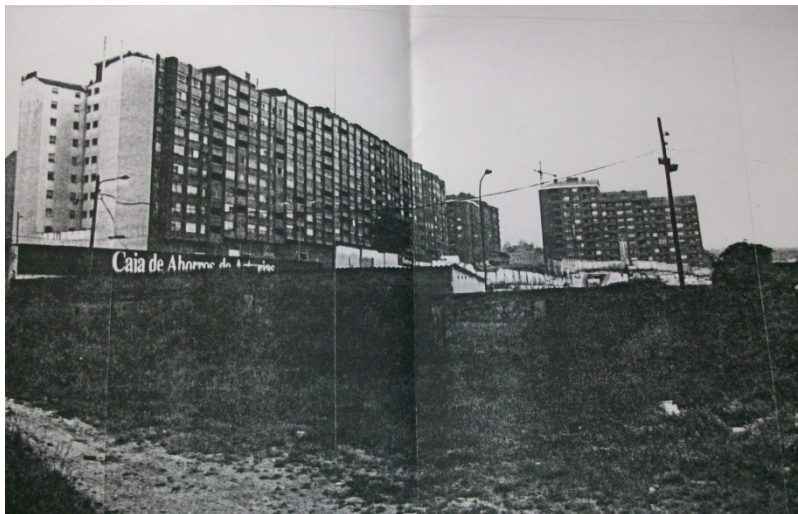
Fig. 373. Estadio Suárez Puerta antes de la reforma.
