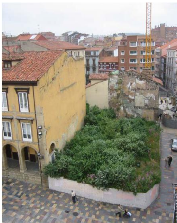
Fig. 233. Solares vacíos tras la demolición.
