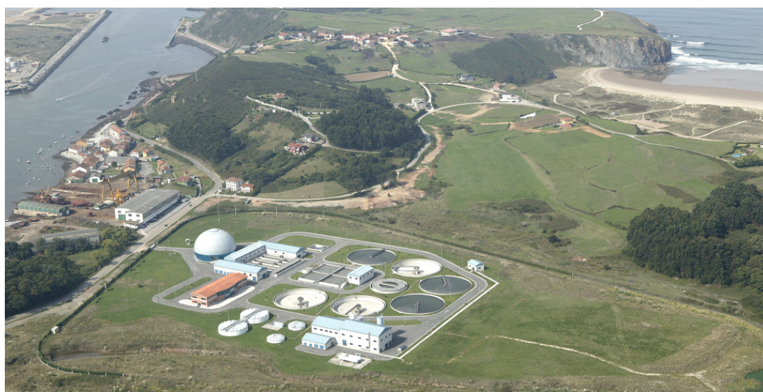
Fig. 159. Estación Depuradora de Aguas Residuales de Maqua.
