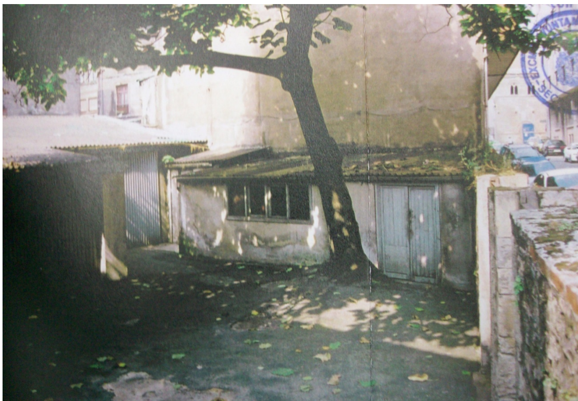
Fig. 274. Solar de la plaza de José Martí antes de la reurbanización.
