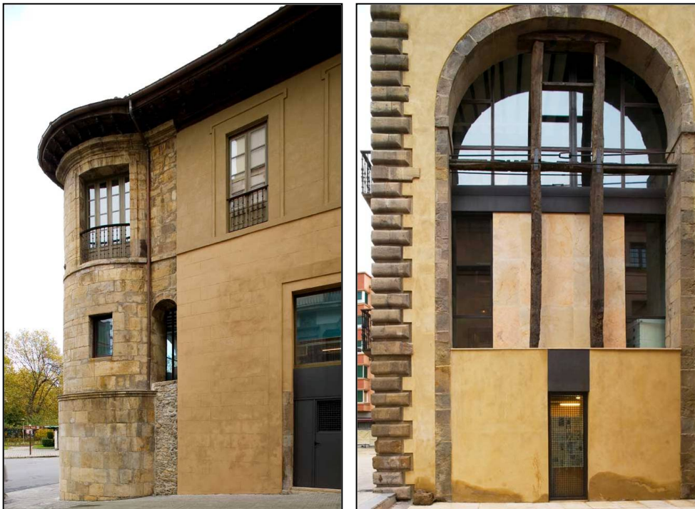
Fig. 254. Fachadas occidental y oriental.
