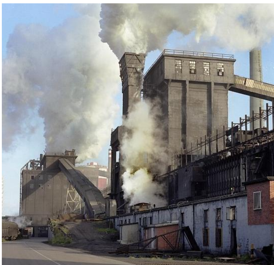
Fig. 112. Baterías de coque.
