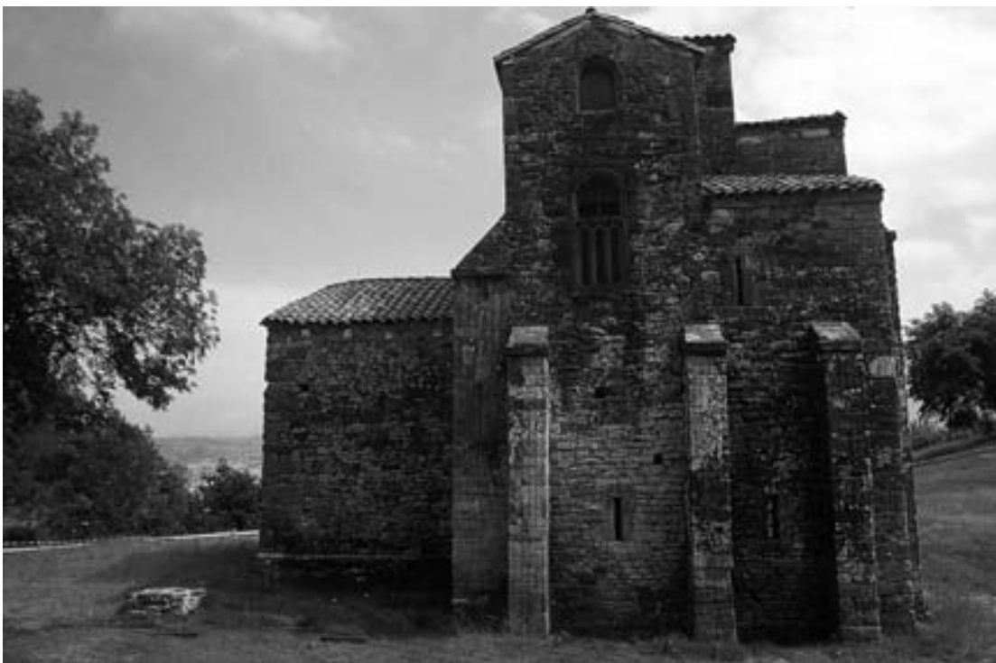
Vista norte con el sector oriental derruido
