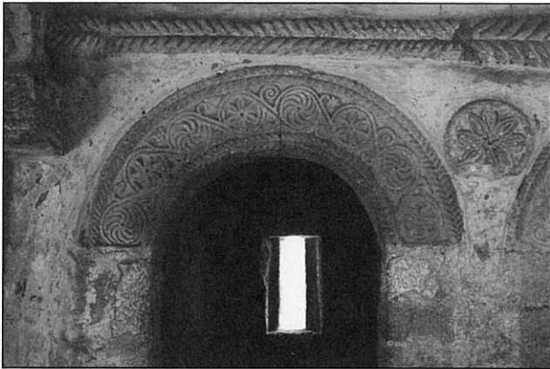
Fig. 10.- Arco monolítico del vano de la habitación sur
