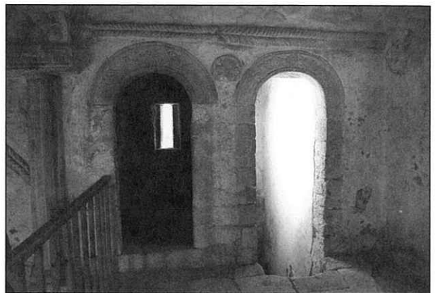
Fig. 9.- Vista hacia el sur de la tribuna, con el vano de acceso a la escalera a la derecha y el vano de la habitación izquierda
