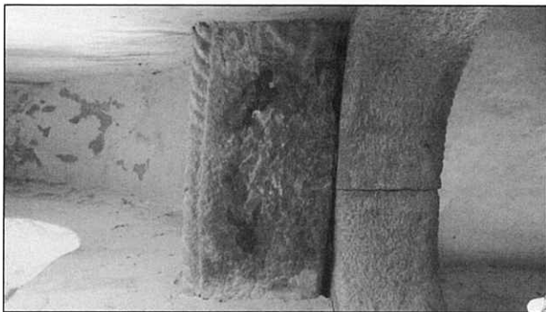
Fig. 12.- Intradós del arco monolítico del vano sur y el bloque imposta donde apoya la bóveda de la caja de la escalera
