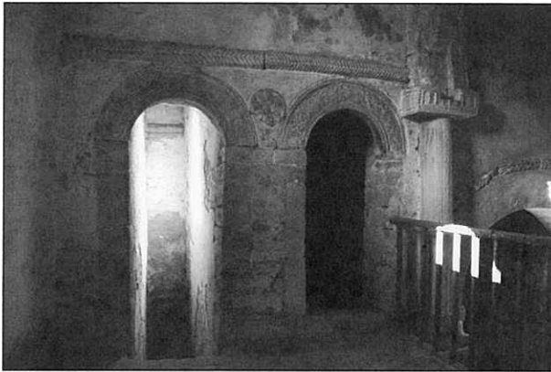
Fig. 5.- Vista hacia el norte de la tribuna, con el vano de acceso a la escalera a la izquierda y el vano de la habitación derecha
