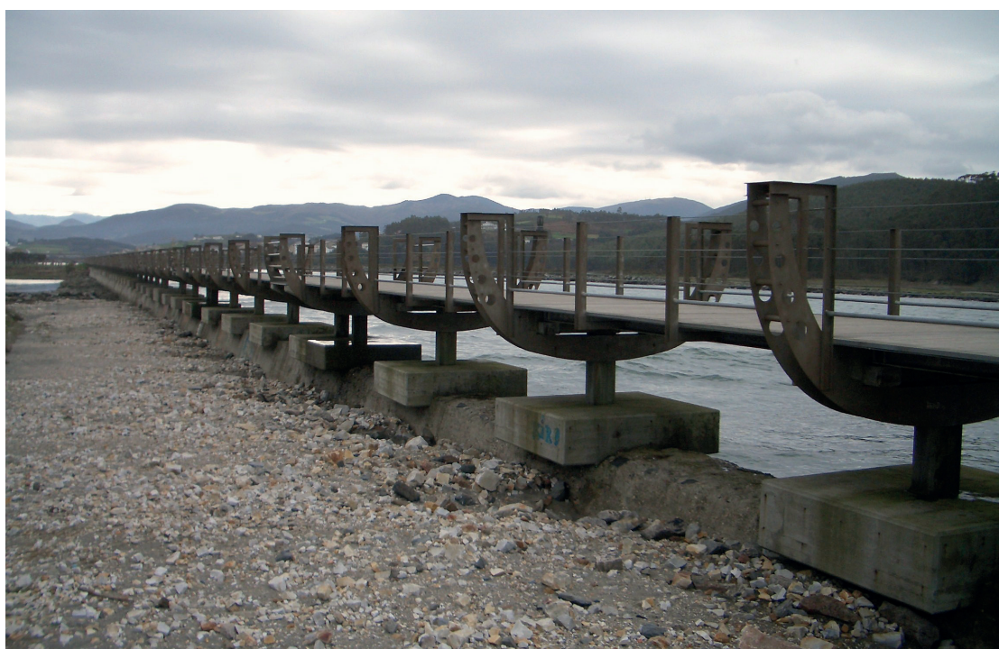
Fig. 5. Pasarela en forma de barco que forma parte del plan de mejoras de los accesos a la playa de Navia, impulsado por el ayuntamiento en 1996 y concluido en el año 2000, según diseño del equipo de los Servicios Técnicos Municipales, encabezado por el arquitecto municipal Germán Menéndez Roces e integrado además por Marcial López Rodríguez y Anibal Pérez Guerrero. Fotografía de la autora, tomada el 23 de enero de 2005.
