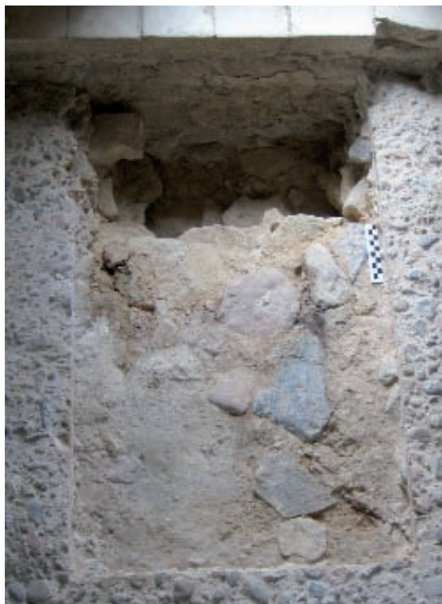
FOTO 6: Imagen del sondeo practicado en la primera planta. Se aprecia el «suelo de obra» y el relleno del seno de la bóveda con tongadas de mampuestos. También se observan restos de la carga original que quedaron sellados por la ejecución del opus .
