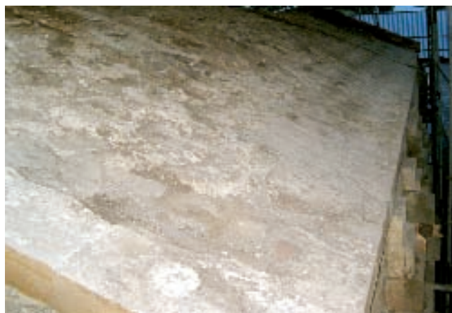
FOTO 2: Detalle de la cubierta, una vez despejada de todos los sedimentos disgregados, en la que se puede observar una banda inferior a base de aglutinante industrial que se superpone a un mortero de cal y arena blanquecino. También se pueden comprobar las características inadecuadas para la definición de una nueva cubierta sólida.
