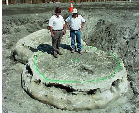
**Figura 27. Ejemplo de obra realizada con columnas de Súper Jet Grouting. Tomado de Zuloaga-Fábrega, 2004.**
