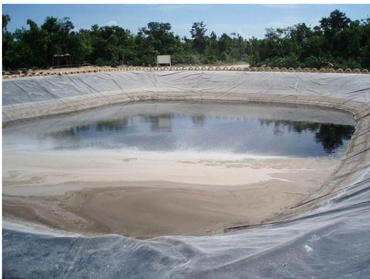
**Figura 14. Ejemplo de una balsa de regadío con geomembranas.**
