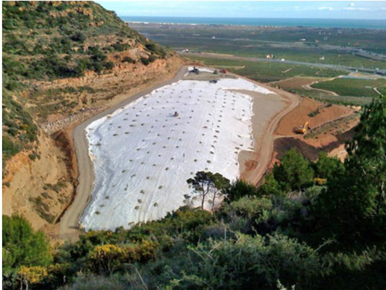
Figura 16. Ejemplo de balsa creada con geocompuestos de bentonita.
