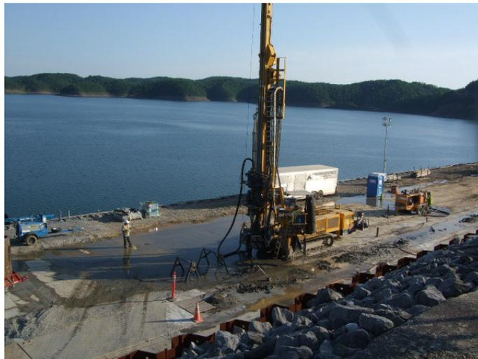
**Figura 23. Ejemplo de obra de perforación para efectuar inyecciones de cemento. Presa de Wolf Creek Kentucky EE.UU.**
