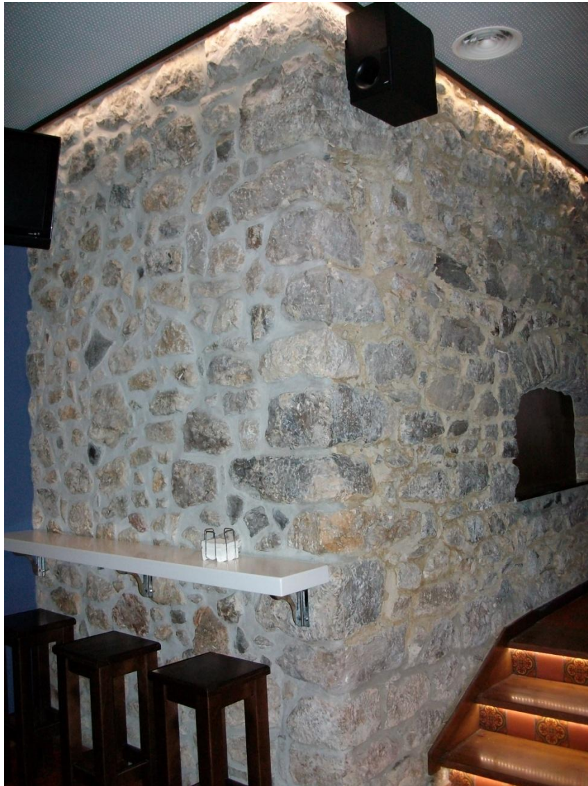
Fotografía de una esquina de la cabecera de la Capilla vistos desde el local del edificio donde antes se hallaba el Hospital.
