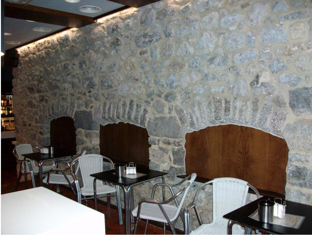
Fotografía de los vanos de comunicación por el lado del Hospital, donde se aprecia su mayor tamaño respecto al lado de la Capilla, así como los grandes sillares empleados.
