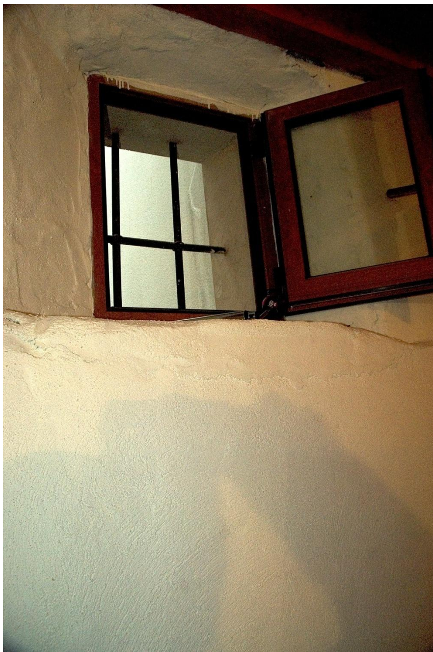
Fotografía en detalle de la parte alta del muro de de la sacristía situada delante de la cabecera de la Capilla de San Roque. Se aprecia un ventanuco practicado así como la evidente diferencia de grosor en la fábrica justo por debajo del mismo.
