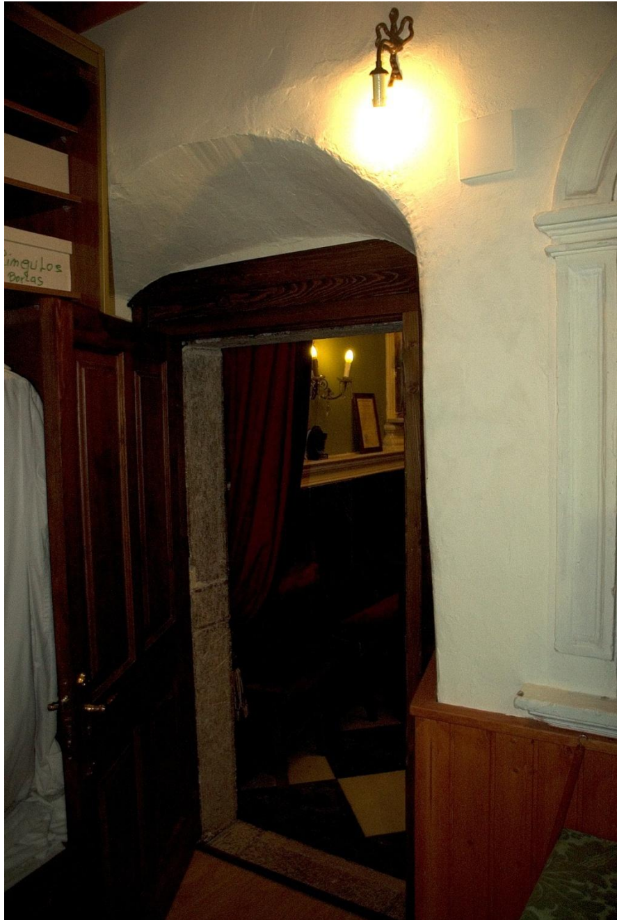
Puerta que comunica la Capilla de San Roque con la sacristía, vista desde esta última y donde se aprecian tanto el grosor de los muros interiores como la diferencia de remates en ambos lados del vano, así como el trabajo de sillería.
