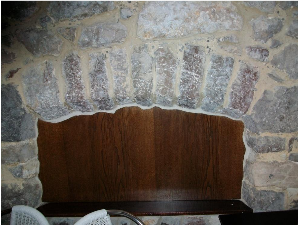
Fotografía en detalle de uno de los vanos visto desde el local anexo donde se aprecia la técnica constructiva.
