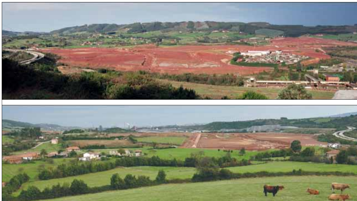
FIG. 9. Vistas de las obras de la primera fase. La fotografía superior está tomada desde el este y la inferior desde el sur. En ambas puede verse la importancia de la operación y los terrenos que aún permanecen en su estado original a la espera del desarrollo de futuras fases. Fotos del autor.
