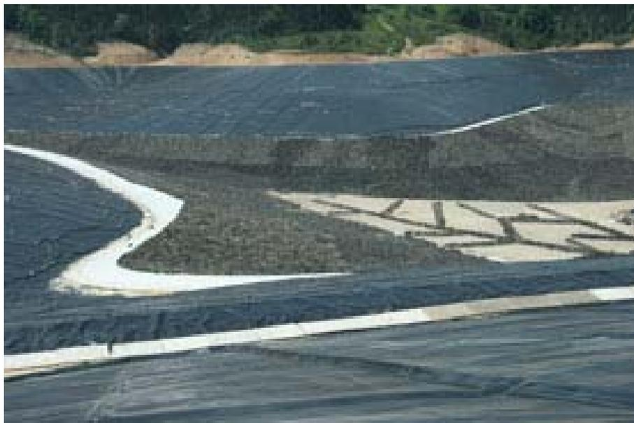
Figura 6. Revestimiento impermeable que cubre el fondo del vaso del vertedero (<http://www.cogersa.es/metaspaces/portal/14498/19172>).
