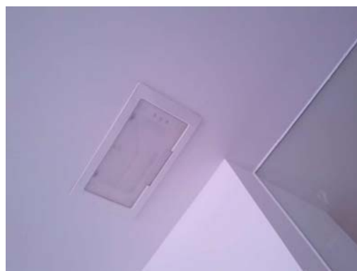
Imagen 4.4. Instalación de iluminación de emergencia. Elaboración propia.
