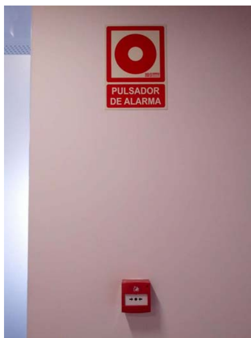
Imagen 4.3. Instalación de detectores automáticos y pulsadores manuales de alarma. Elaboración propia.
