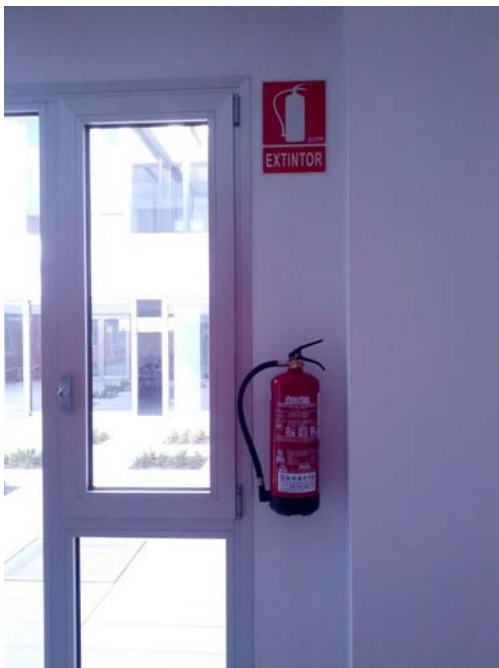
Imagen 4.2. Instalación de extintores portátiles (de Polvo y de CO2) debidamente señalizados. Elaboración propia.
