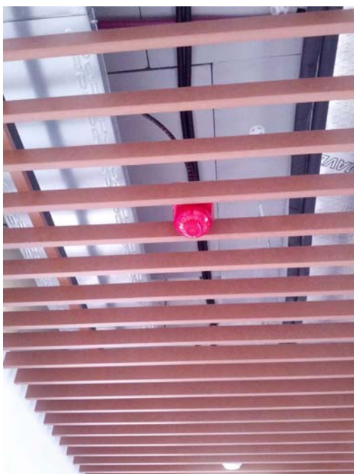
Imagen 4.3. Instalación de detectores automáticos y pulsadores manuales de alarma. Elaboración propia.
