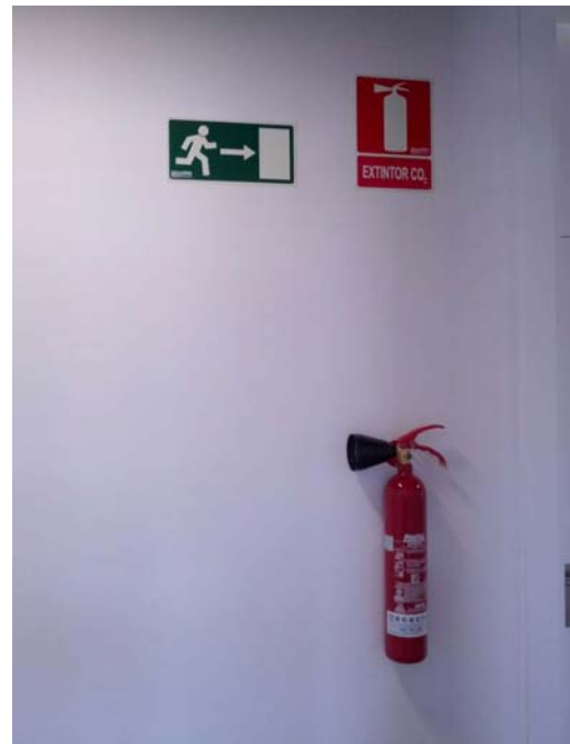
Imagen 4.2. Instalación de extintores portátiles (de Polvo y de CO2) debidamente señalizados. Elaboración propia.
