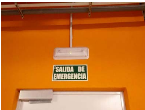
Imagen 4.4. Instalación de iluminación de emergencia. Elaboración propia.
