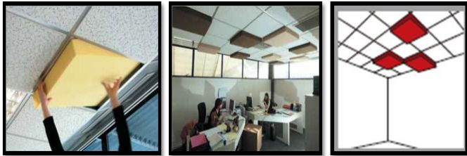
Figura 6. Colocación y vista de las placas Fractus encastradas.
