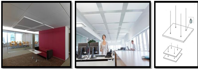
Figura 10. Ejemplos de salas con solo square y dibujo de la colocación de los cables.
