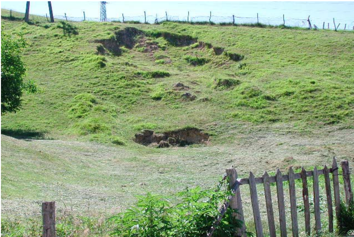
Figura 6.59. Deslizamientos superficiales sobre derrubios.
