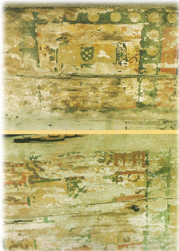
FIG. 219. SANTO DOMINGO DE CALERUEGA. Panda septentrional. Restos de la armadura de madera que la cubría. (Foto Iturgáiz)
