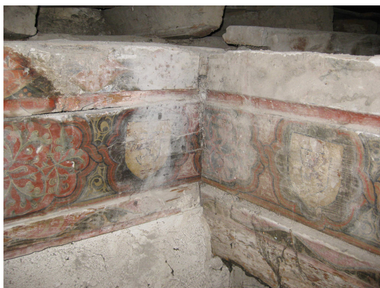
FIG.165. SANTA CATALINA DE SIENA DE VALLADOLID. Detalle de los restos de una armadura de madera en el desván situado sobre la cocina. Quizás primitiva armadura de la iglesia. Las armas parecen corresponder a las de la priora Catalina Benavides (1533-1536).
