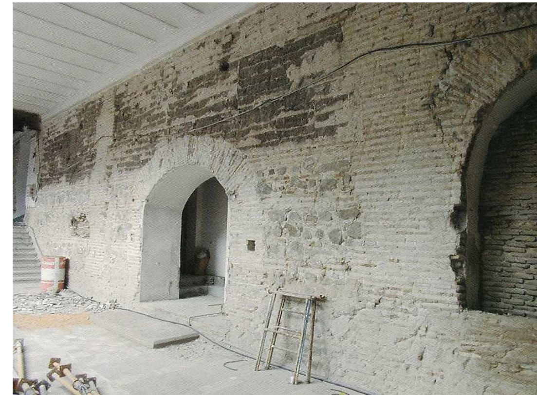
FIG.137. MADRE DE DIOS DE TOLEDO. Vista del muro que separaba coro e iglesia durante las obras de rehabilitación. (Foto: J.M. Rojas Rodríguez-Malo; A.J. Gómez Laguna; J.Perera Rodríguez; J. Pérez López-Triviño; G.M. Garrido Resino)
