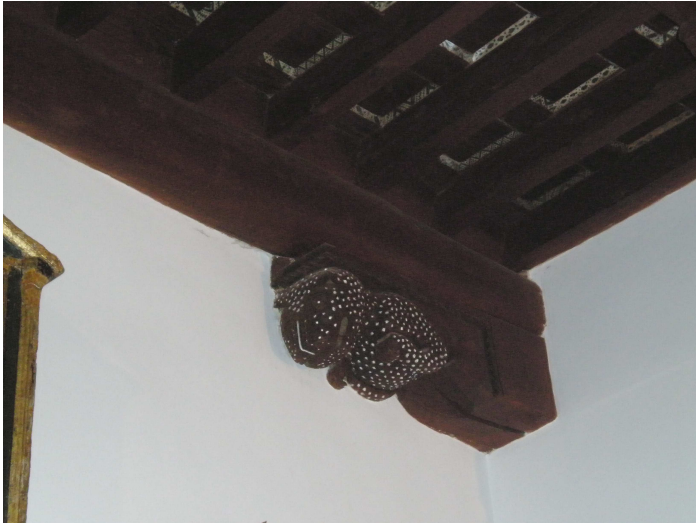
FIG.166. SAN PEDRO MÁRTIR DE MAYORGA DE CAMPOS. Detalle de la armadura de madera de la Sacristía.
