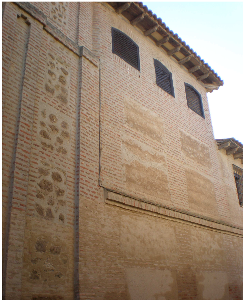
FIG. 26. NOVICIADO. EXTERIOR OCCIDENTAL DEL MONASTERIO.
