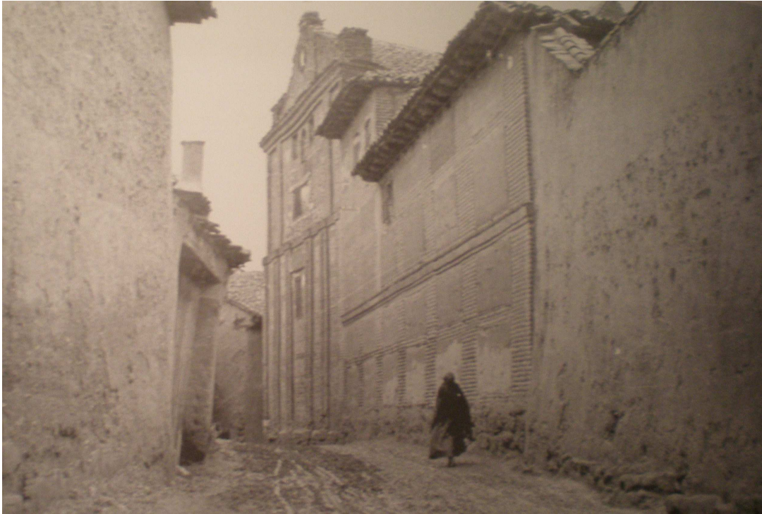
FIG. 9. VISTA DEL HASTIAL OCCIDENTAL, EXTERIOR DEL NOVICIADO Y CERCA MONÁSTICA EN 1936. FOTO. ARCHIVO DEL MONASTERIO DE SAN PEDRO MÁRTIR.
