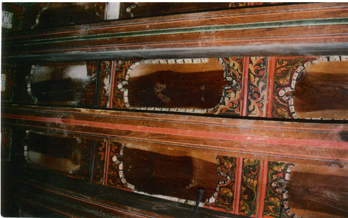
FIG. 24. DETALLE DE LA ARMADURA DE MADERA DE LOS RESTOS DE LAS CASAS DEL OBISPO LUIS DE VELASCO. ALFARDONES (AMSCV)
