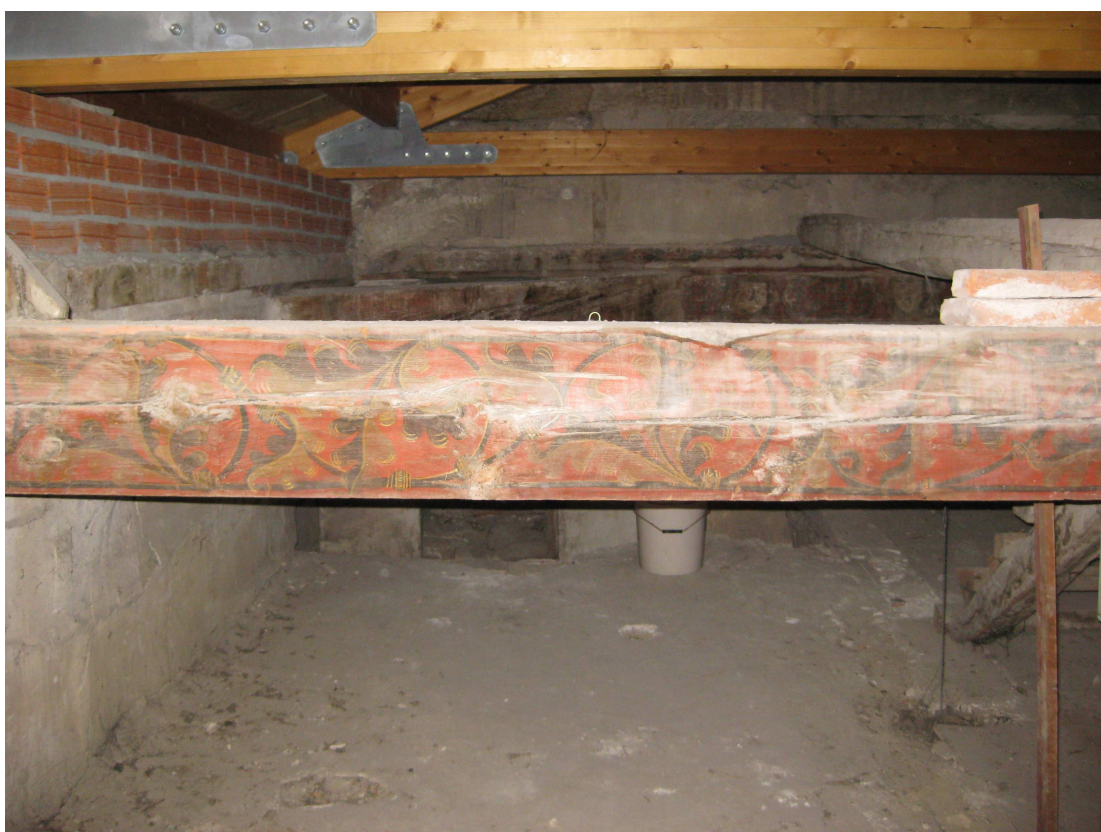
FIG. 25. DESVÁN SITUADO SOBRE LA COCINA. RESTOS DE ARMADURA DE MADERA POLICROMADA (FOTO DE SOR CRISTINA)
