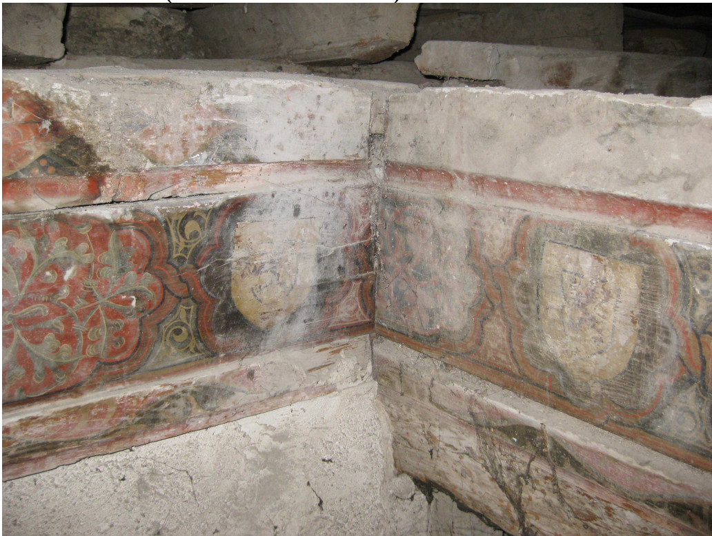
FIG.27. DETALLE DE LOS RESTOS DE UNA ARMADURA DE MADERA EN EL DESVÁN SITUADO SOBRE LA COCINA( FOTO DE SOR CRISTINA)
