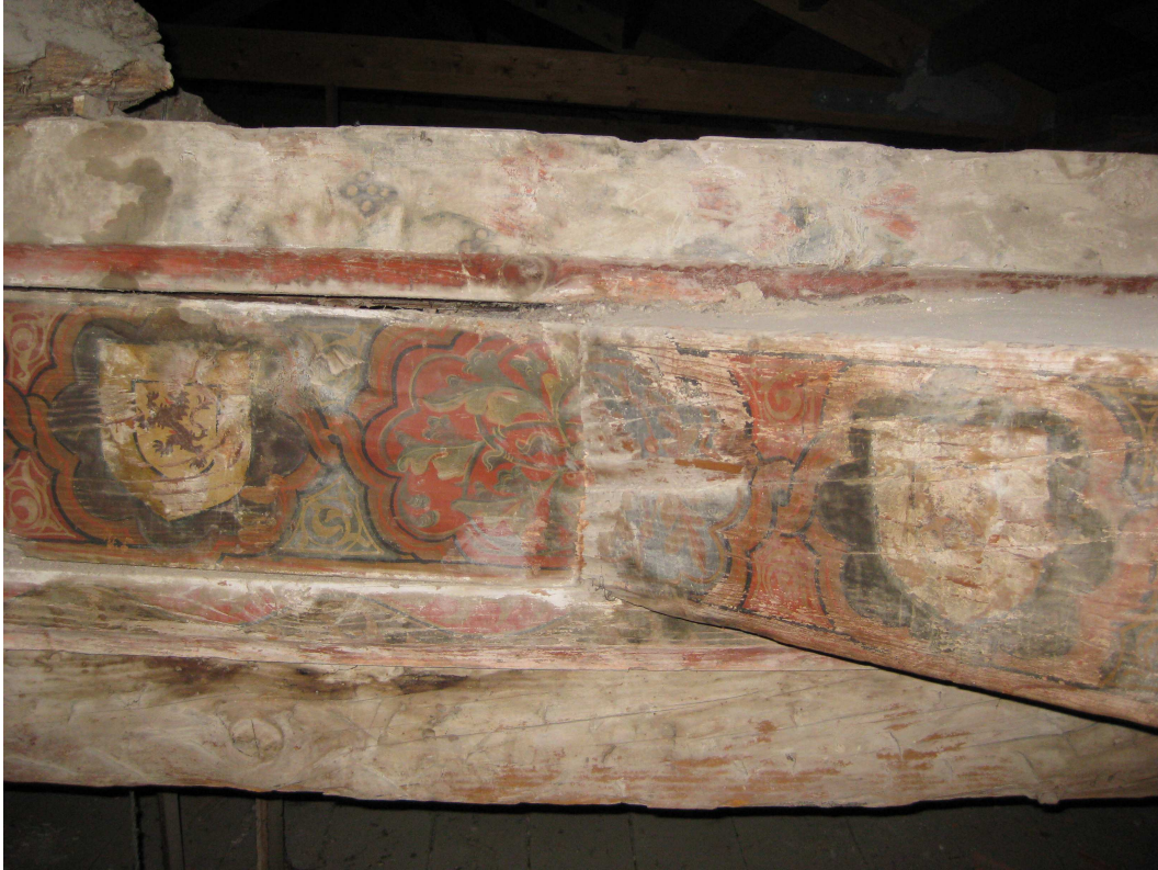
FIG.28. DETALLE DE LOS RESTOS DE UNA ARMADURA DE MADERA POLICROMADA DEL DESVÁN SITUADA SOBRE LA COCINA( FOTO DE SOR CRISTINA)
