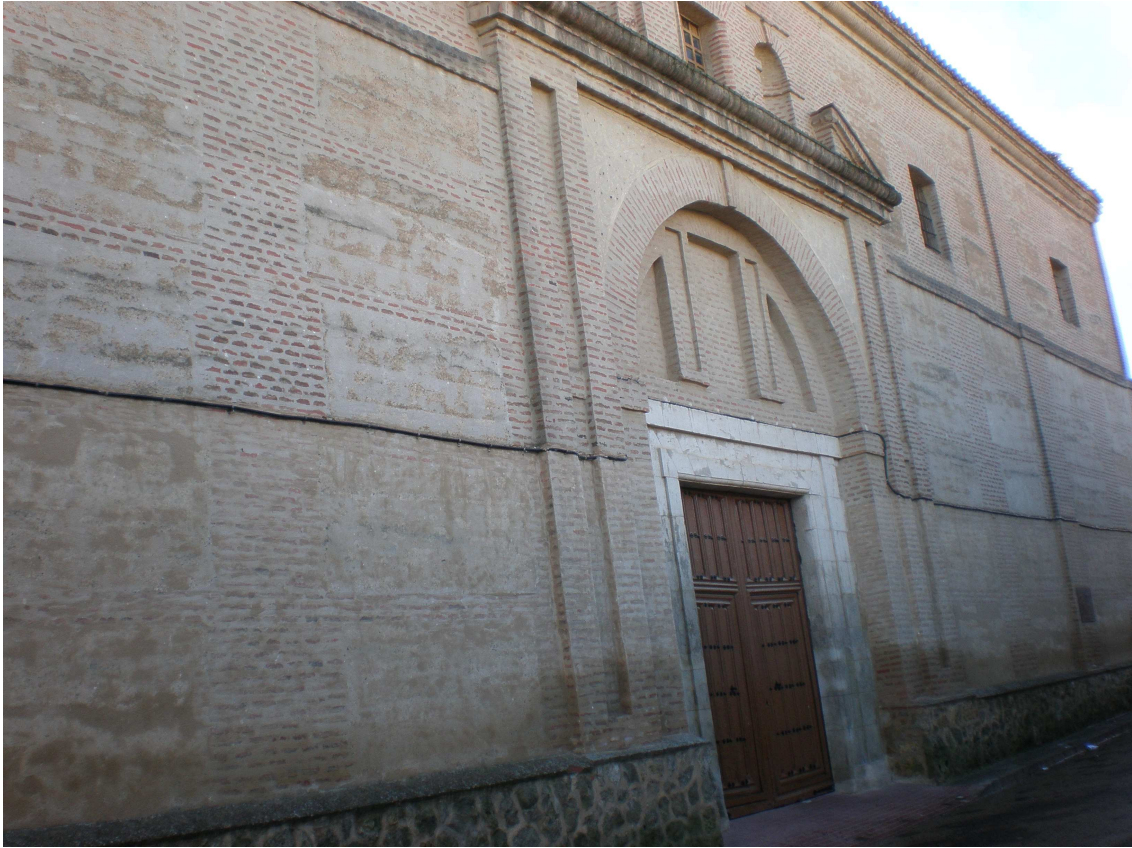
FIG. 7. PUERTA DE ACCESO A LA IGLESIA.
