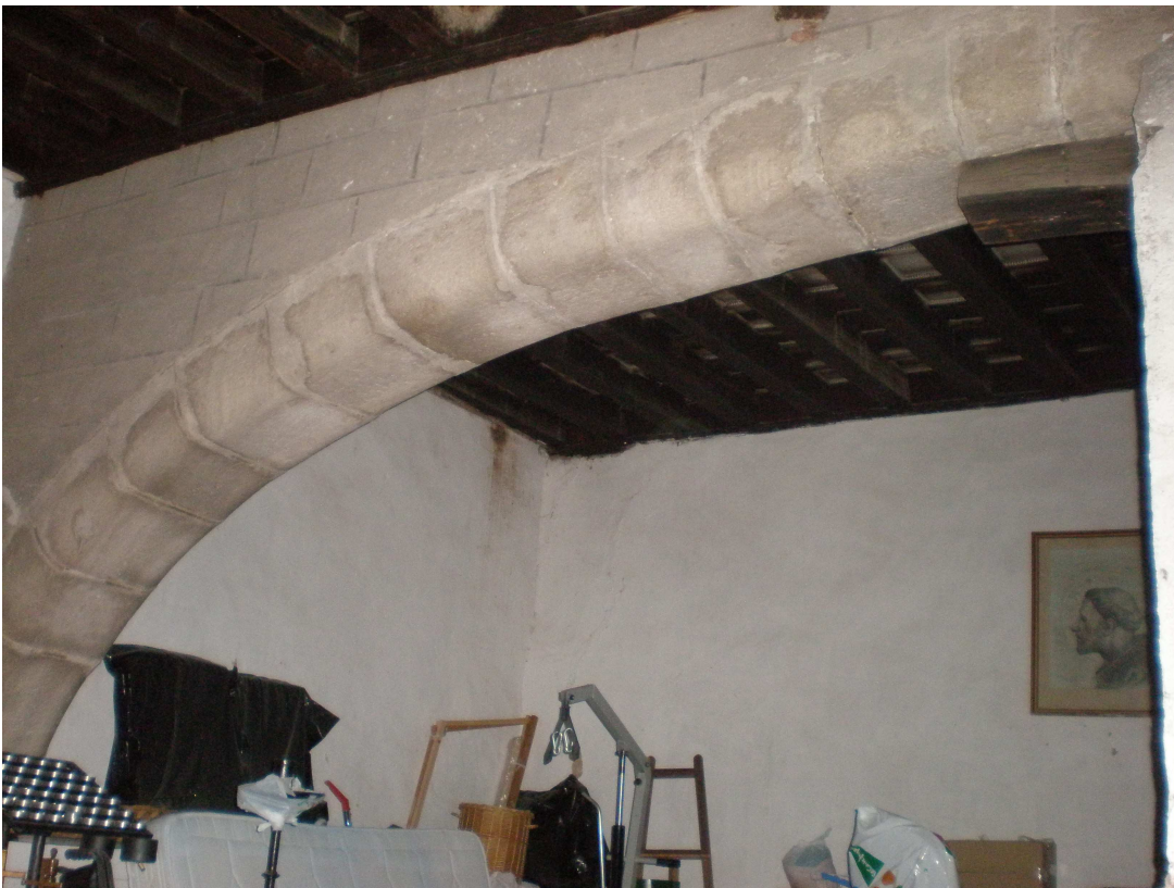
FIG. 6. ARCO DE LA ANTIGUA ERMITA DE SAN MIGUEL.
