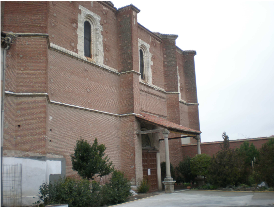
FIG. 6. EXTERIOR DE LA IGLESIA.
