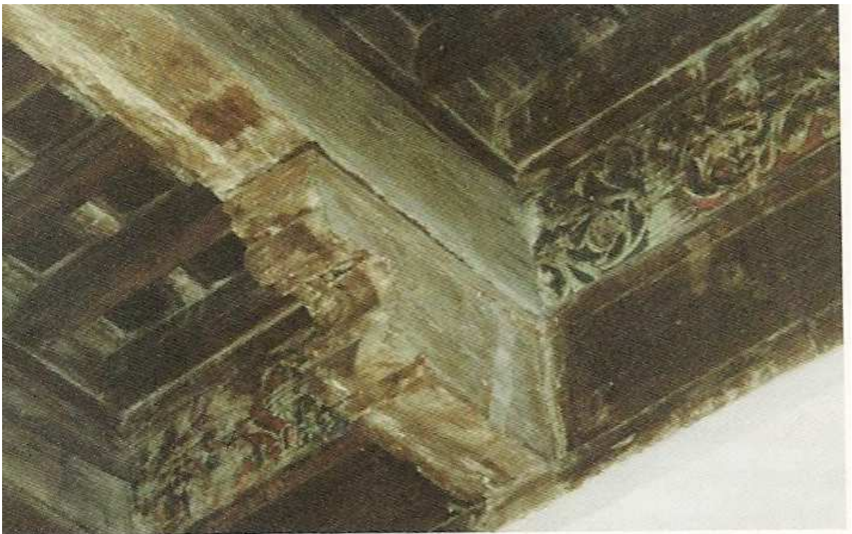
FIG. 12. ARMADURA DE MADERA DEL REFECTORIO VIEJO.
