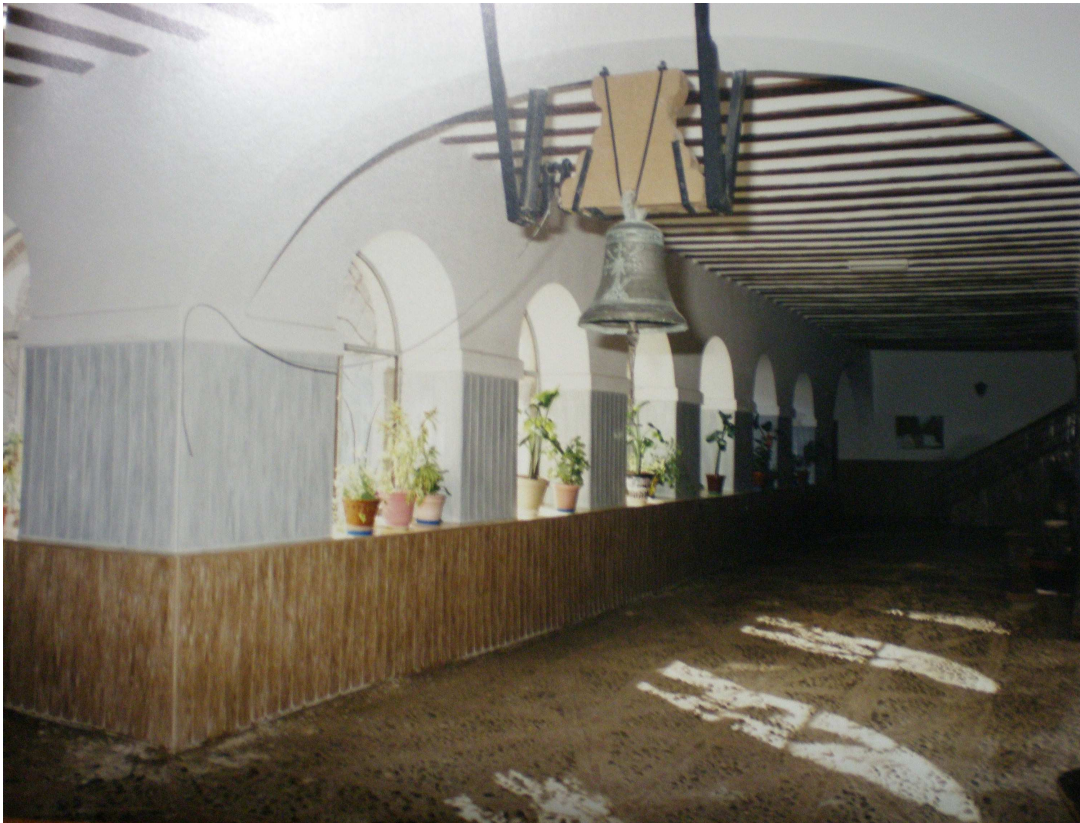
FIG. 17. CLAUSTRO GRANDE ANTES DE LA ELIMINACIÓN DEL EMPEDRADO.
