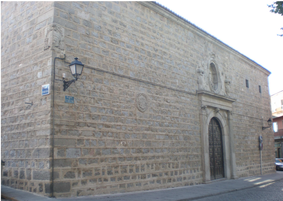
FIG. 2. FACHADA DEL MONASTERIO. ESQUINA ENTRE LA PLAZA DE ITALIA Y LA CALLE LESQUINAS.
