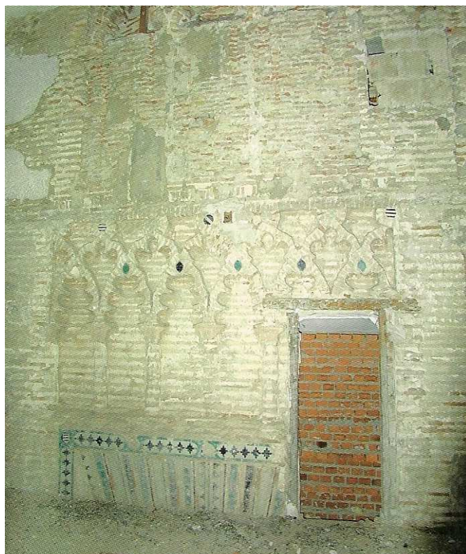
FIG. 17. ESTADO DE LA PORTADA EN EL CURSO DE LAS OBRAS DE RESTAURACIÓN.
