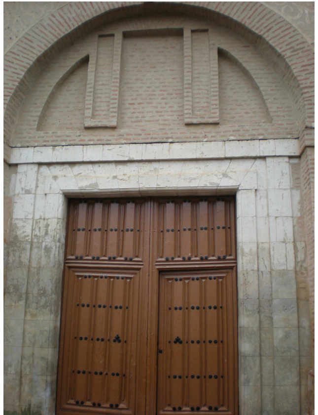
FIG. 6. PUERTA DE ACCESO A LA IGLESIA.
