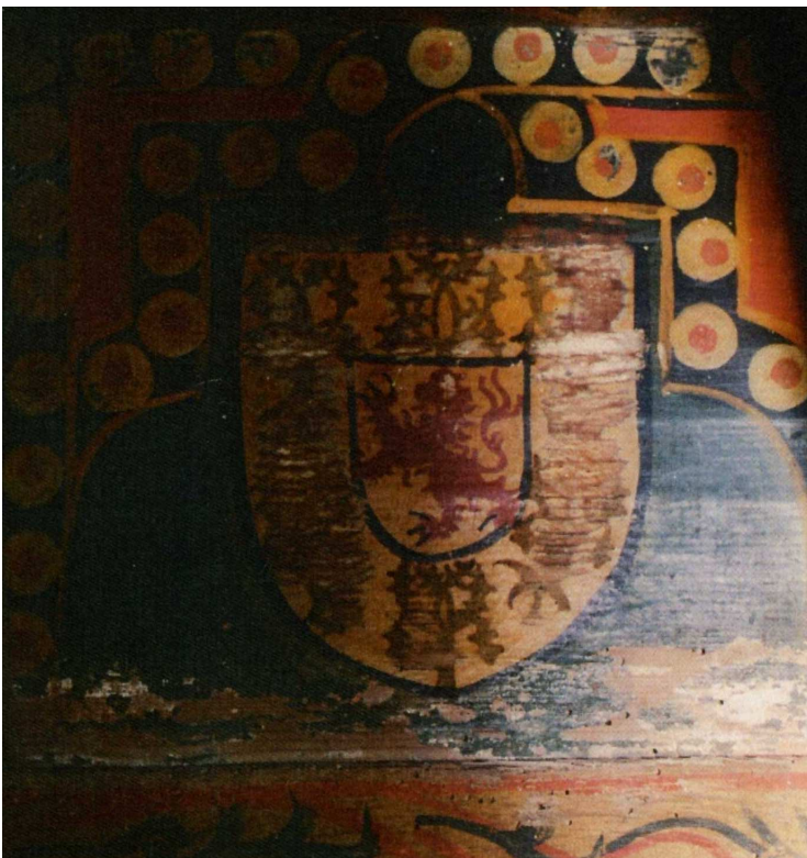
FIG. 23. ARMADURA DE MADERA. RESTOS DE LAS CASAS DEL OBISPO LUIS DE VELASCO. DETALLE DE TABICA CON ESCUDO.(AMSCV)
