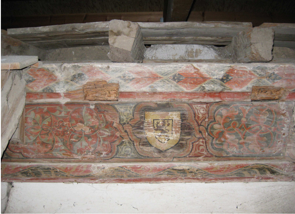
FIG.26. DETALLE DE UNA VIGA DE MADERA POLICROMADA DEL DESVÁN SITUADO SOBRE LA COCINA( FOTO DE SOR CRISTINA)
