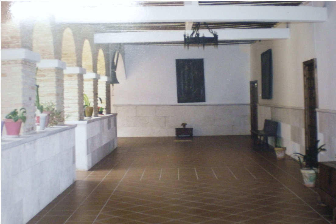
FIG. 19. ESTADO ACTUAL DEL PISO BAJO DEL CLAUSTRO PRINCIPAL.
