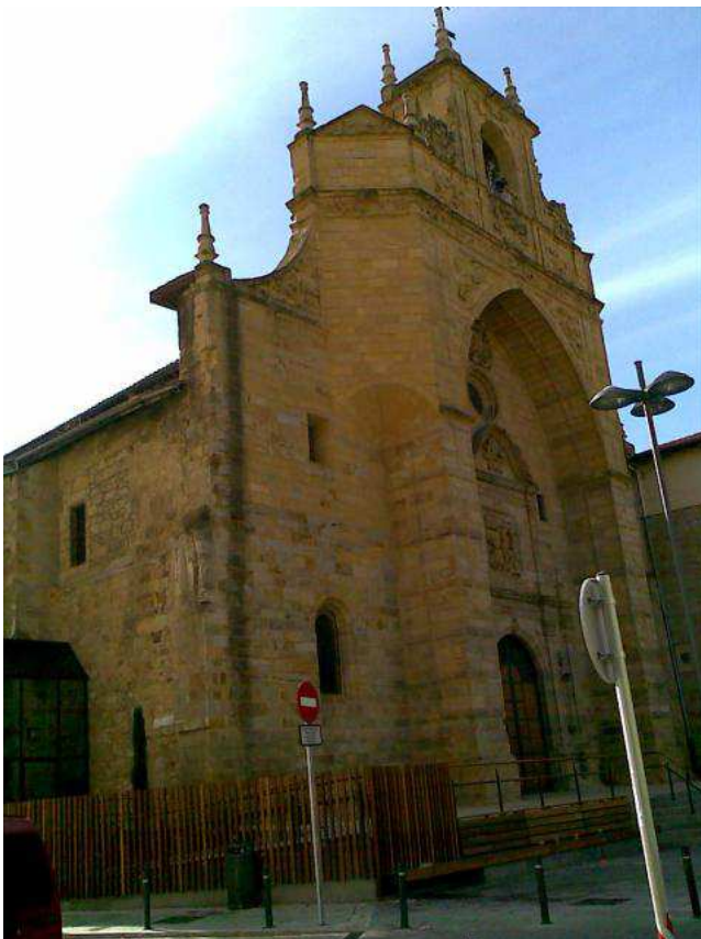
FIG.5. VISTA LATERAL DE LA FACHADA DE LA IGLESIA
