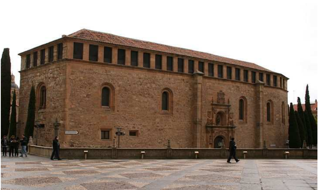
FIG. 4. EXTERIOR DE LA IGLESIA.
