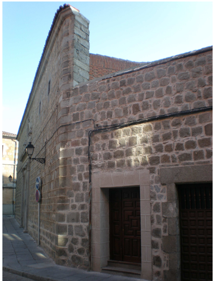
FIG. 4. VISTA LATERAL DE LA ANTIGUA FACHADA DEL MONASTERIO DE SANTA CATALINA DESDE LA CALLE FERREAL HERNÁNDEZ.
