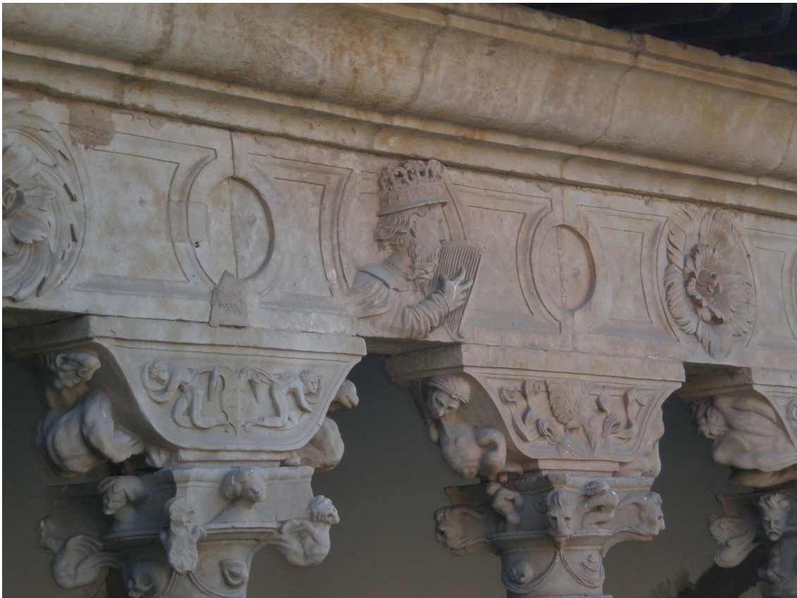
FIG. 42. DETALLE DEL FRISO DE LA GALERÍA ALTA DEL CLAUSTRO.
