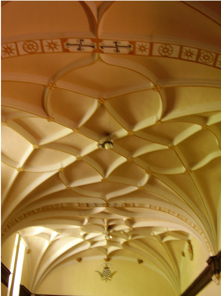
FIG.3. BÓVEDA DEL CORO.
