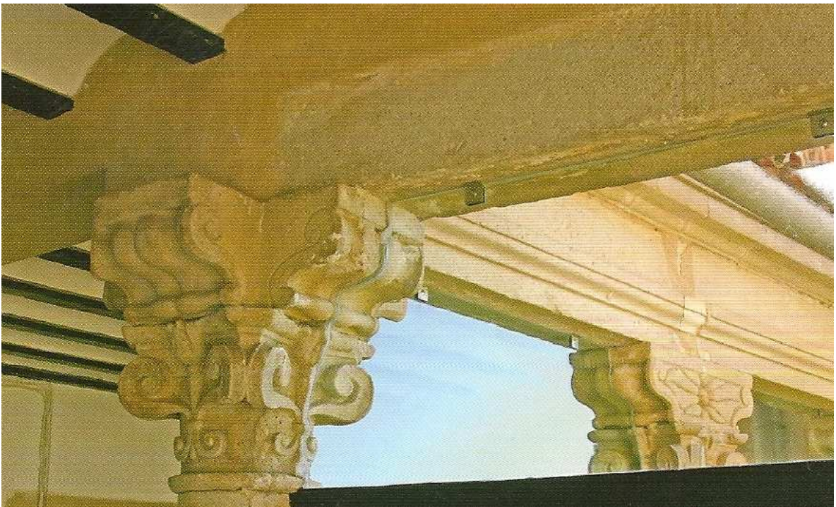
FIG. 35. CAPITEL CON VOLUTAS Y ZAPATAS. DETALLE DE LA GALERÍA SUPERIOR DEL CLAUSTRO.
