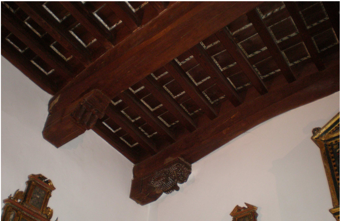
FIG. 30. SACRISTÍA. ARMADURA DE MADERA.
