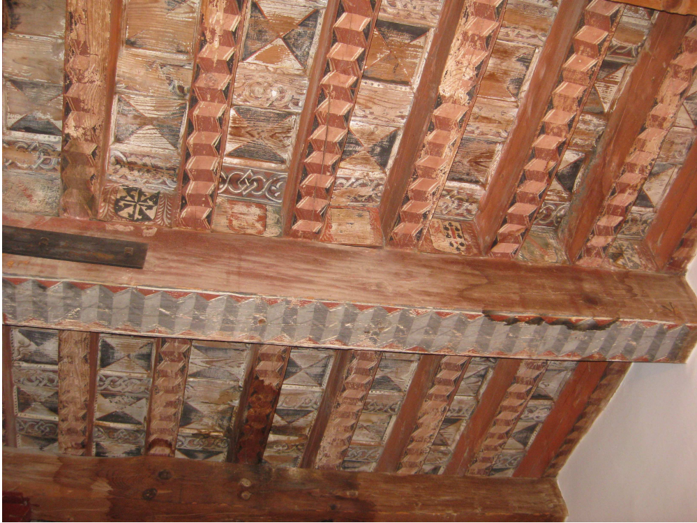
FIG. 14. ALFARJE DE LA SALA CAPITULAR. PUEDE VERSE COMO LA PARED DIVISORIA ENTRE ESTA DEPENDENCIA Y LA SACRISTÍA INTERRUMPE EL ALFARJE. ( FOTOGRAFÍA DE SOR CRISTINA)
