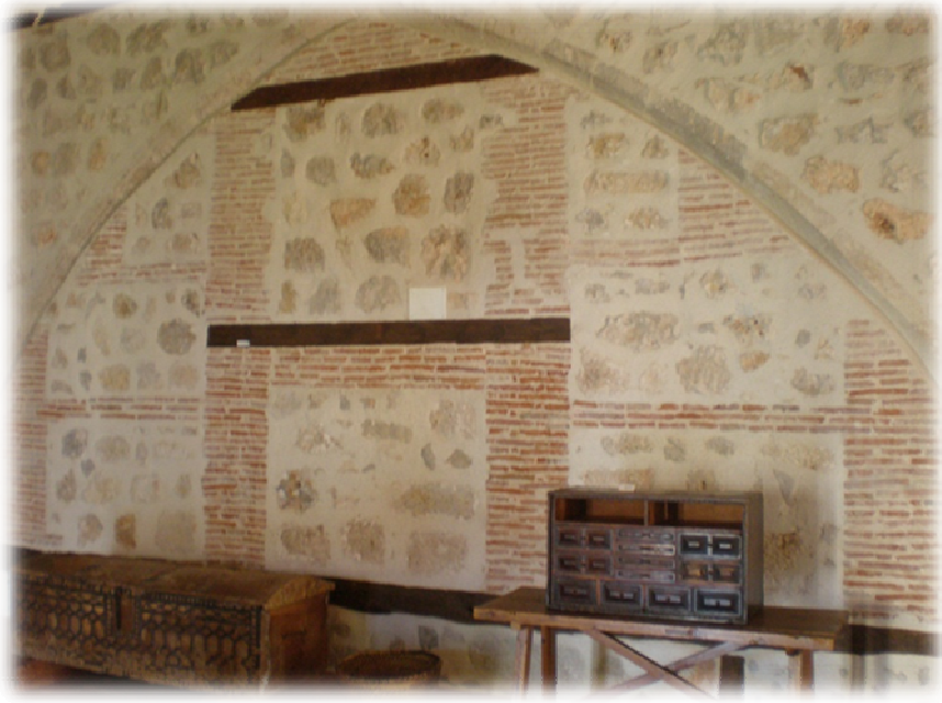
FIG. 33. PANDA SEPTENTRIONAL. SALÓN GÓTICO. ARCO EN EL MURO MERIDIONAL.
