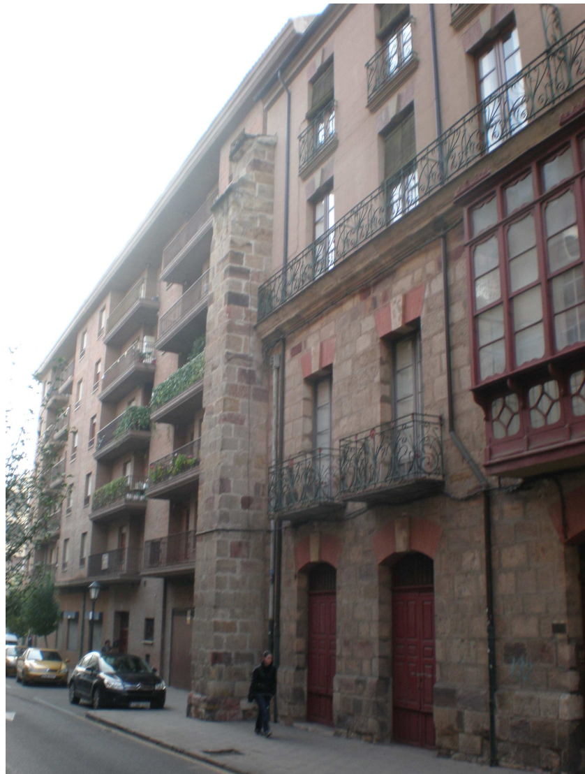
FIG. 60. CONTRAFUERTE DEL ANTIGUO MONASTERIO DE SAN PABLO.
