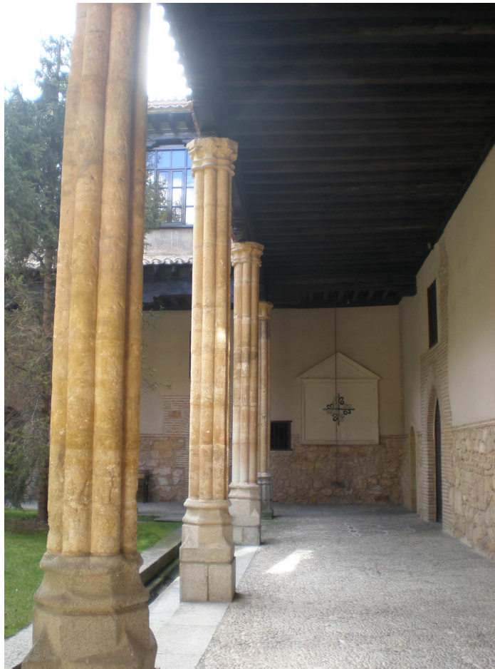
FIG.18. CLAUSTRO. PANDA OESTE. DETALLE COLUMNAS.
