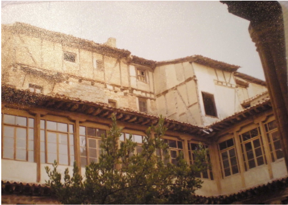
FIG.25. CLAUSTRO. PANDA NORTE. SE APRECIA EL RECRECIMIE NTO DE LA ESTRUCTURA MEDIEVAL CON UNA TERCERA PLANTA FOTO ASDR..
