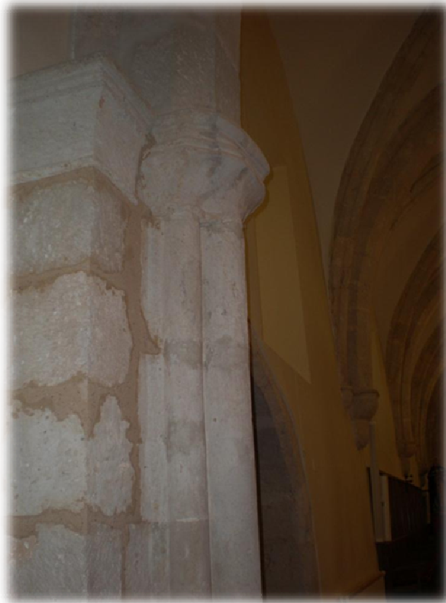
FIG.11. HAZ DE COLUMNILLAS QUE SUSTENTAN EL ARCO TORAL QUE PROBABLEMENTE SEPARABA LA NAVE DEL TEMPLO MONÁSTICO DE LA CABERCERA DESAPARECIDA A FINALES DEL SIGLO XVI.
