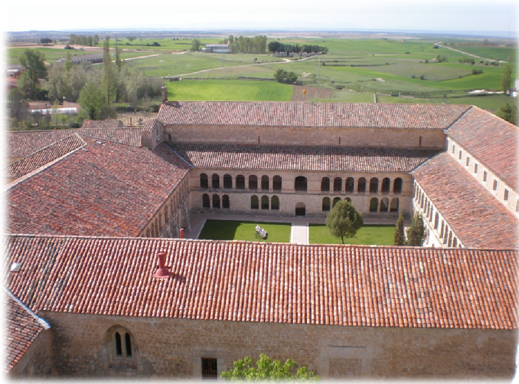
FIG. 13. VISTA DEL CLAUSTRO DE SANTO DOMINGO DE CALERUEGA DESDE EL TORREÓN.
