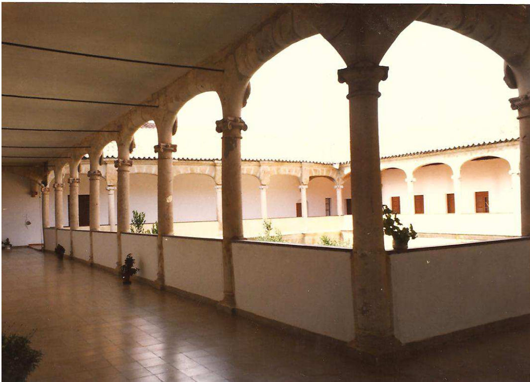
FIG.56. ESTADO DEL CLAUSTRO ALTO ANTES DE ACRISTALARSE LA GALERÍA.
