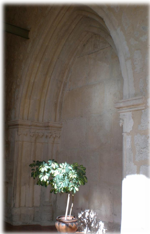
FIG.24. PANDA ORIENTAL. POSIBLE PUERTA DE ACCESO A LA SALA DE MONJAS.
