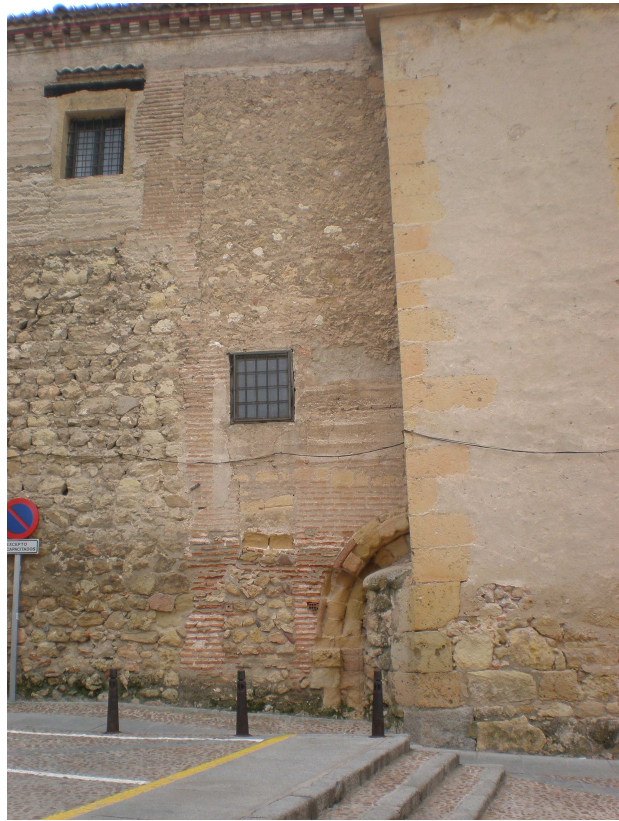
FIG. 11. ANTIGUA PUERTA DE ACCESO A LA CASA –FUERTE QUE FUE TAPIADA AL CONSTRUIRSE LA IGLESIA.
