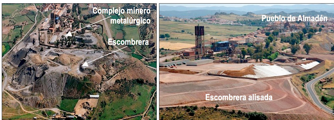
Figura 52. Instalaciones minero-metalúrgicas de la mina de Almadén. A la izquierda, la escombrera de calcinados antes de las labores de restauración; a la derecha, durante los trabajos de rehabilitación (Oyarzun et al., 2011).
