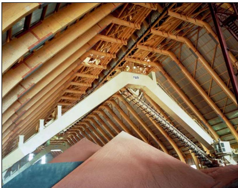
Figura 146: Apilamientos cónicos en sistemas cerrados
