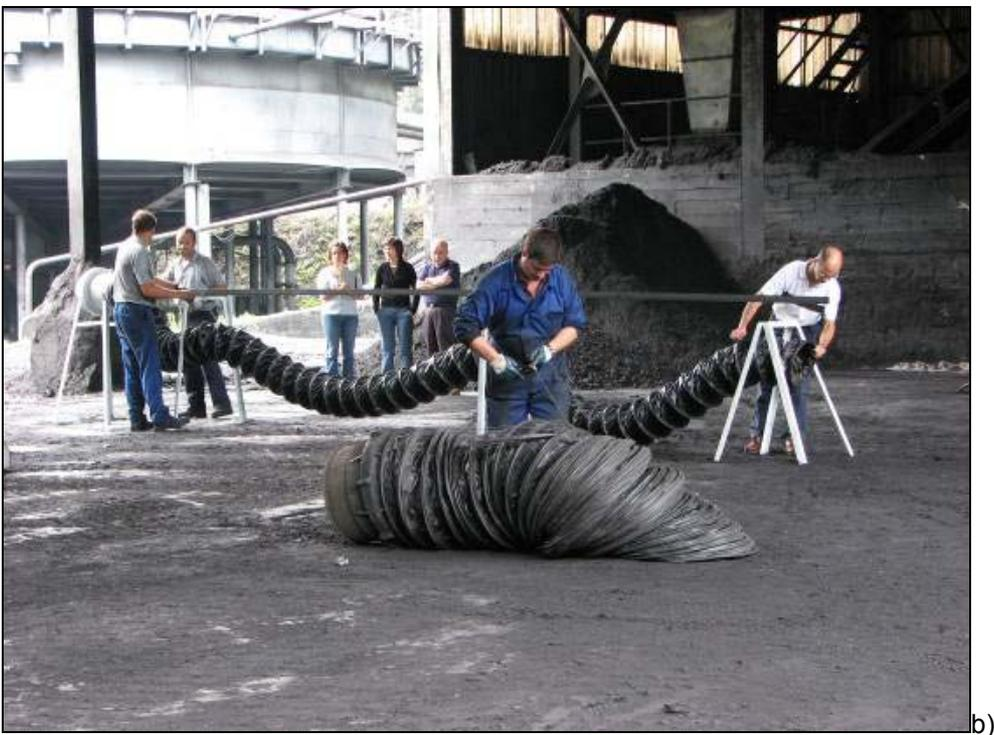
Figura 3: Montaje del ventilador y la tubería de ventilación
