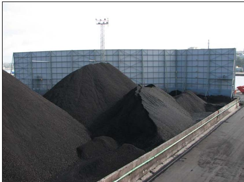
Figura 228: Pantallas artificiales en apilamiento portuario a la intemperie
