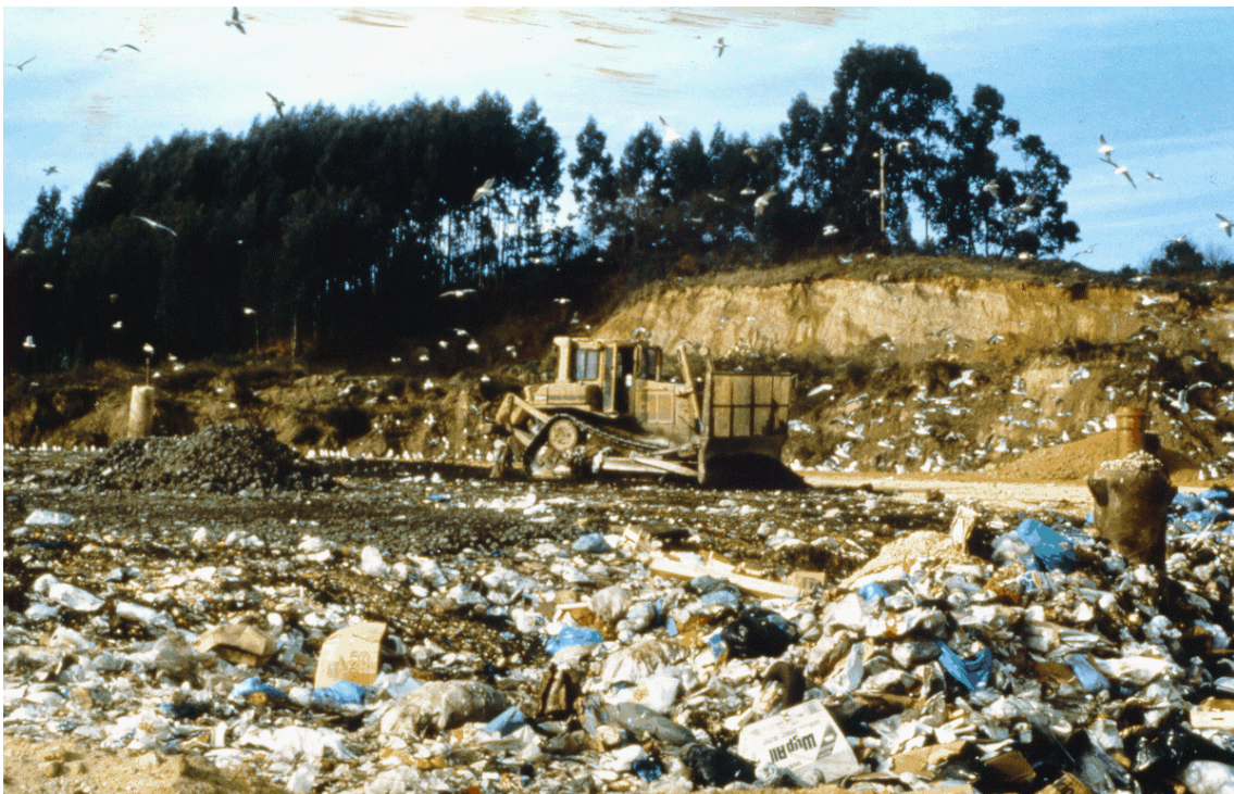
Fotografía 4c. Fases en el vertido por área: (c) Rcubrimiento
