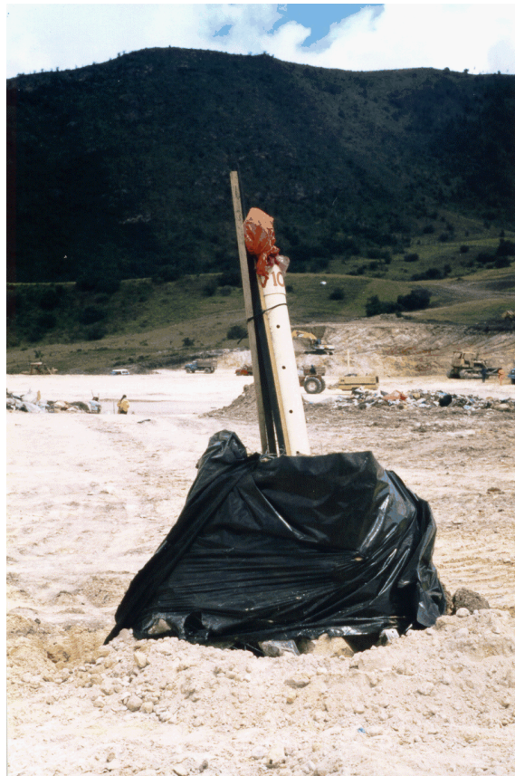
Fotografía 9a. Distintas chimeneas de venteo del biogás: (a) Doña Juana, Bogotá
