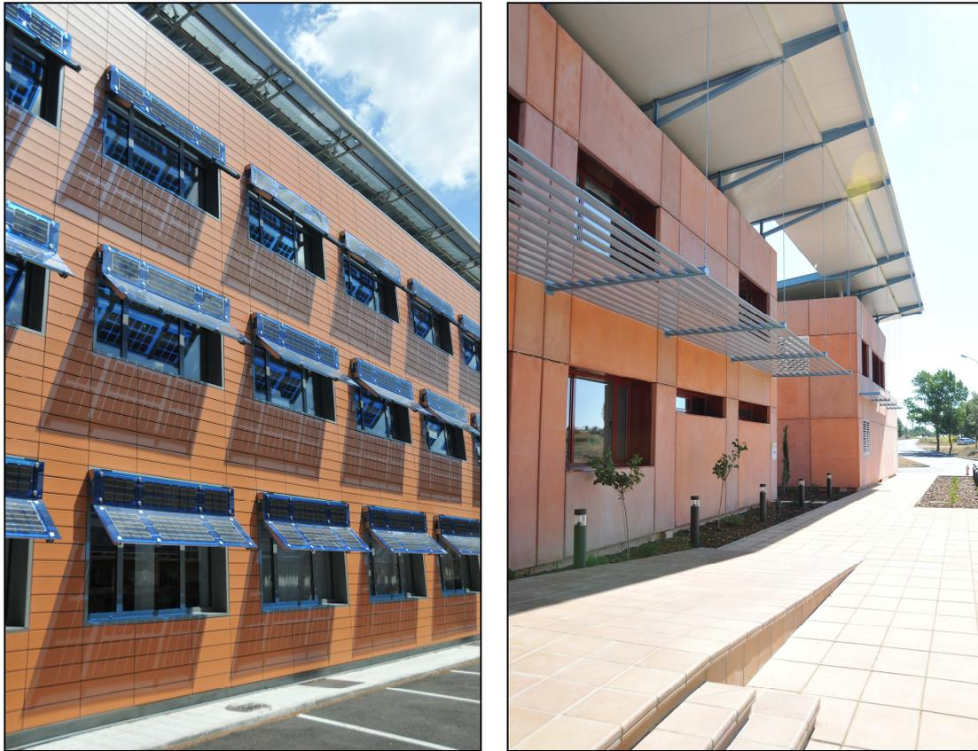
*Figura 1.6. Fachadas ventiladas dentro del PSE-ARFRISOL. Imagen izquierda: CDdI EDIFICIO-70. Fachada con plaquetas cerámicas uniformes; imagen derecha: CDdI CEDER. Fachada ventilada con plaquetas de diferentes tamaños hechas de GRC.*
