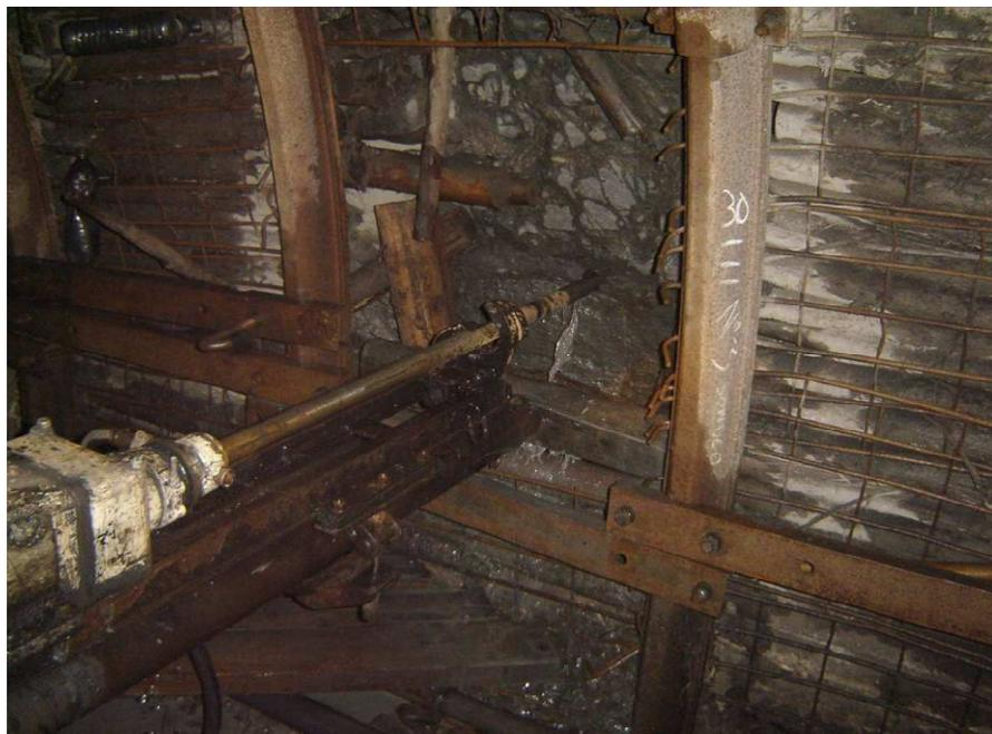
**Figura 13.** Ejecución de sondeo de desgasificación
