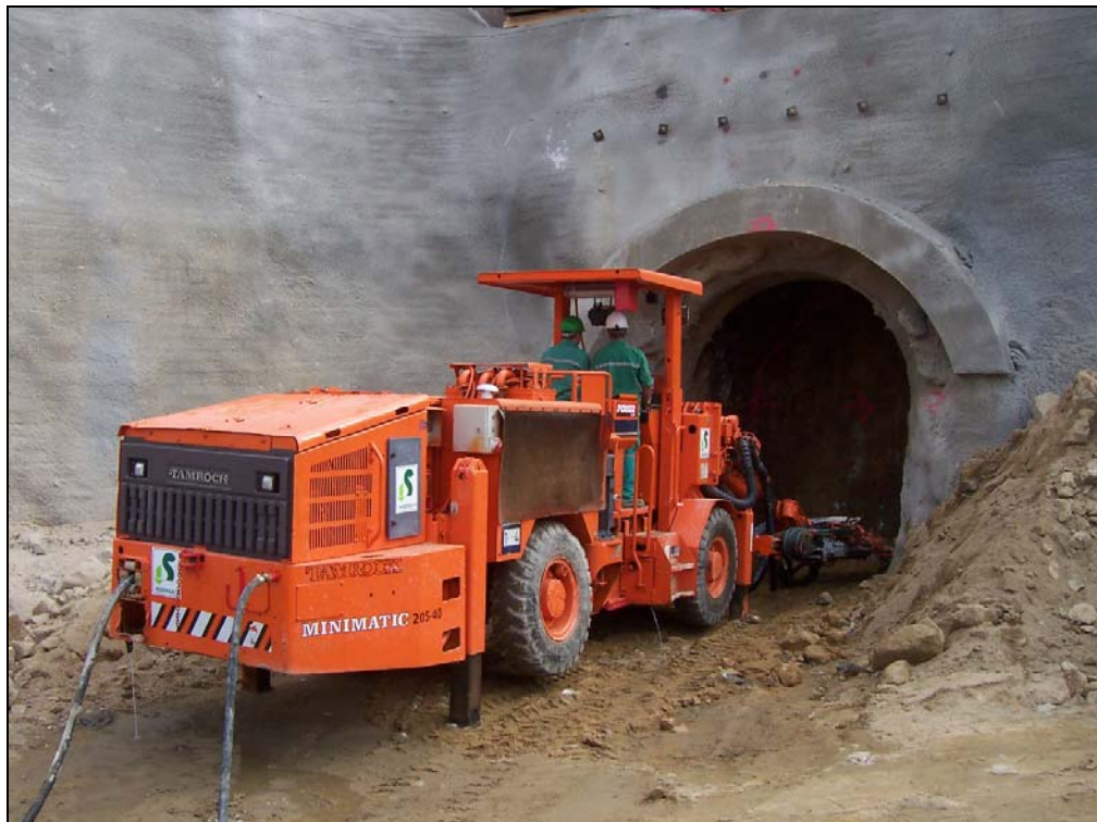
Ilustración 27: Emboquille del túnel "A Malata". Obsérvese lo ajustado de la maquinaria de perfil bajo a la sección (fotografía propiedad del autor)
