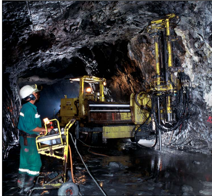
Ilustración 20: Perforación de cámaras de producción con SIMBA H254 en la mina de oro de Carlés (Asturias)
