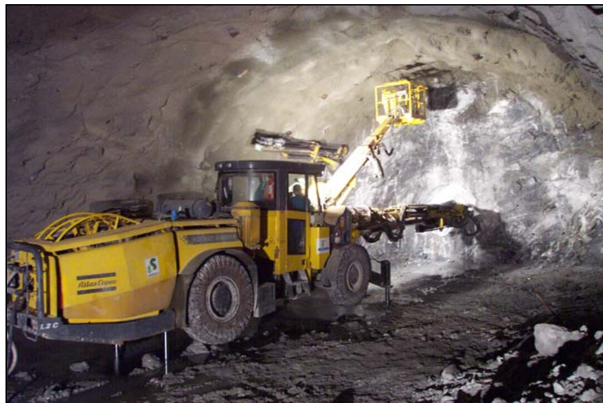
Ilustración 17: Jumbo semirrobotizado Atlas Copco L2C trabajando en el frente del túnel (Túnel de Gobantes, línea Córdoba-Málaga de Alta Velocidad. INSERSA, 2003).
