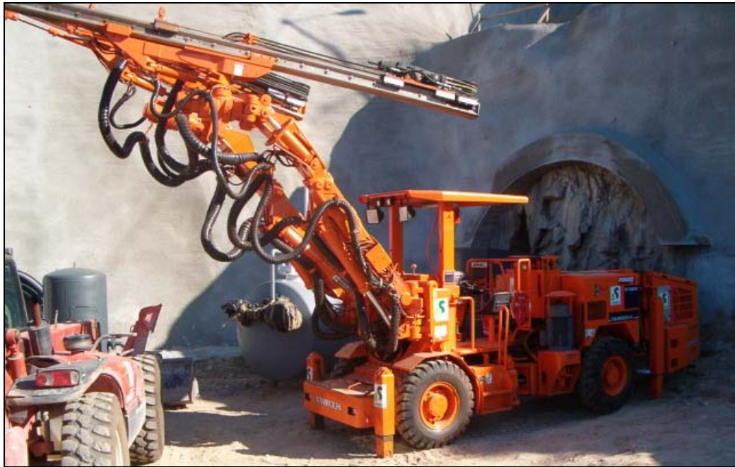
Ilustración 36: Jumbo Minimatic 205-40. Al fondo se observa la viga de atado del emboquille del túnel que nos da idea del tamaño de la sección (fotografía del autor)
