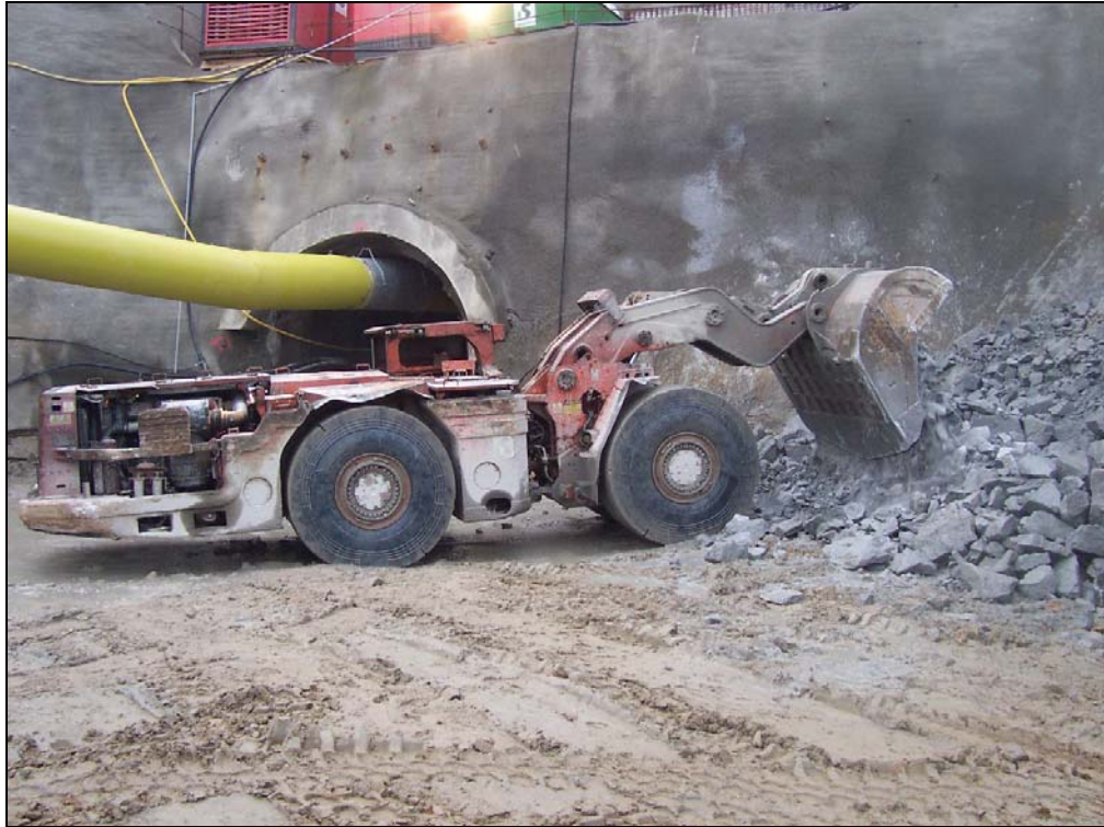
Ilustración 29: Pala de perfil bajo desescombrando en el túnel de A Malata (Fotografía propiedad del autor)
