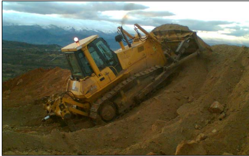
Ilustración 56: Bulldózer Caterpillar D7R realizando arranque mecánico (fotografía del autor)
