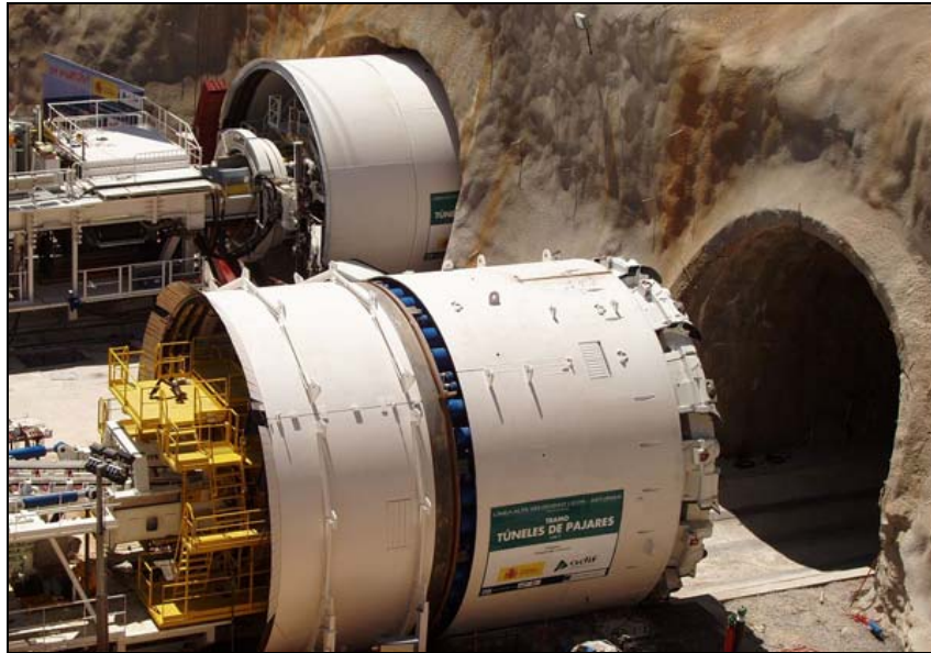
Ilustración 15: Tuneladoras Lote-1 de los Túneles de Pajares ( www.adif.es )
