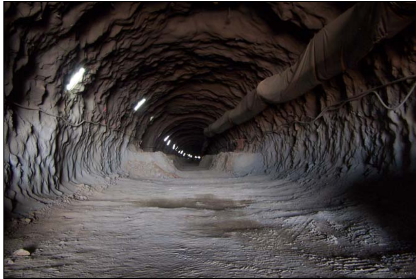
Ilustración 16: Fotografía de un túnel de autovía, con excavación en avance y destroza. Obsérvese la sección irregular del túnel con sostenimiento primario en espera del revestimiento definitivo. Fotografía cortesía de INSERSA (2006)
