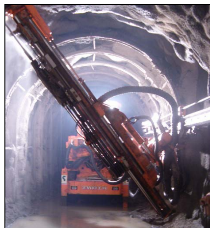
Ilustración 31: Jumbo barrenando pernos transversalmente al eje del túnel (Fotografía del autor)
