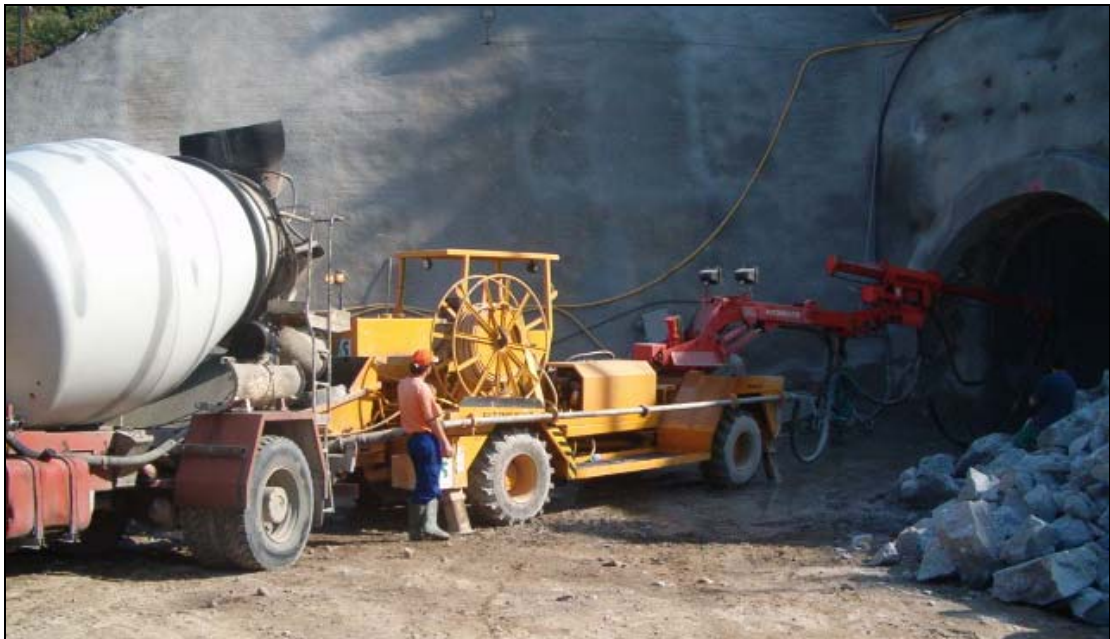
Ilustración 34: Robot Putzmeister WKM 103 gunitando en el túnel A Malata (Fotografía del autor)
