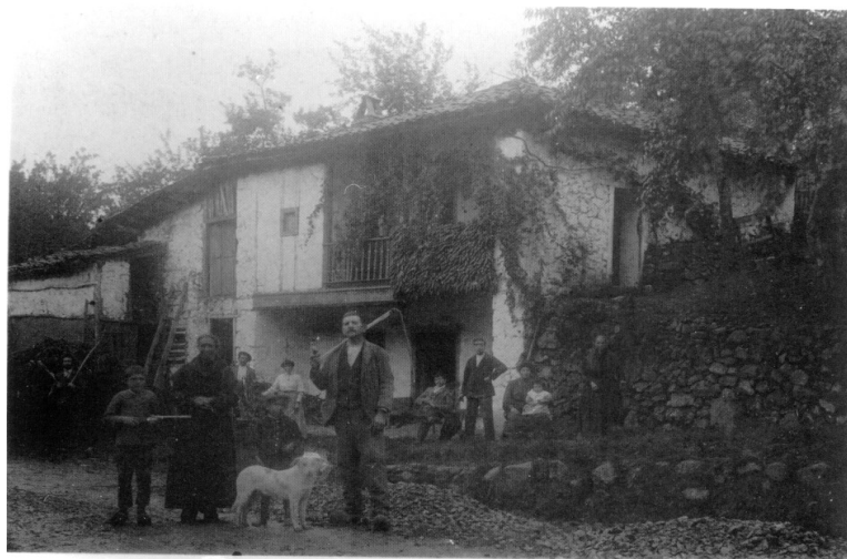
Foto 3.7 Casería en Torazo (Cabranes) 154
