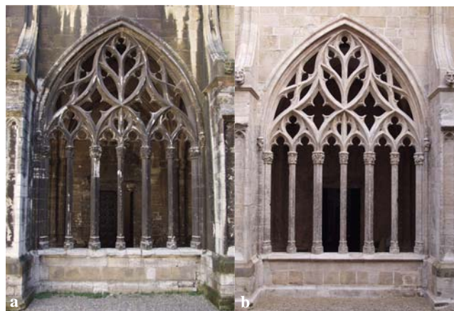
Figura 8. Aspecto de un ventanal del claustro antes (a) y después (b) de la intervención.
