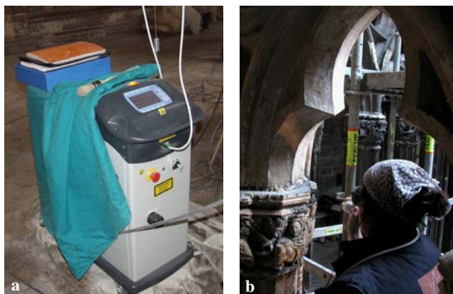
Figura 7. Limpieza láser. a) Equipo utilizado. b) Detalle de la limpieza de un capitel.
