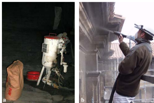
Figura 6. Limpieza con microabrasivos. a) Uno de los equipos utilizados. b) Proceso de limpieza en el claustro alto.
