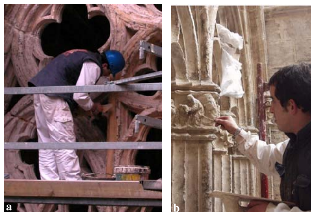
Figura 9. a) Reintegración con mortero en las tracerías de los ventanales. b) Sellado de escamas y microfisuras en un capitel.
